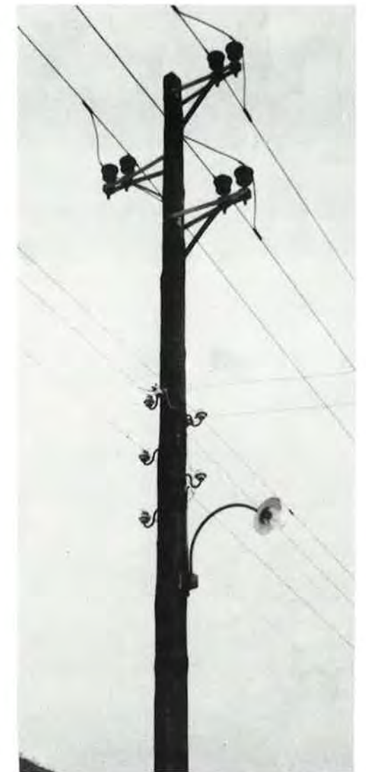
Nekadašnja mreža 10 kV i 0,4 kV na istom stupu sa javnom rasvjetom
