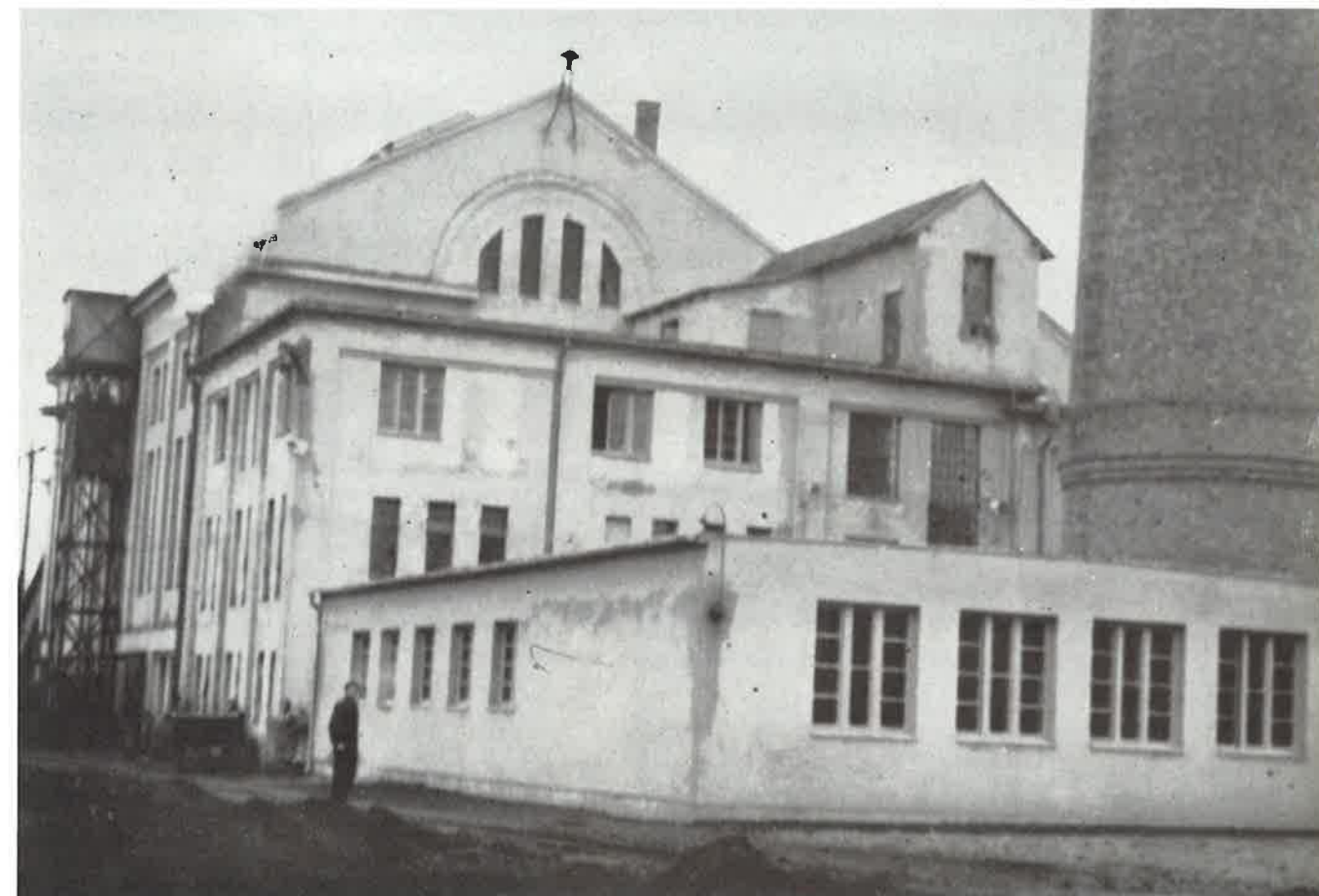
Zgrada termoelektrane Osijek preuređena je za potrebe postrojenja za toplifikaciju grada
