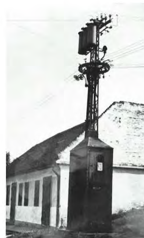
Trafostanica 6/0,4 kV iz prvih dana elektrifikacije Vukovara
