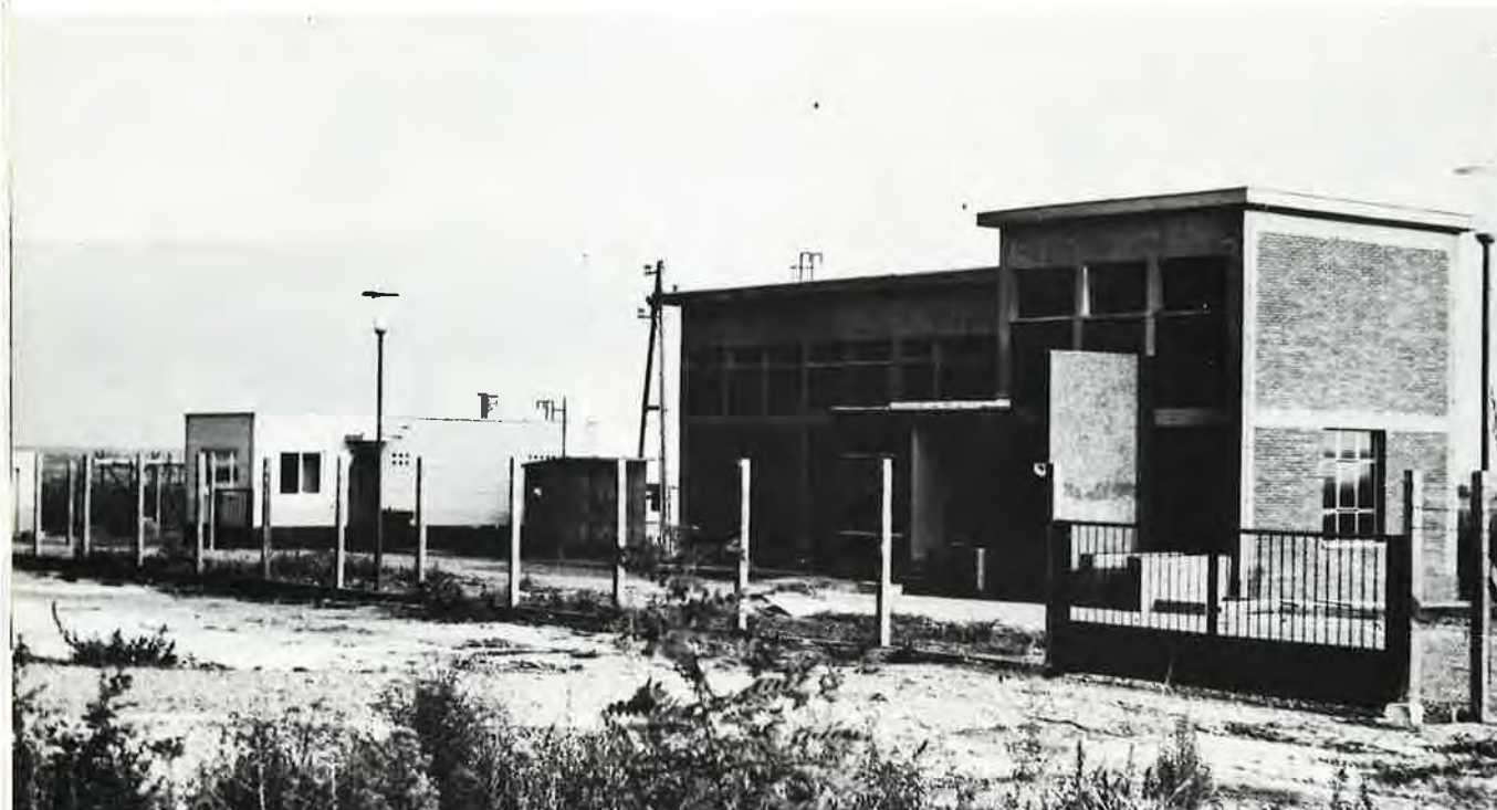
Trafostanica 35/10 kV Dalj
