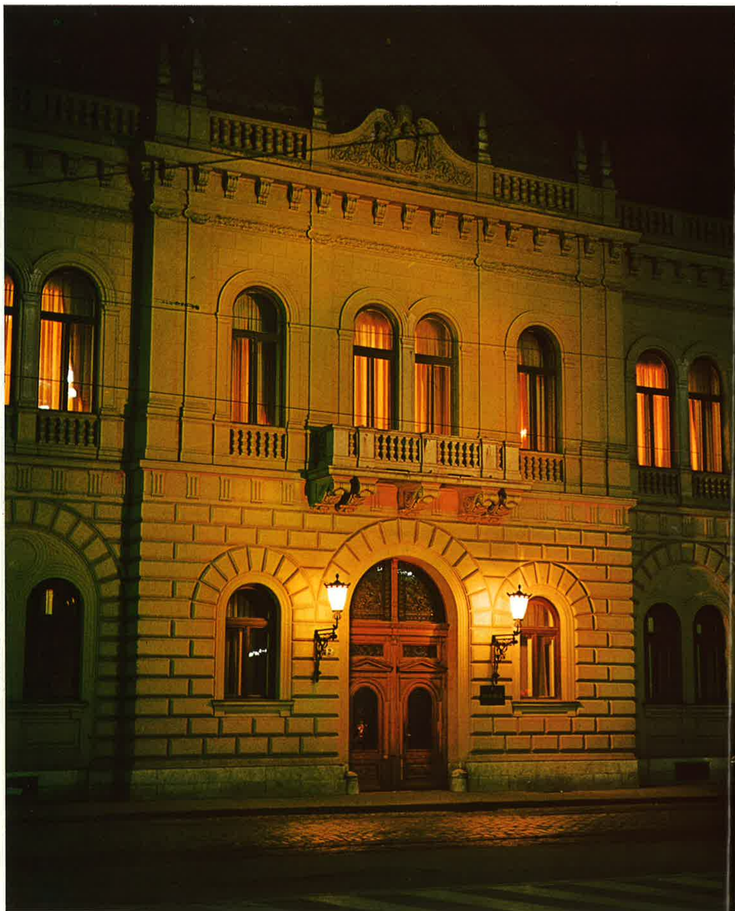
Zgrada predsjedništva Općinske skupštine u Osijeku
