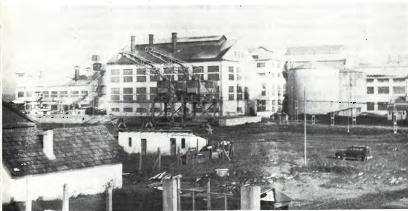
Gradnja termoelektrane Županja, koja je puštena u rad 1954. godine
