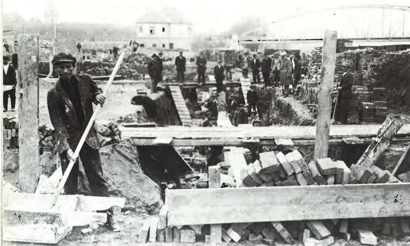
Izgradnja temelja termoelektrane Osijek 1924. godine
