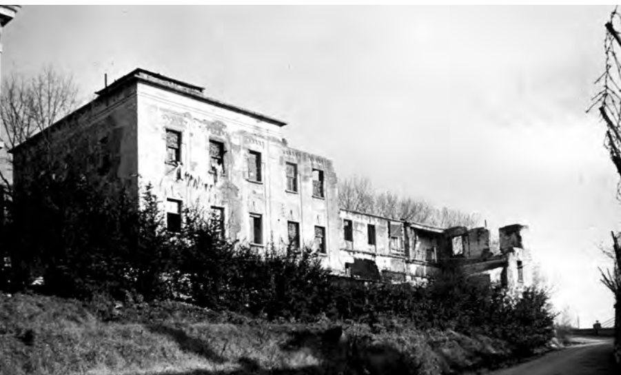
"Hollywood" - ruševna zgrada između zgrade fakulteta i prilaznog puta koja je uklonjena 1968. godine
