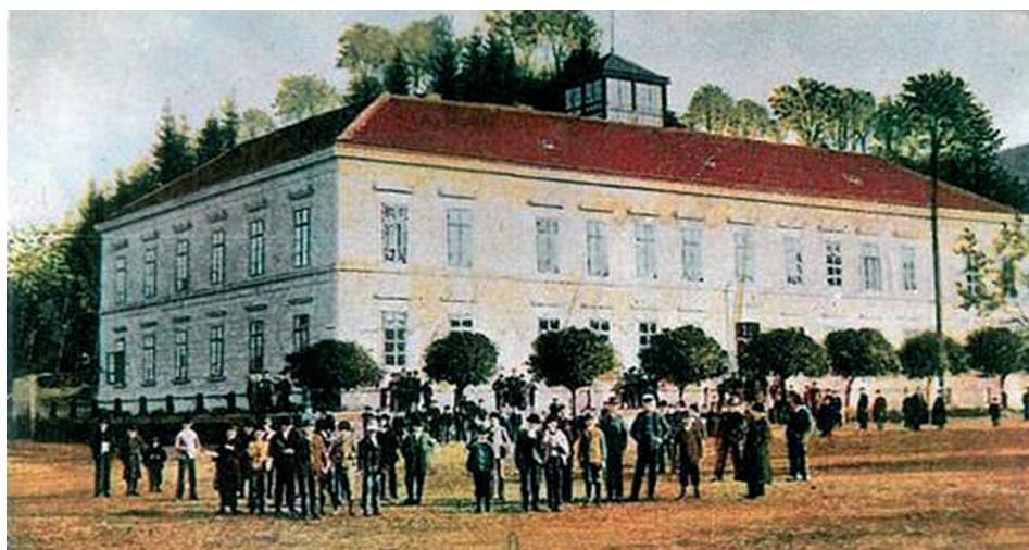
Sl. 2.: Zgrada požeške gimnazije sa svjetlarnikom
