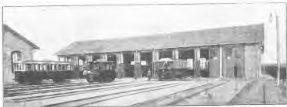
Sl. 76 Tramvajska remiza.
