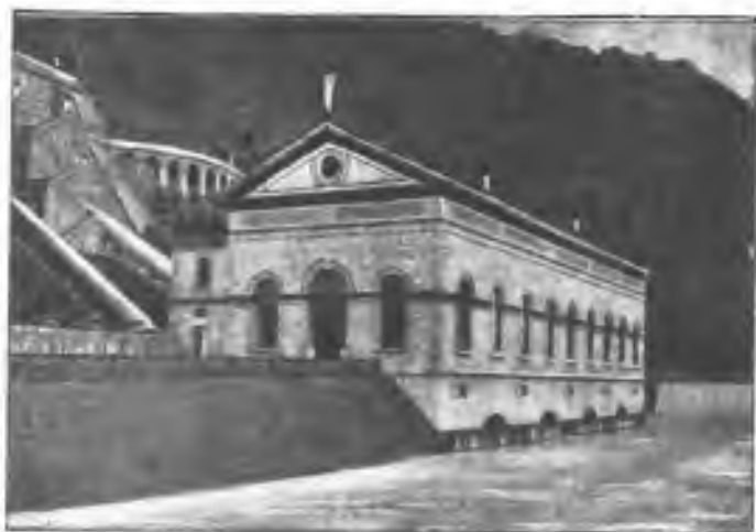
Sl. 82 Hidroelektrična centrala „Valtellina“ željeznice.
