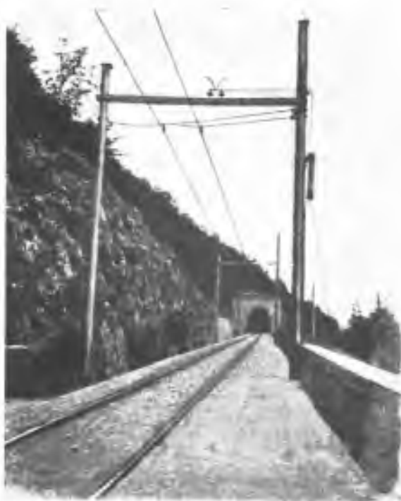
Sl. 83. Žicovod „Valtellina“ željeznice sa munjovodom.
