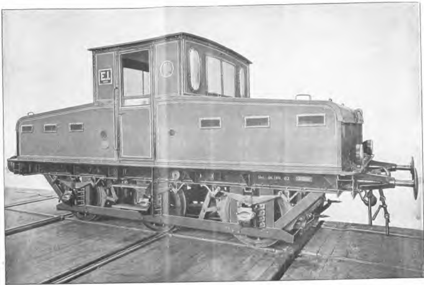
Sl. 88. Električna lokomotiva sa akumulatorima.
