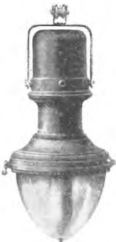
Sl. 22. Ganzova trajno goruća lampa za struju istoga smjera.
