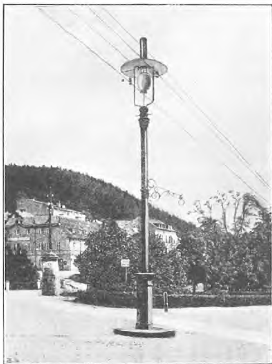
Sl. 25. Ulična plamena lampa u Marienbadu na željeznom stupu.
