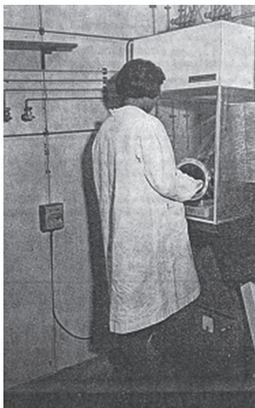
Sl. 3.: Nanošenje fotoemulzije
