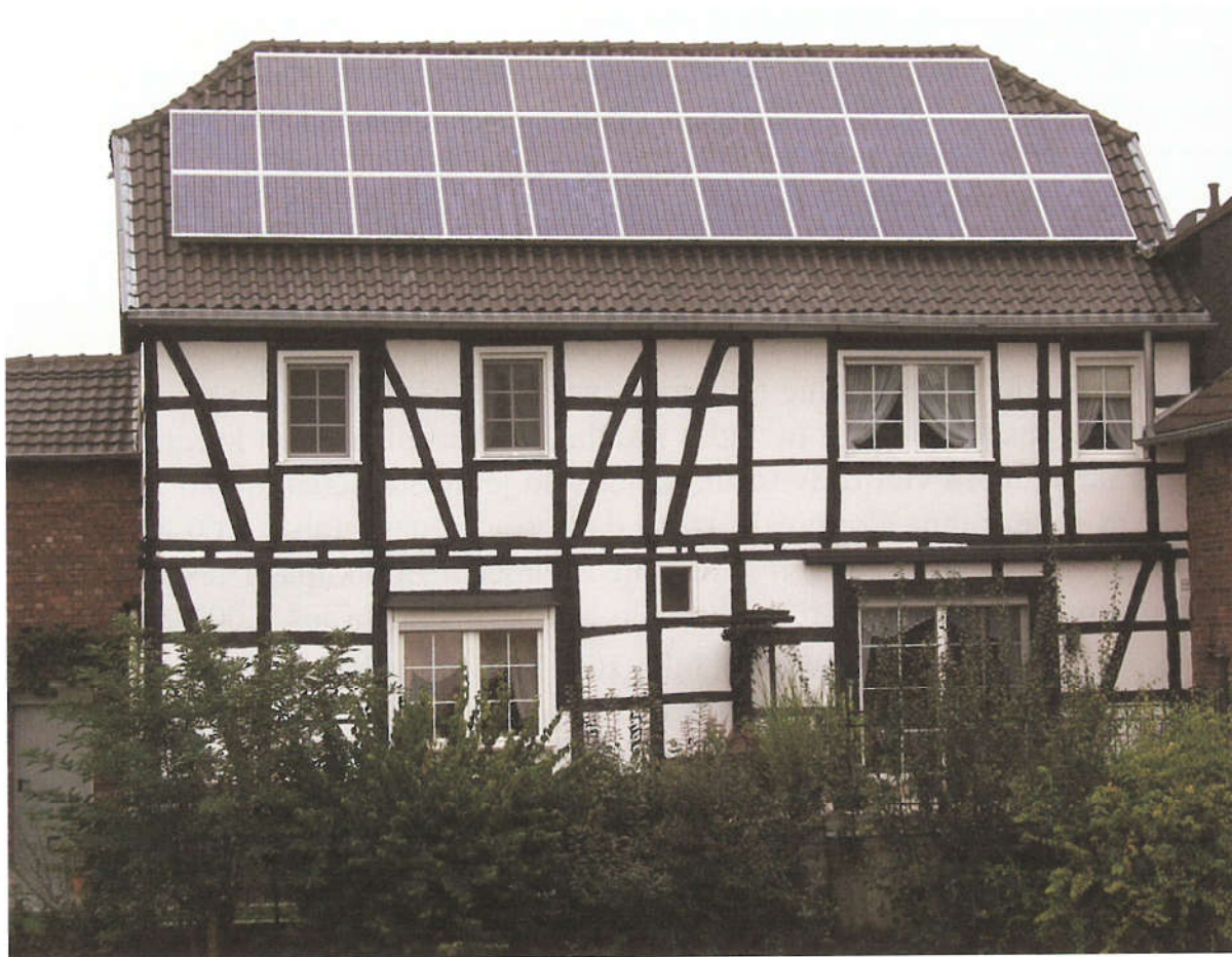
Fotonaponski moduli na krovu jedne stare kuće
