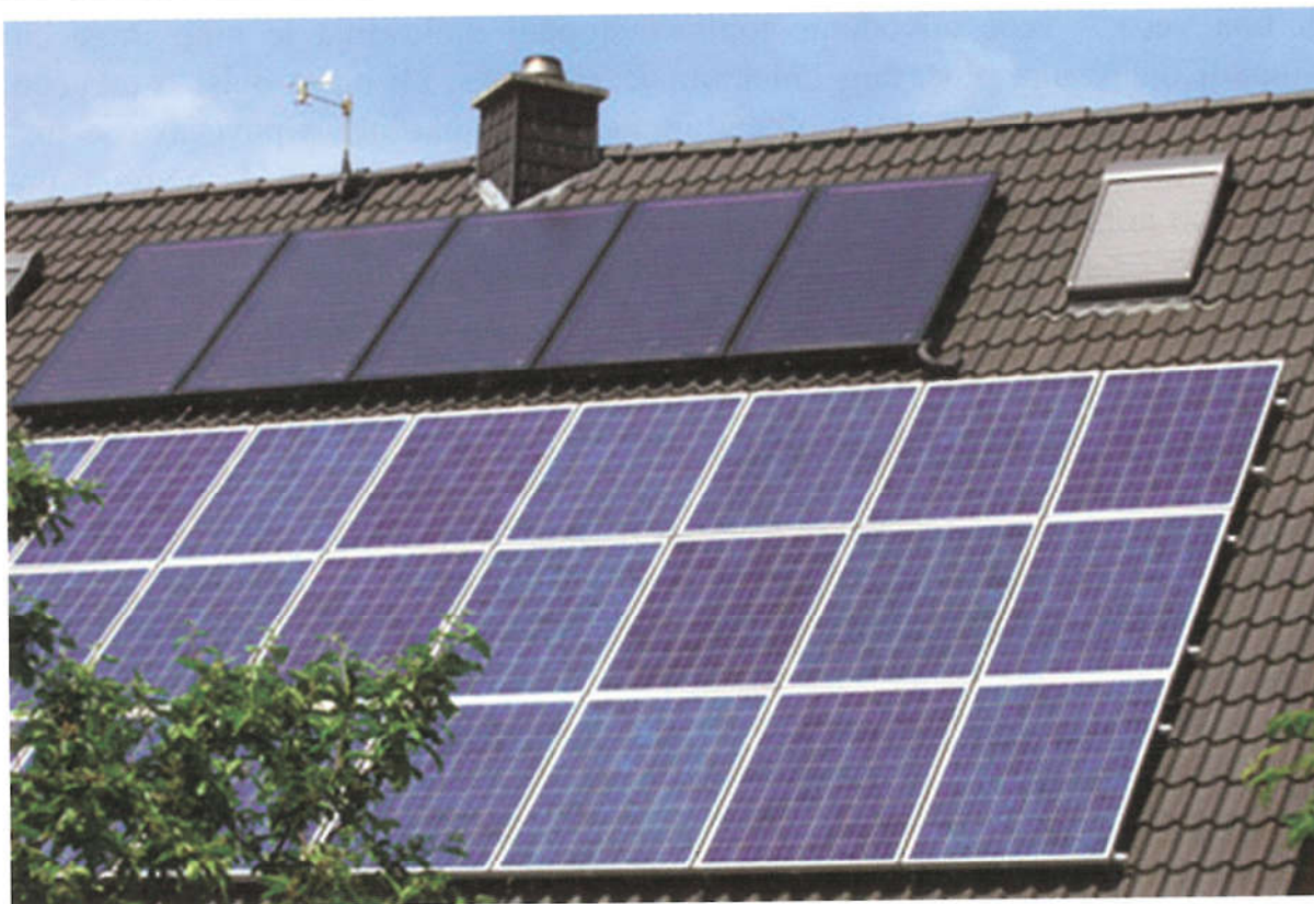
Kolektori i fotonaponski moduli na krovu jedne njemačke kuće
