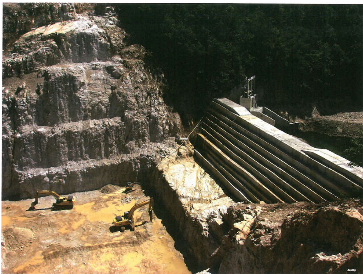
Izgradnja brane HE Lešće snage 42,3 MW
