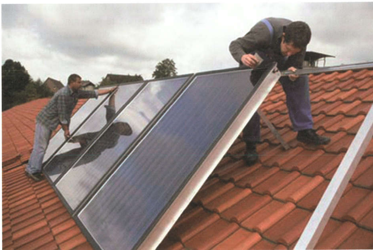
Montaža kolektora na krovu jedne njemačke kuće
