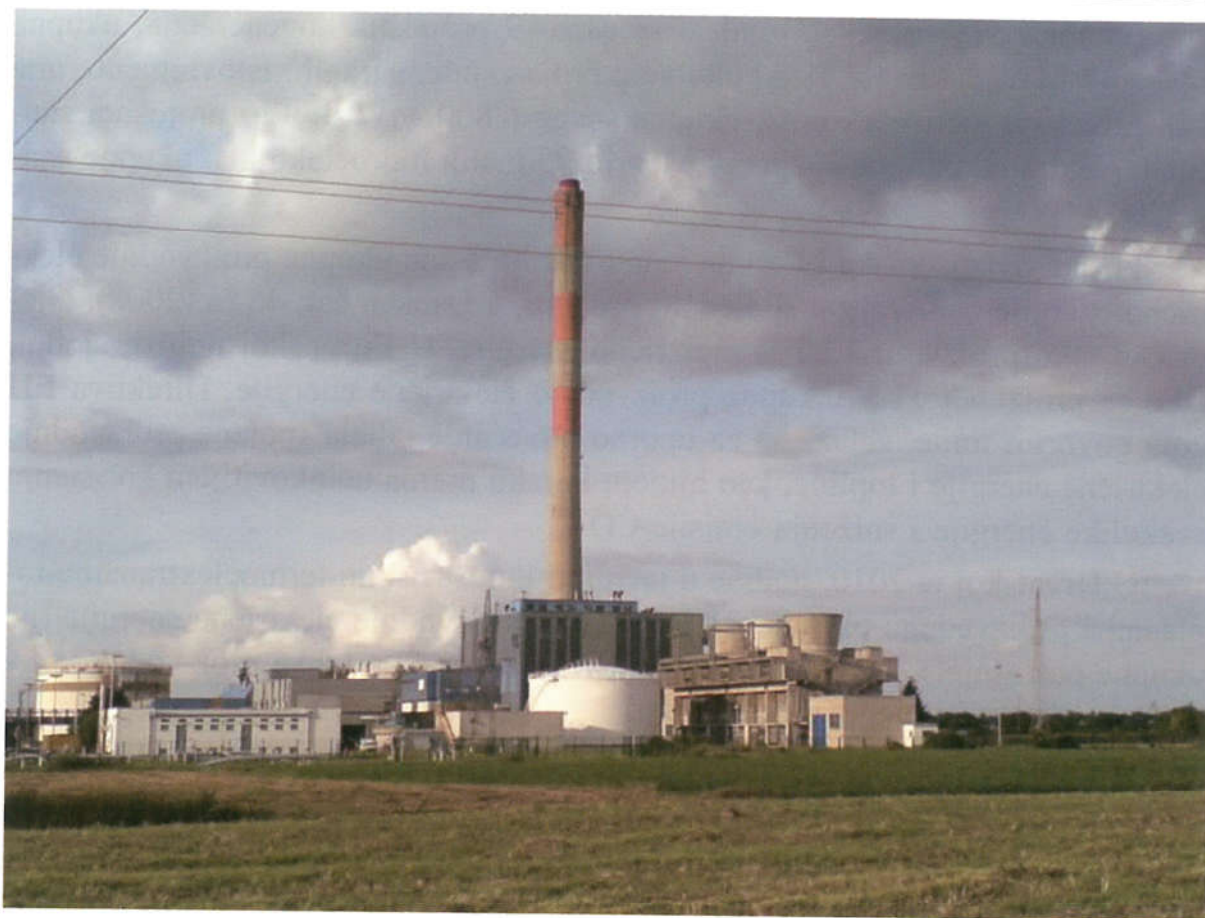
Termoelektrana-toplana Osijek, 45 MW električne i 110 MW toplinske snage
