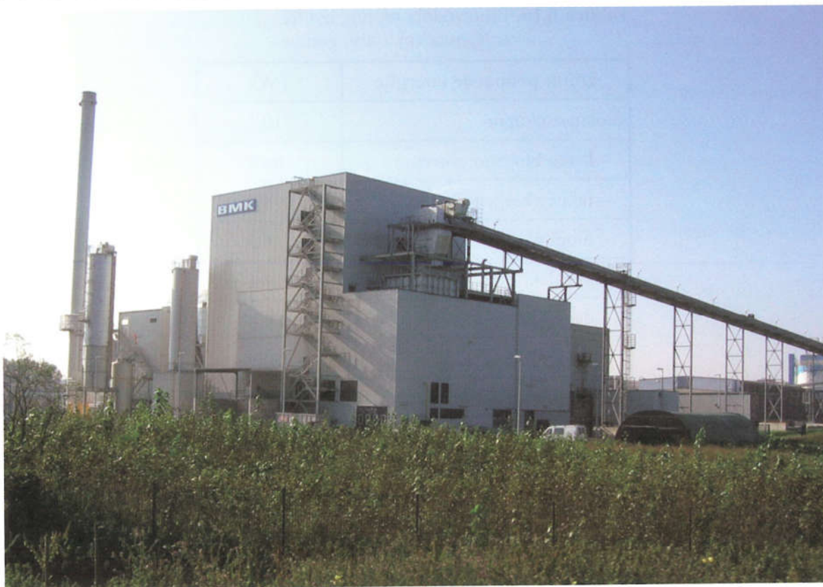
Elektrana na biomasu Lünen, 20 MW
