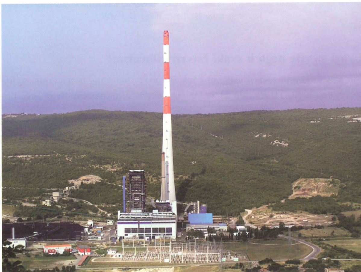
Termoelektrana Plomin 2 snage 210 MW
