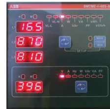
Slika 12.10. Prikaz nesimetričnosti trofaznog sustava kućnog napajanja na jednom katu FER-a
