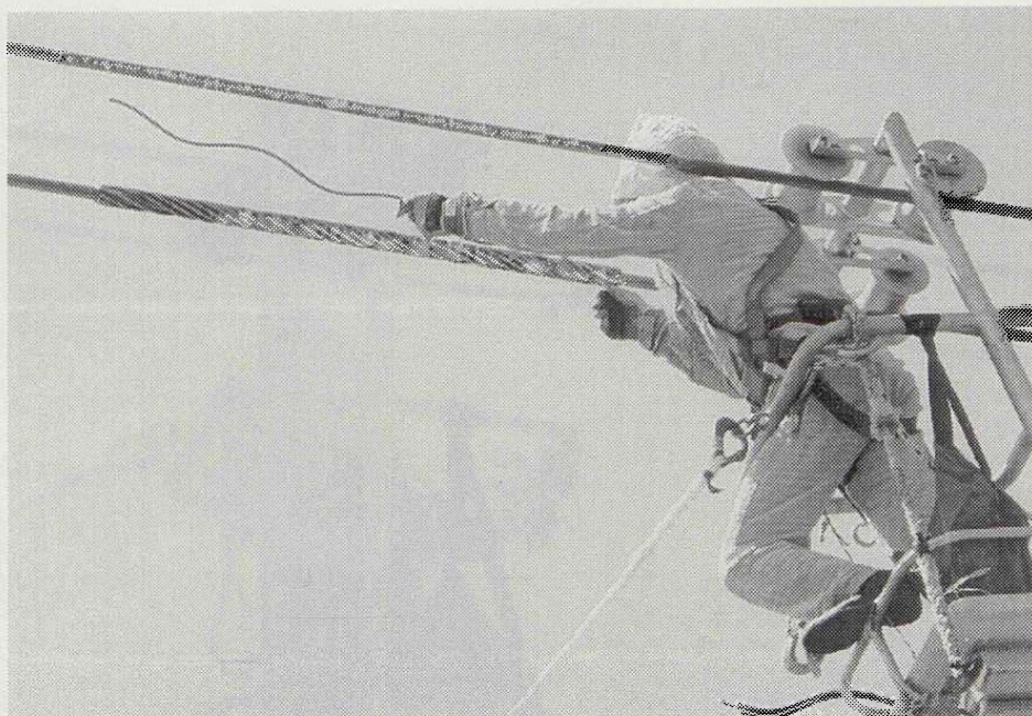
Slika 7. Popravak vodiča popravnom spiralom
