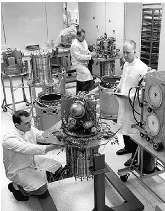
Slika 19. Tehničari tvrtke Pratt & Whitney sastavljaju alkalne gorivne ćelije za Apollo servisne module [31]
