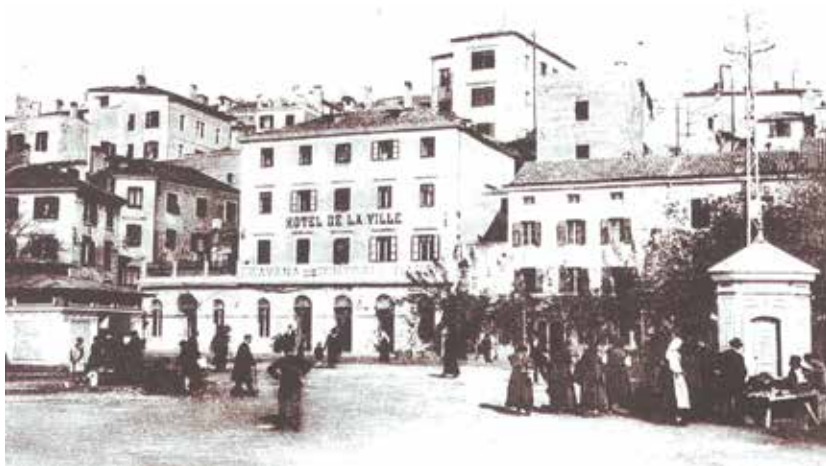
Slika 11.: Transformatorska stanica na šibenskoj obali
