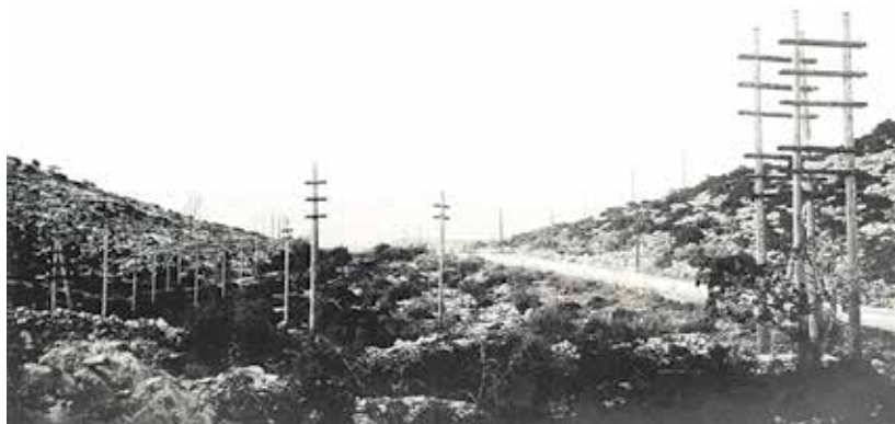
Slika 10.: Izgradnja stupova dalekovoda prema Šibeniku
