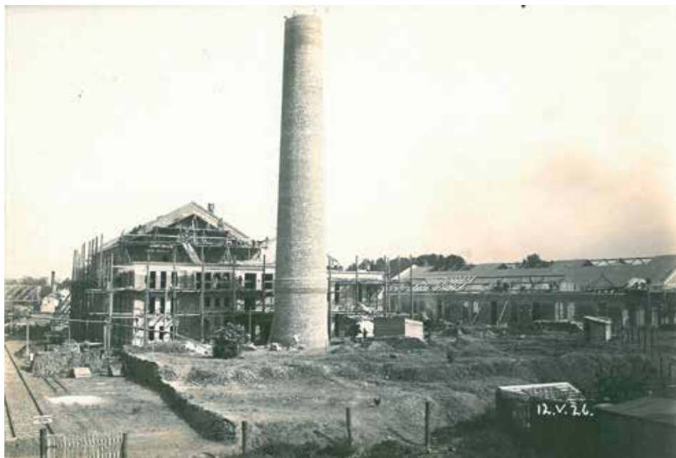
Slika 4.: Gradilište osječke elektrane, 12. svibnja 1926. (pogled sa zapada)
