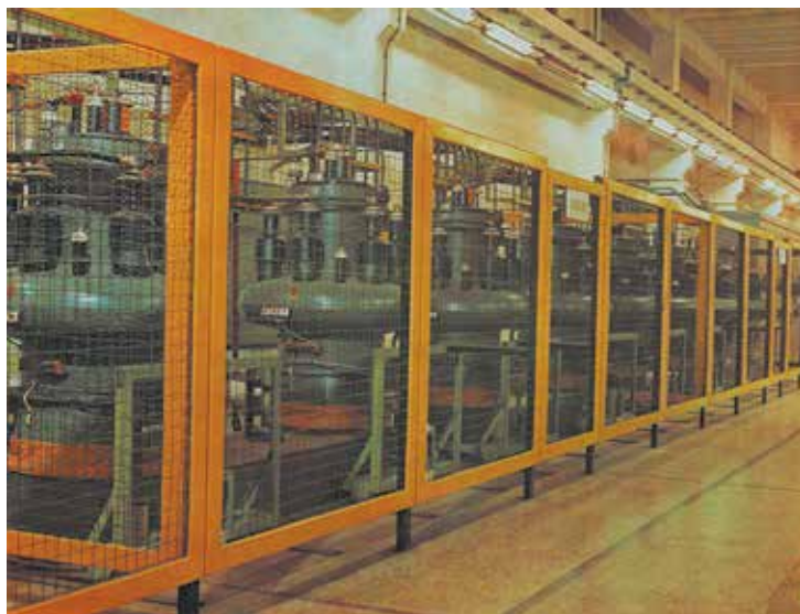
Slika 15.: Šestoanodni živini ventili u Željezari Ravne na Koroškem za napajanje četiri valjačka motora snage 660 kW, 1962. ( Rade Končar )
