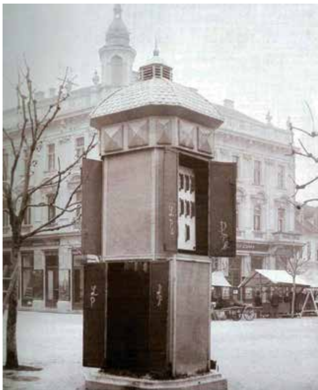
Slika 7.: Jedna od prvih transformatorskih stanica od 5 kV u Zagrebu
