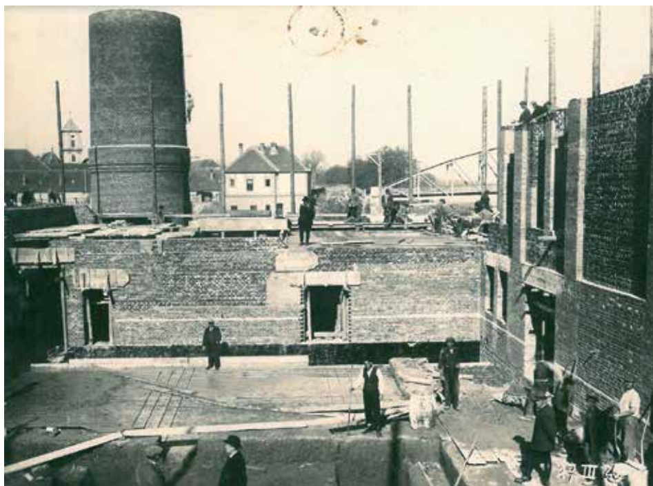
Slika 3.: Stanje na gradilištu 27. ožujka 1926. (pogled s istoka)
