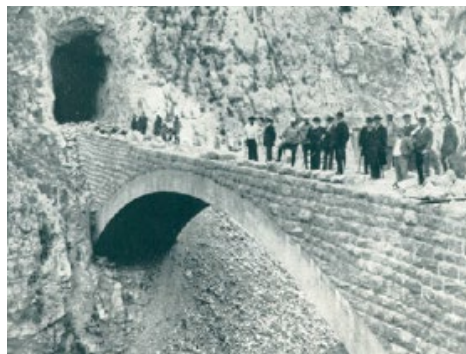
Sl. 22. Most na pruzi Niš-Knjaževac u doba izgradnje [12]
