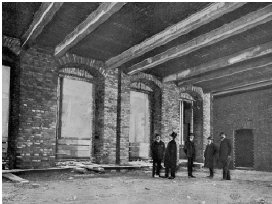
Slika 15. Nadgledanje izvođenja tavanice u tvorničkom objektu od strane predstavnika poduzeća baruna Pitela [12]
