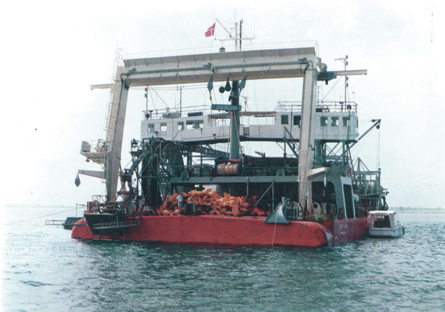
Polaganje 110 kV podmorskog kabela od otoka Paga do kopna u okolini Nina prilikom izgradnje sustava tzv. »Otočne veze« u ljeto 1994. godine. Fotografija A. Travirka.
