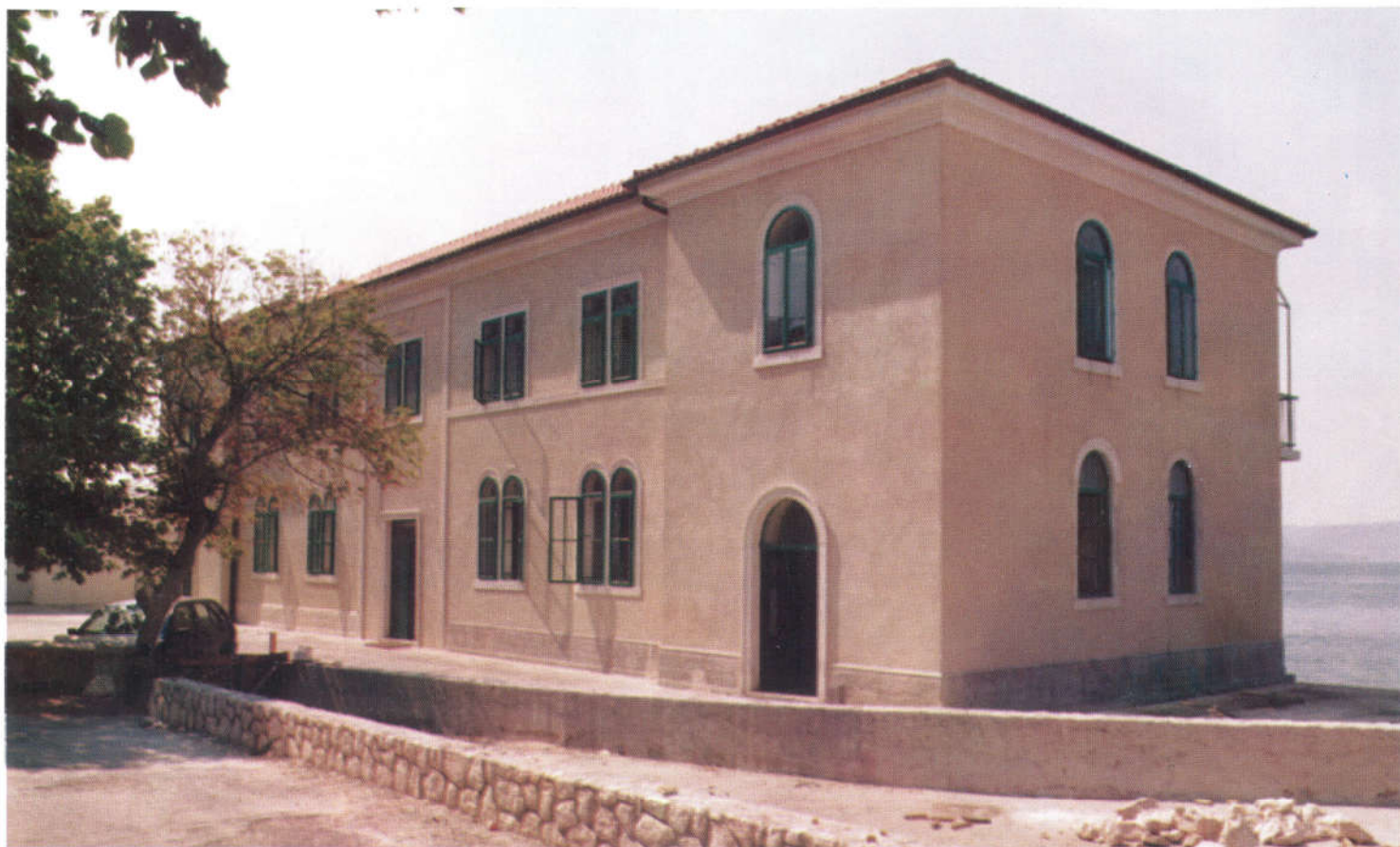
Obnovljena upravna zgrada zadarske ELEKTRE lijep je primjer utilitarne arhitekture s kraja prošlog stoljeća. Fotografija A. Travirka.
