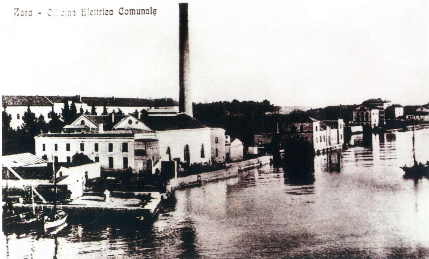
Zgrada električne centrale u Zadru oko 1910.
