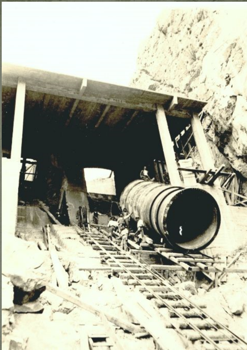
Transport dijelova tlačnih cjevoda prema vodnoj komori
