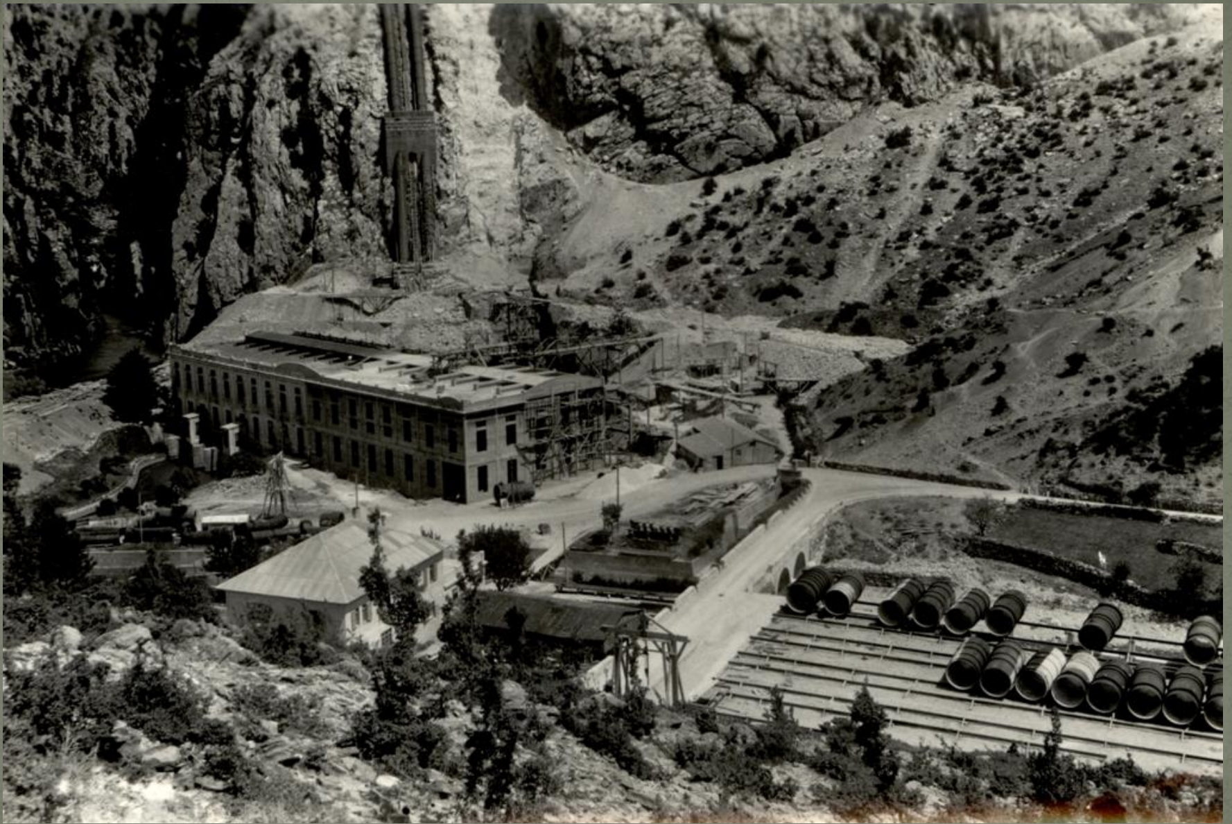
Odlaganje dijelova cjevovoda na HE Kraljevac
