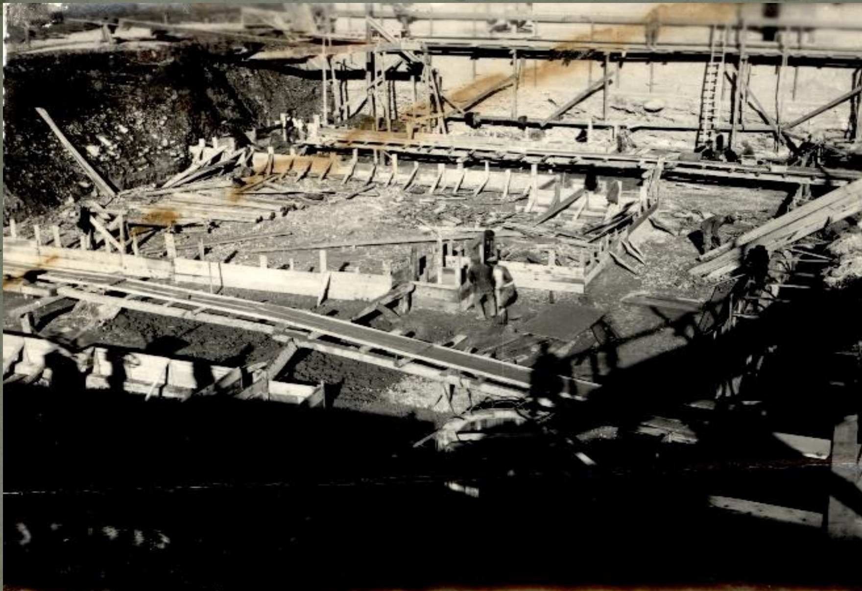
Iskop temelja za proširenje strojarnice
