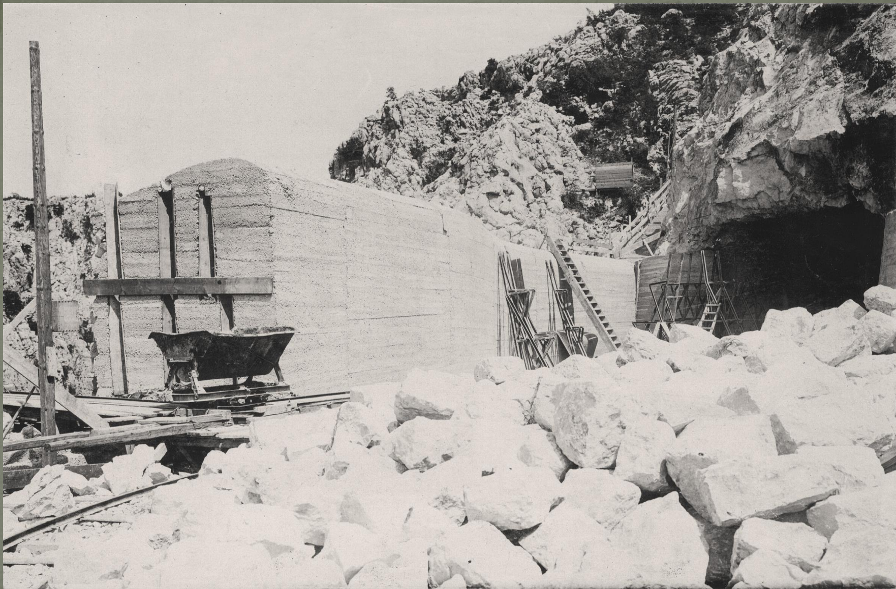
Lijevi izlaz iz tunela na vodnu komoru
