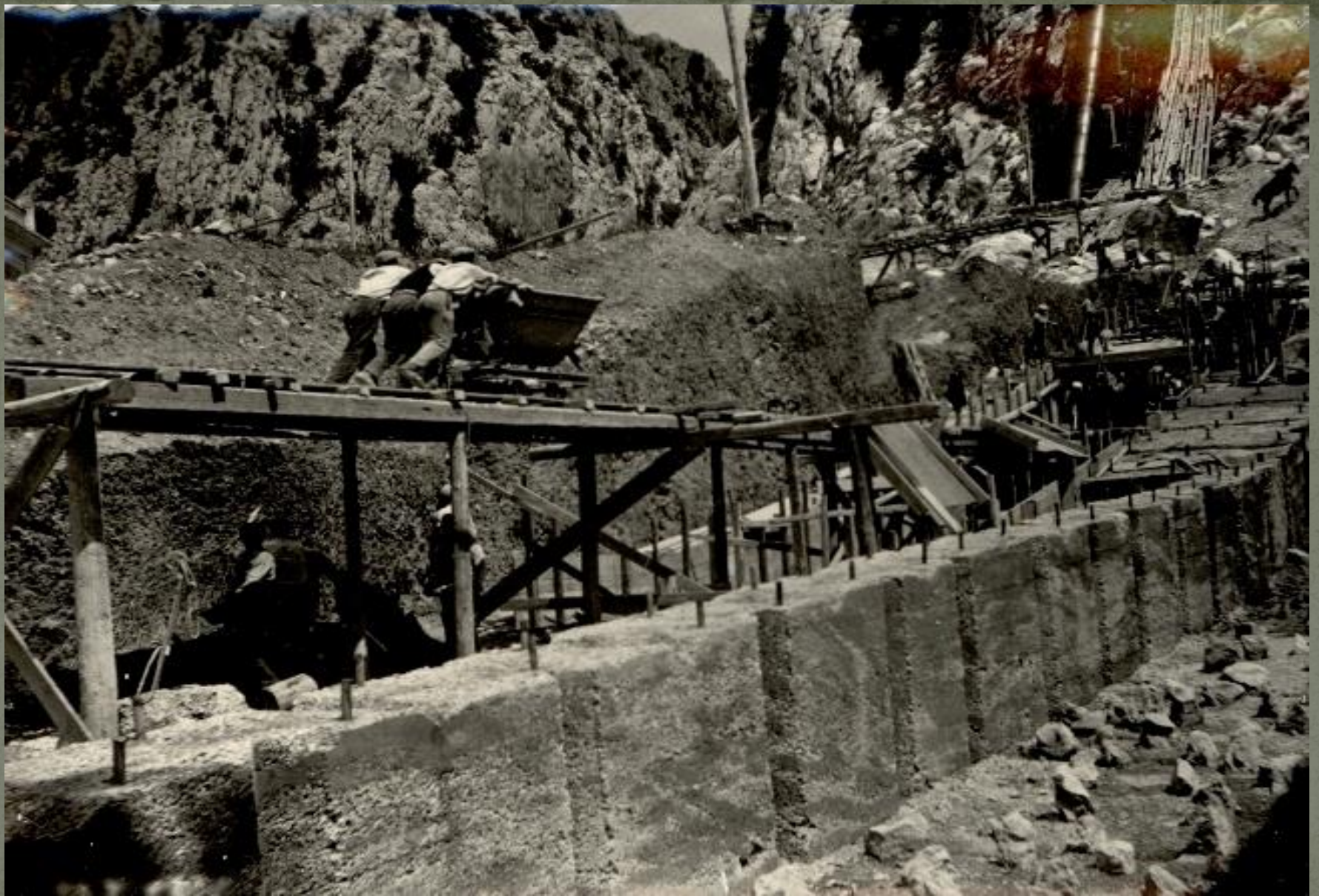
Radovi na izgradnji tlačnih cjevovoda 3 i 4
