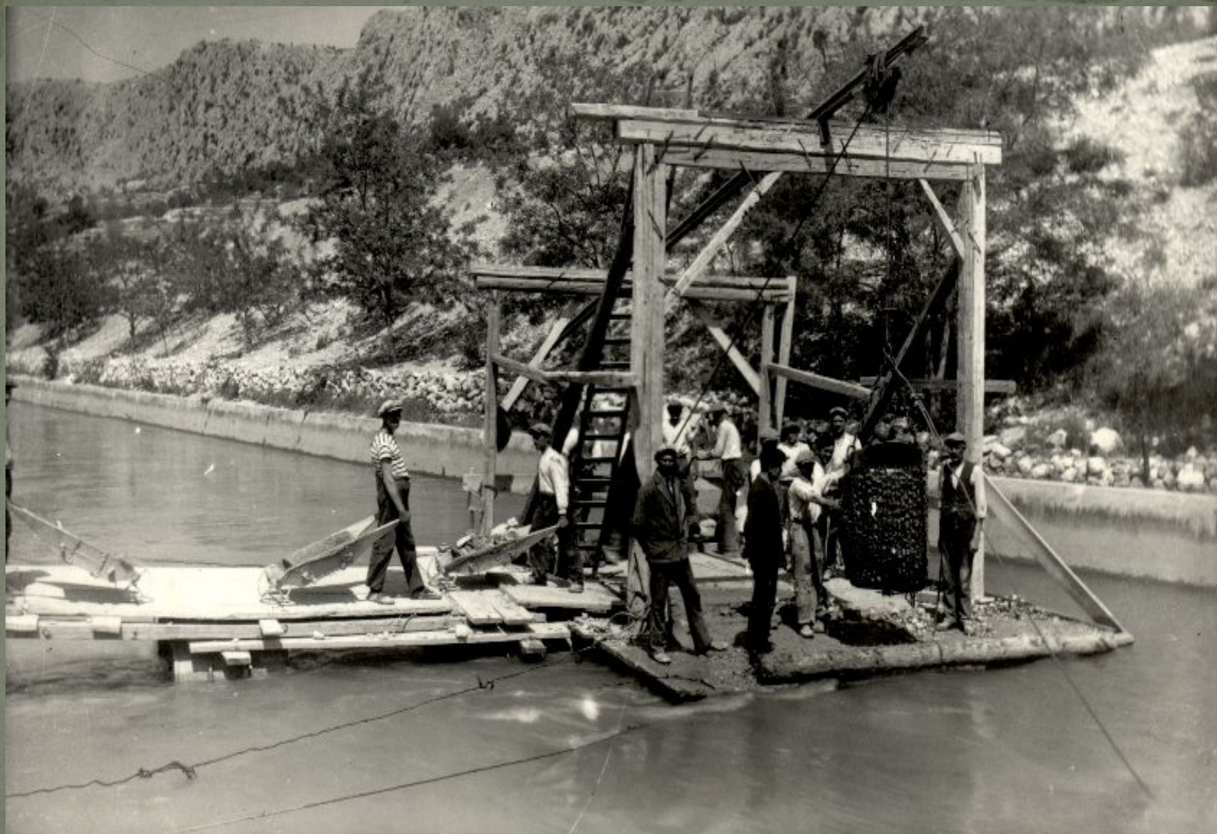
Radovi u odvodnom kanalu
