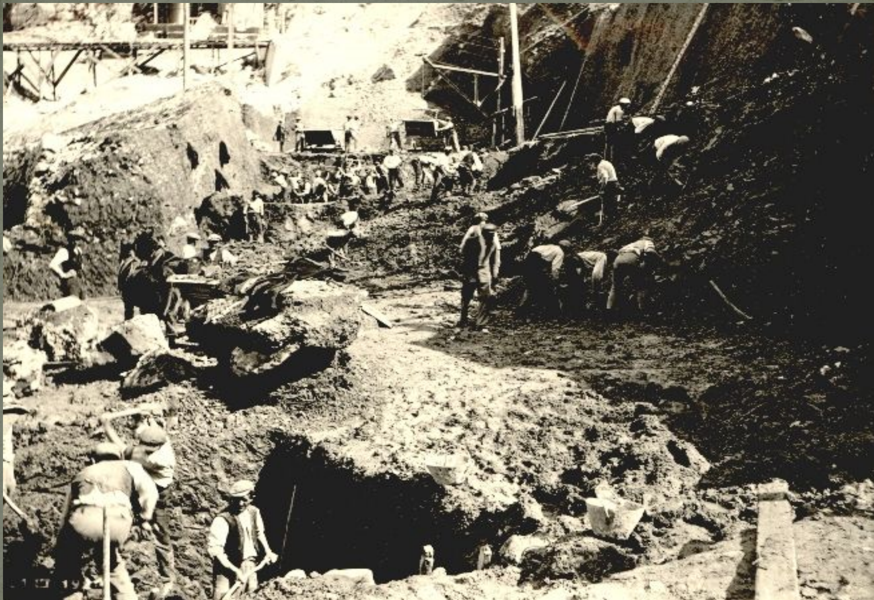
Početak radova na izgradnji tlačnih cjevovoda 3 i 4
