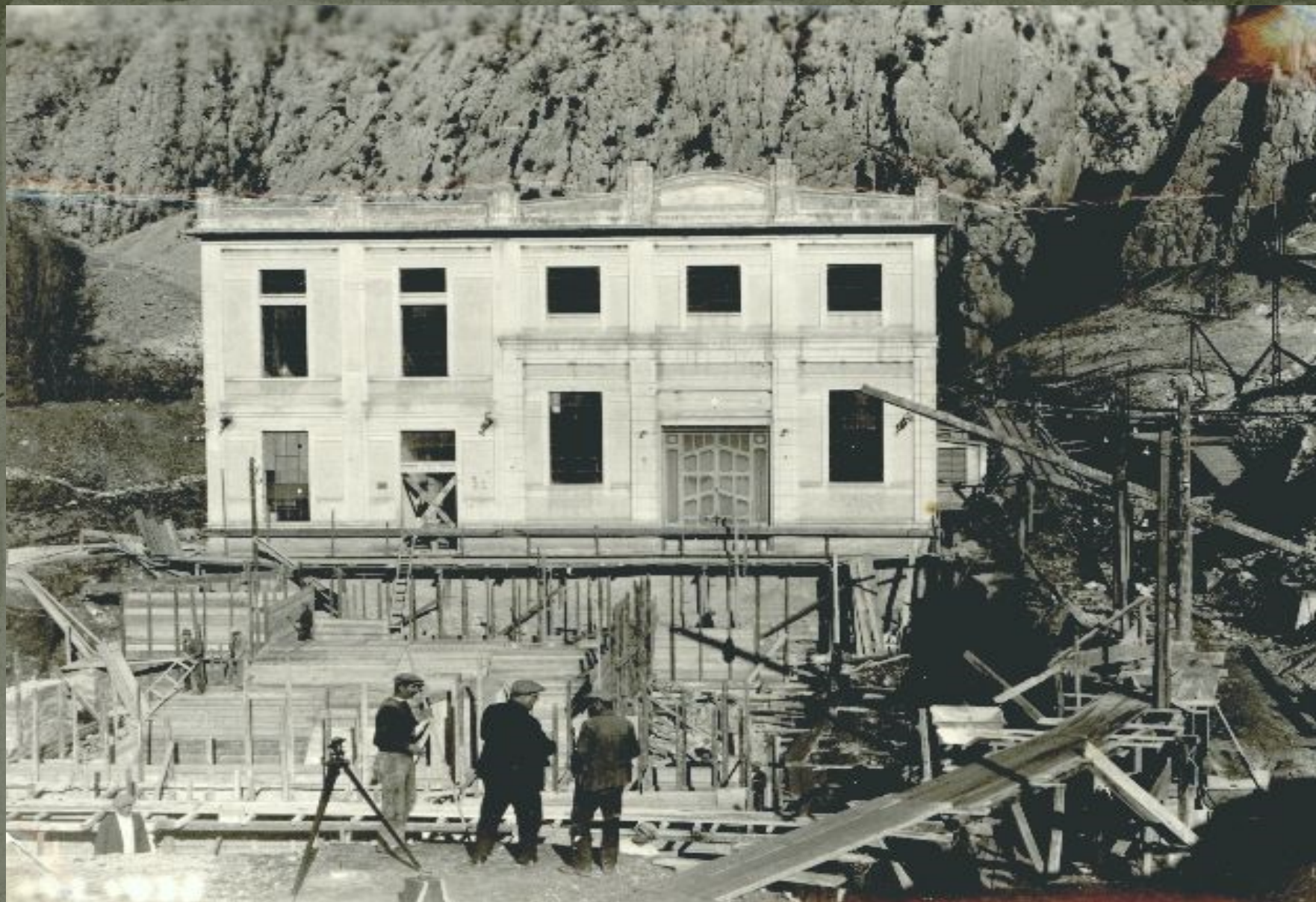
Radovi na proširenju strojarnice
