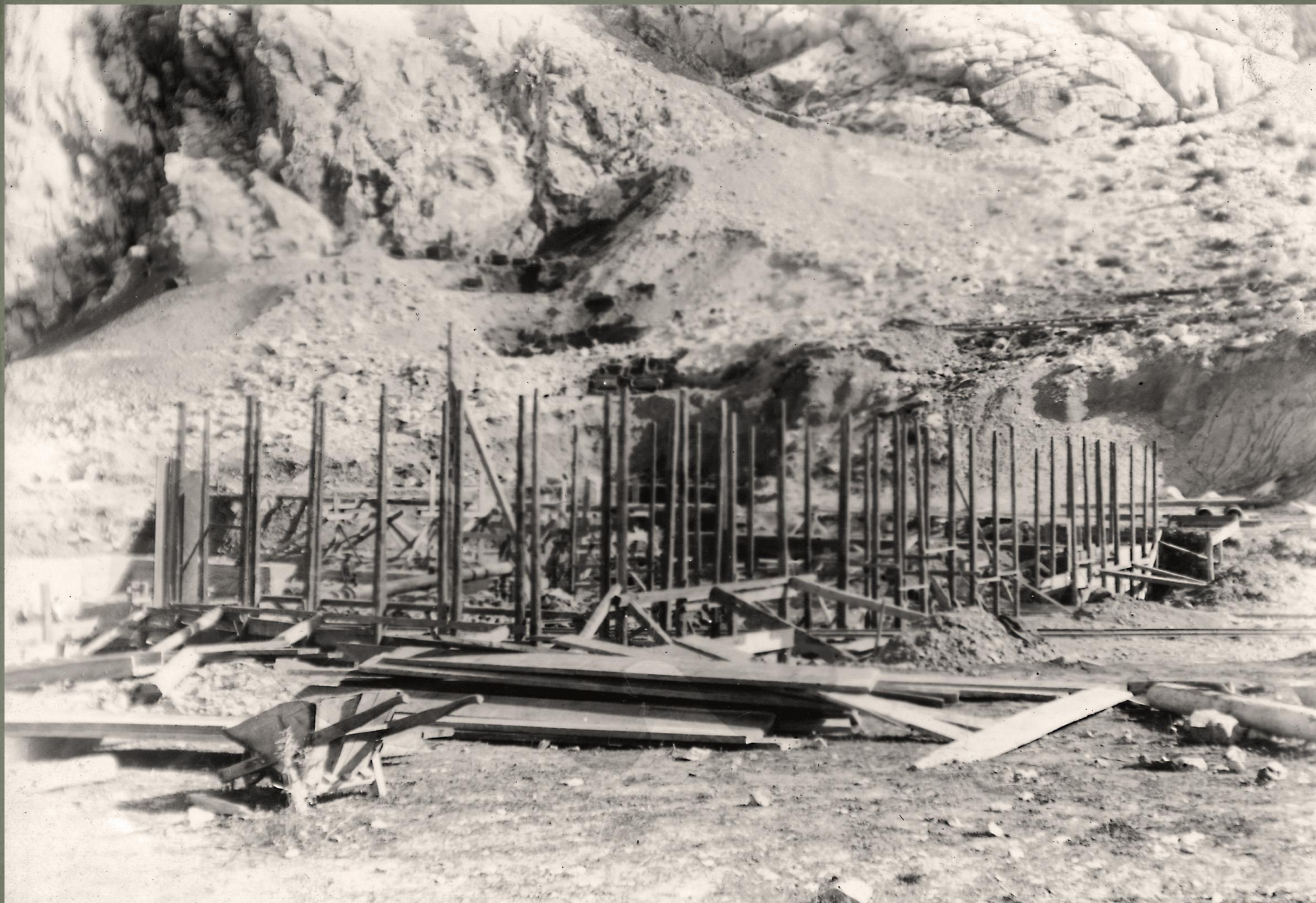
Početak radova na izgradnji strojarnice
