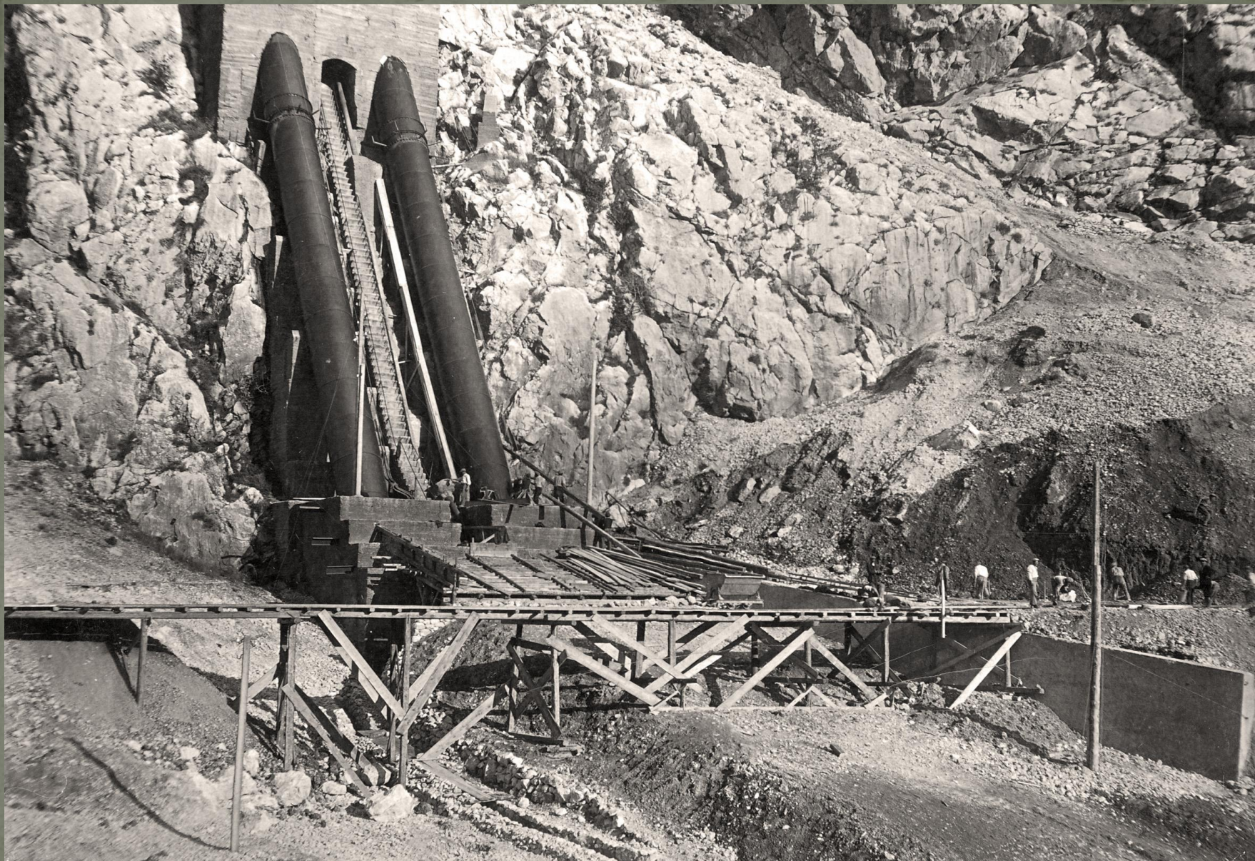
Radovi na izgradnji prva dva tlačna cjevovoda
