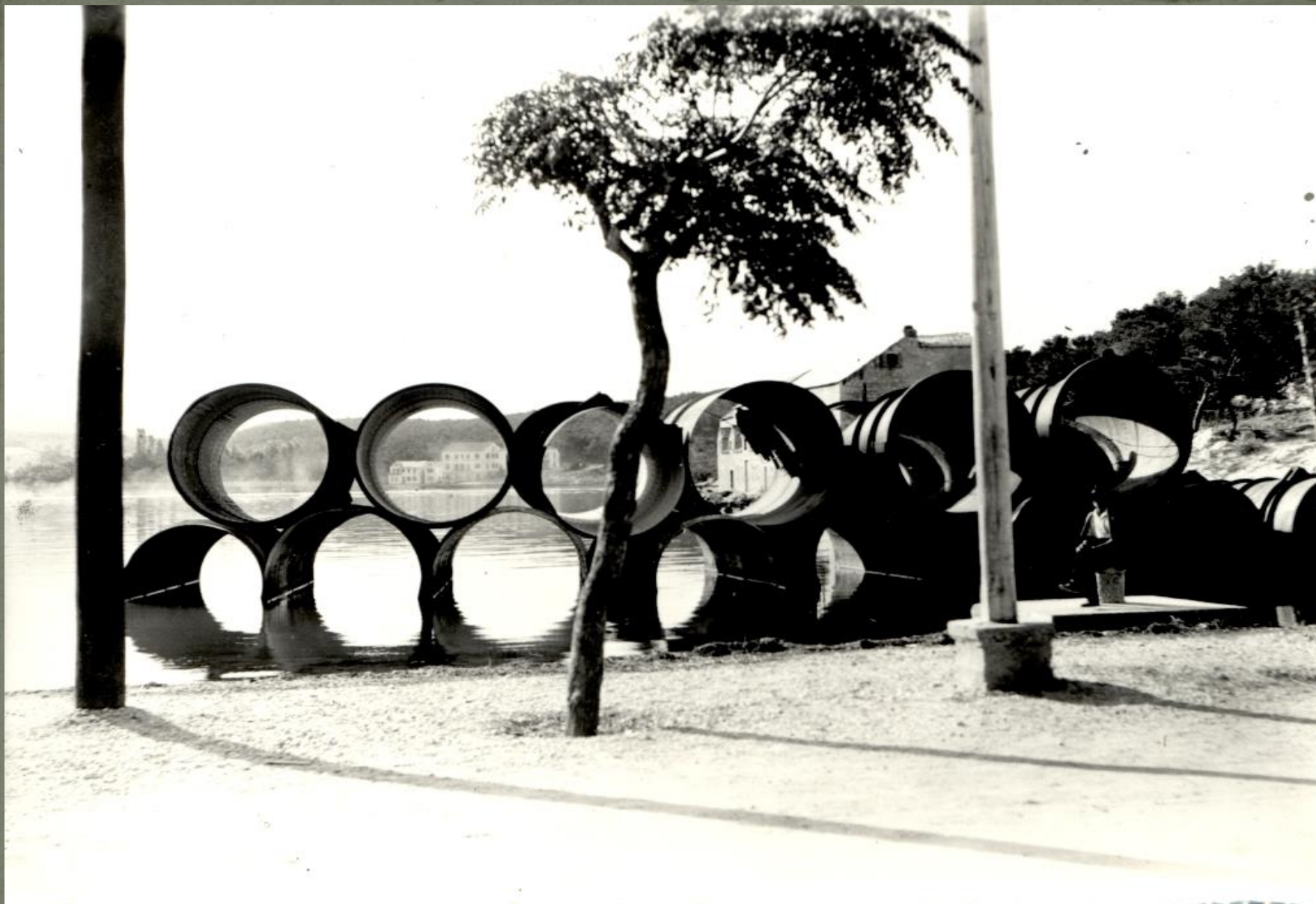
Dijelovi tlačnih cjevovoda na plaži Makarska
