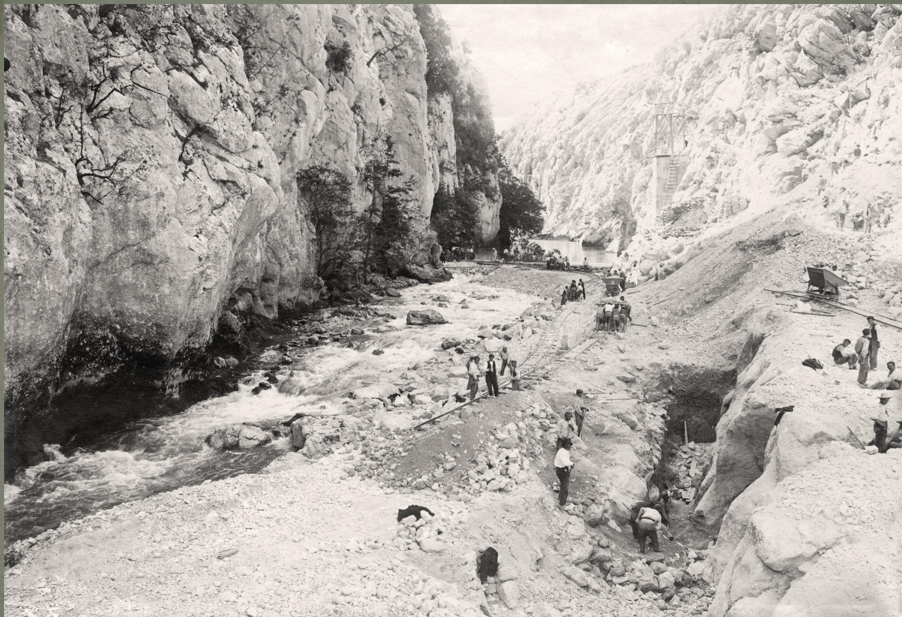
Izgradnja brane 1909. godine
