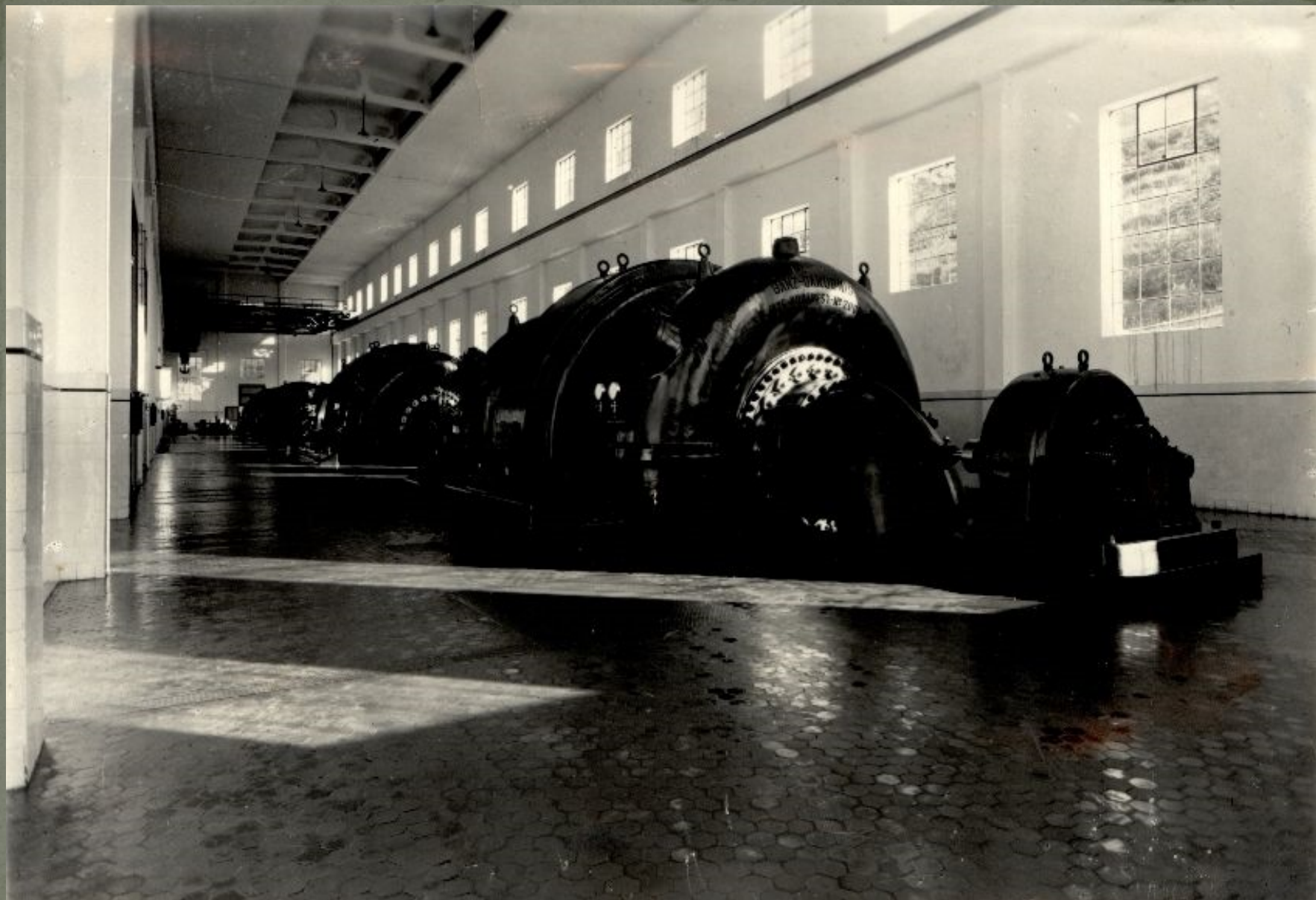
Završeni radovi montaže agregata
