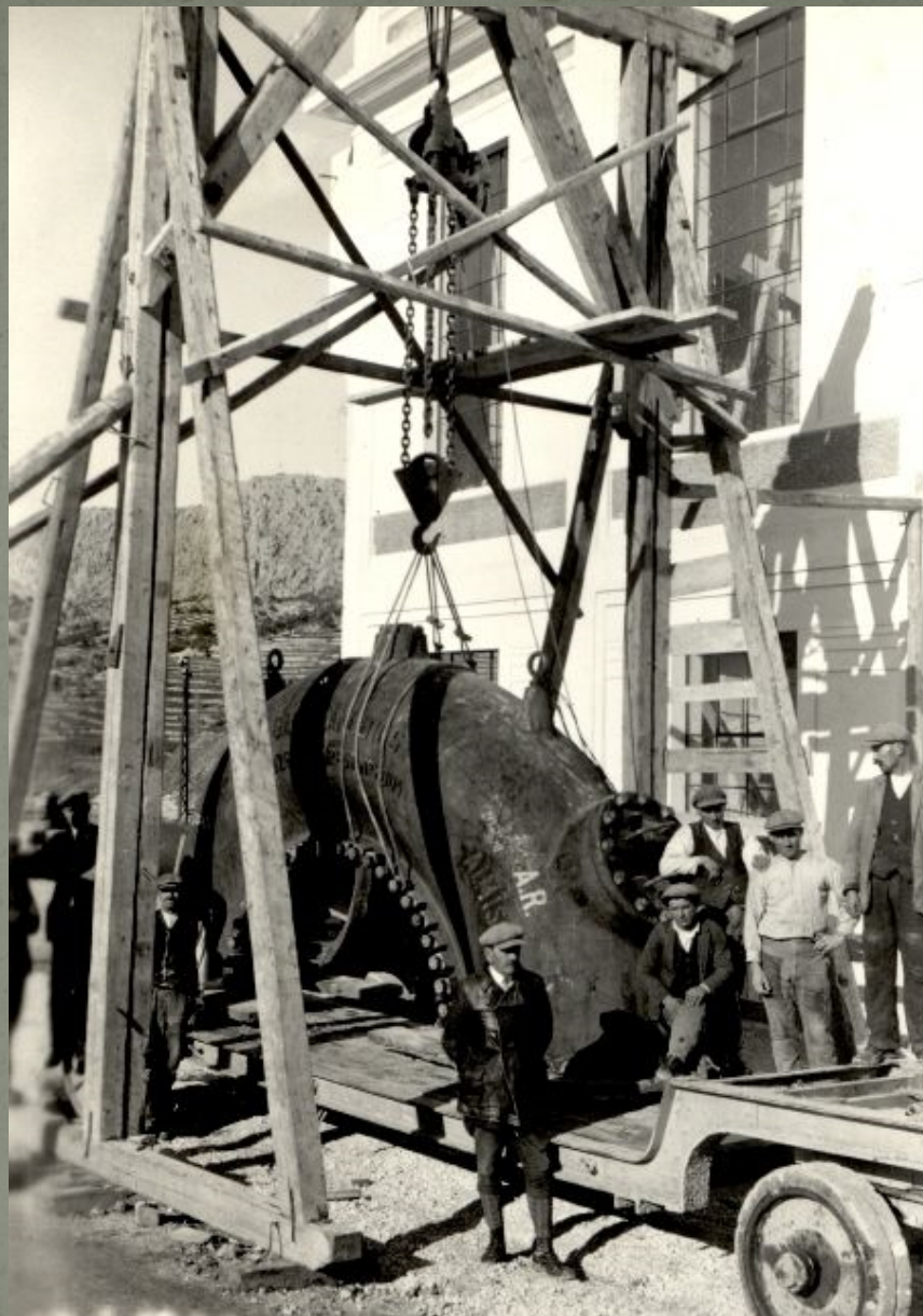
Dolazak dijelova turbina na gradilište
