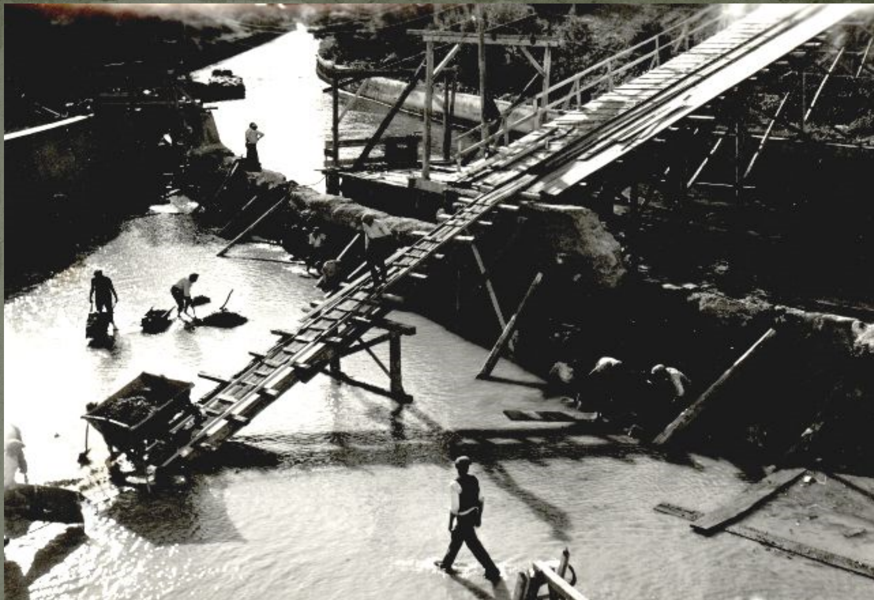
Radovi u odvodnom kanalu
