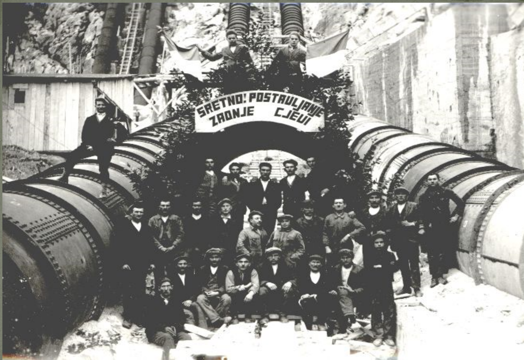
Završetak radova na izgradnji tlačnih cjevovoda 3 i 4
