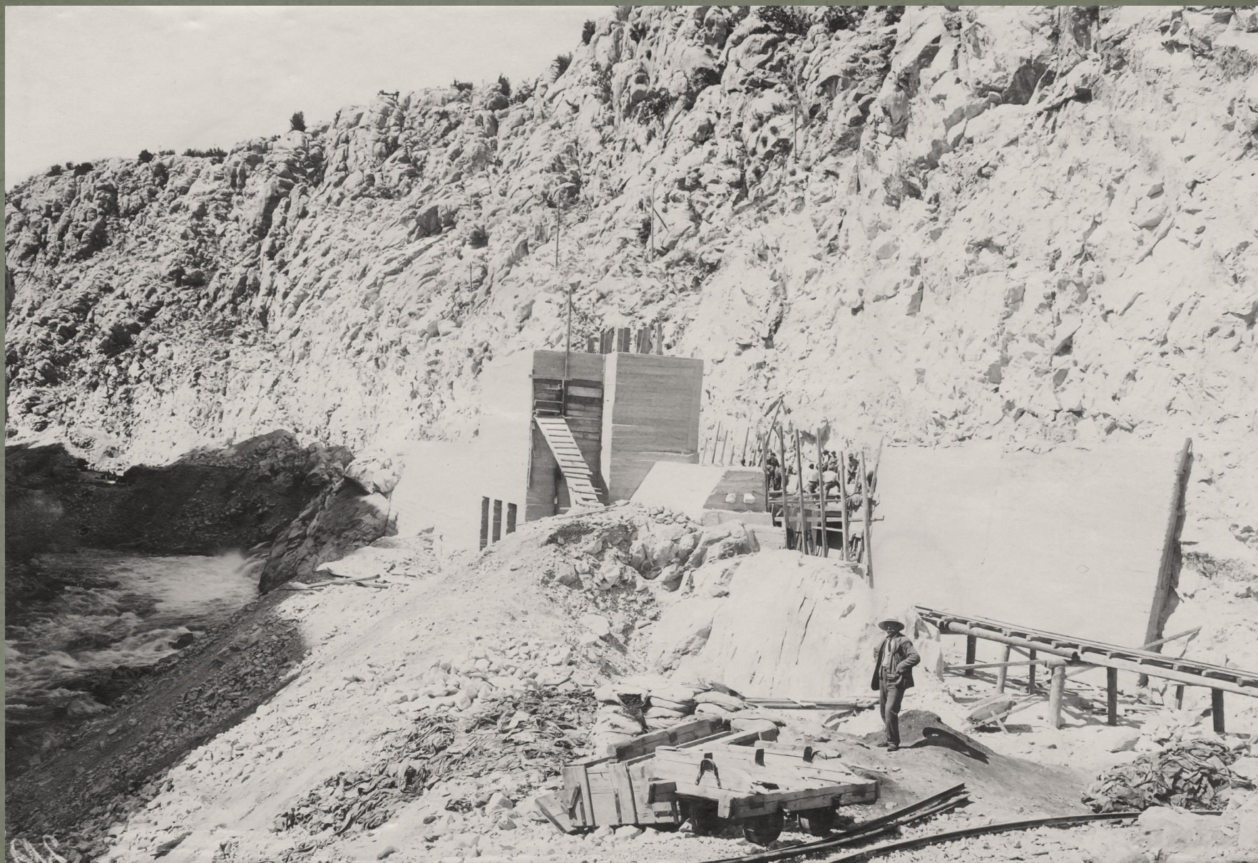
Izgradnja dovodnog kanala na brani 1909. godine
