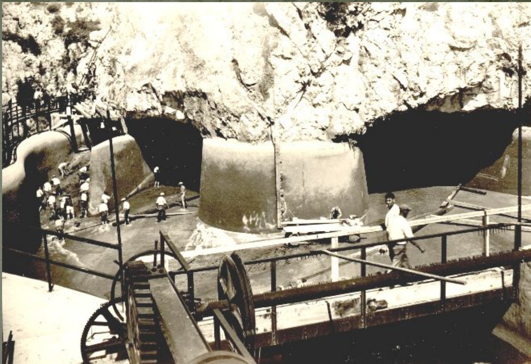
Radovi uređenja vodne komore druge etape
