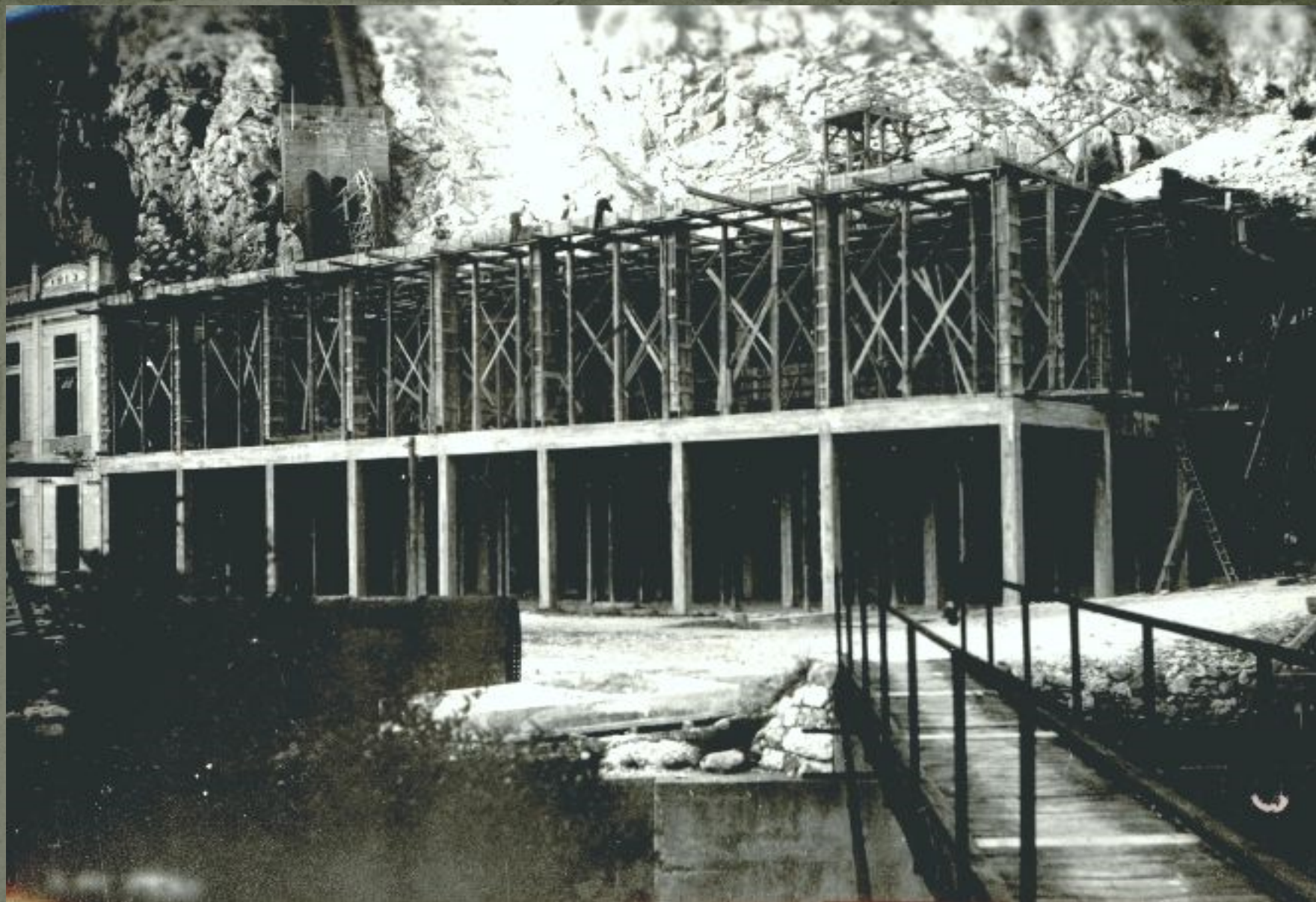
Radovi proširenja strojarnice privode se kraju
