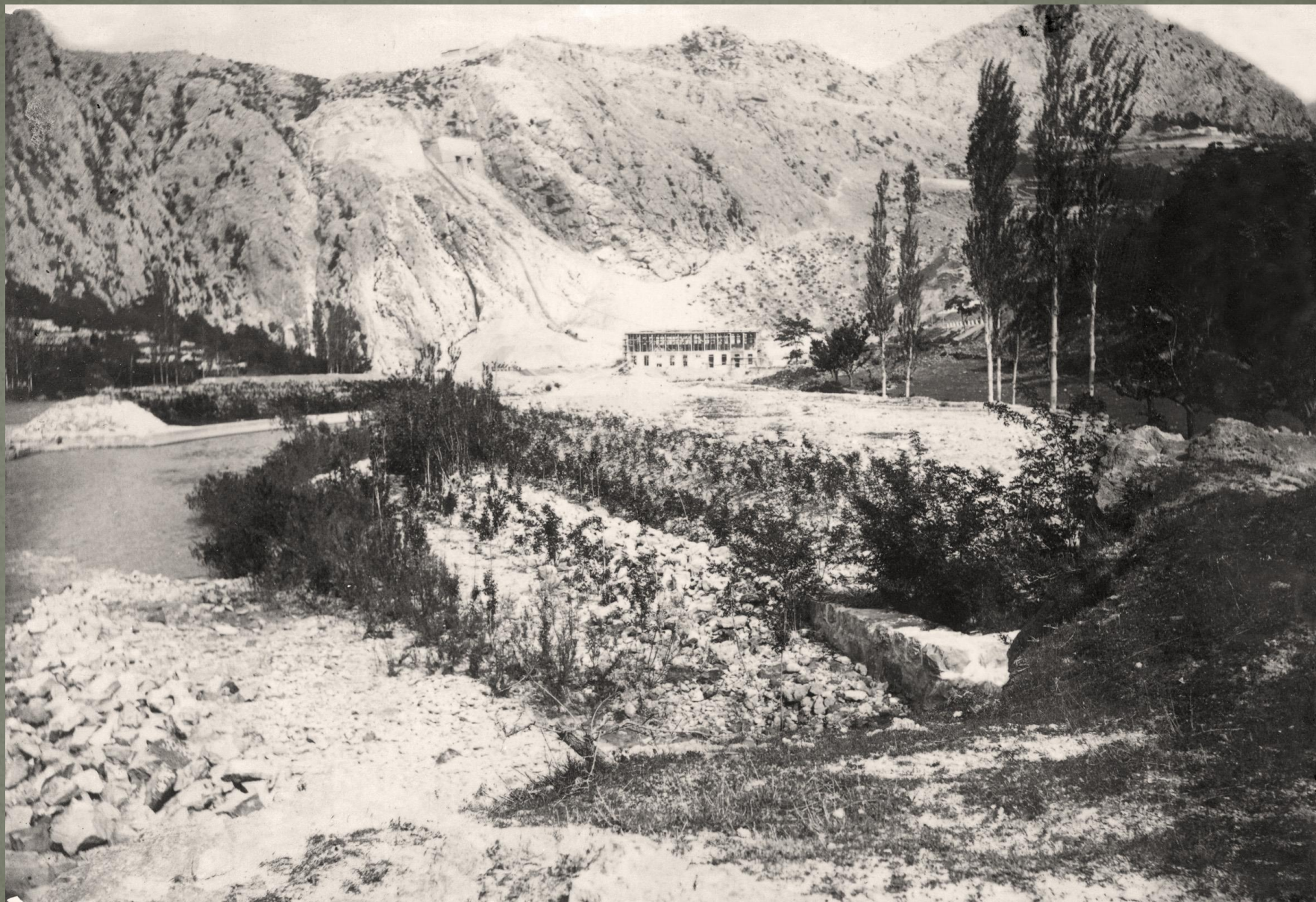
Završni radovi prve faze izgradnje
