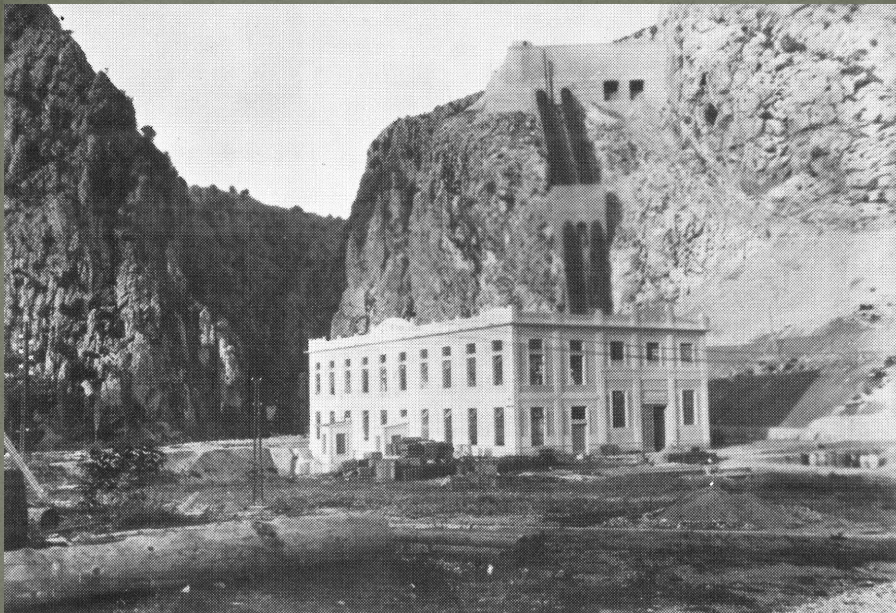
Završeni radovi prve faze izgradnje
