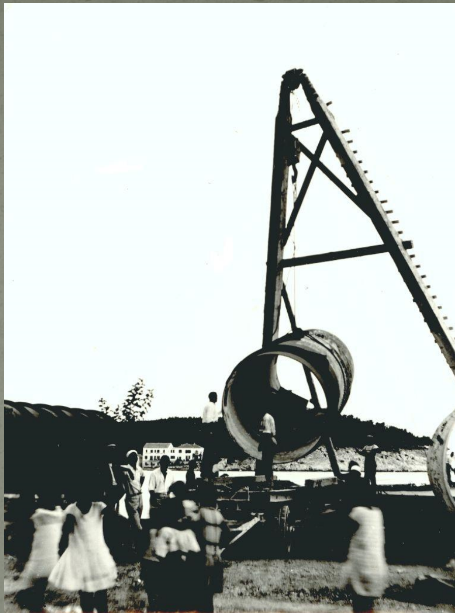
Iskrcaj dijelova tlačnih cjevovoda u Makarskoj
