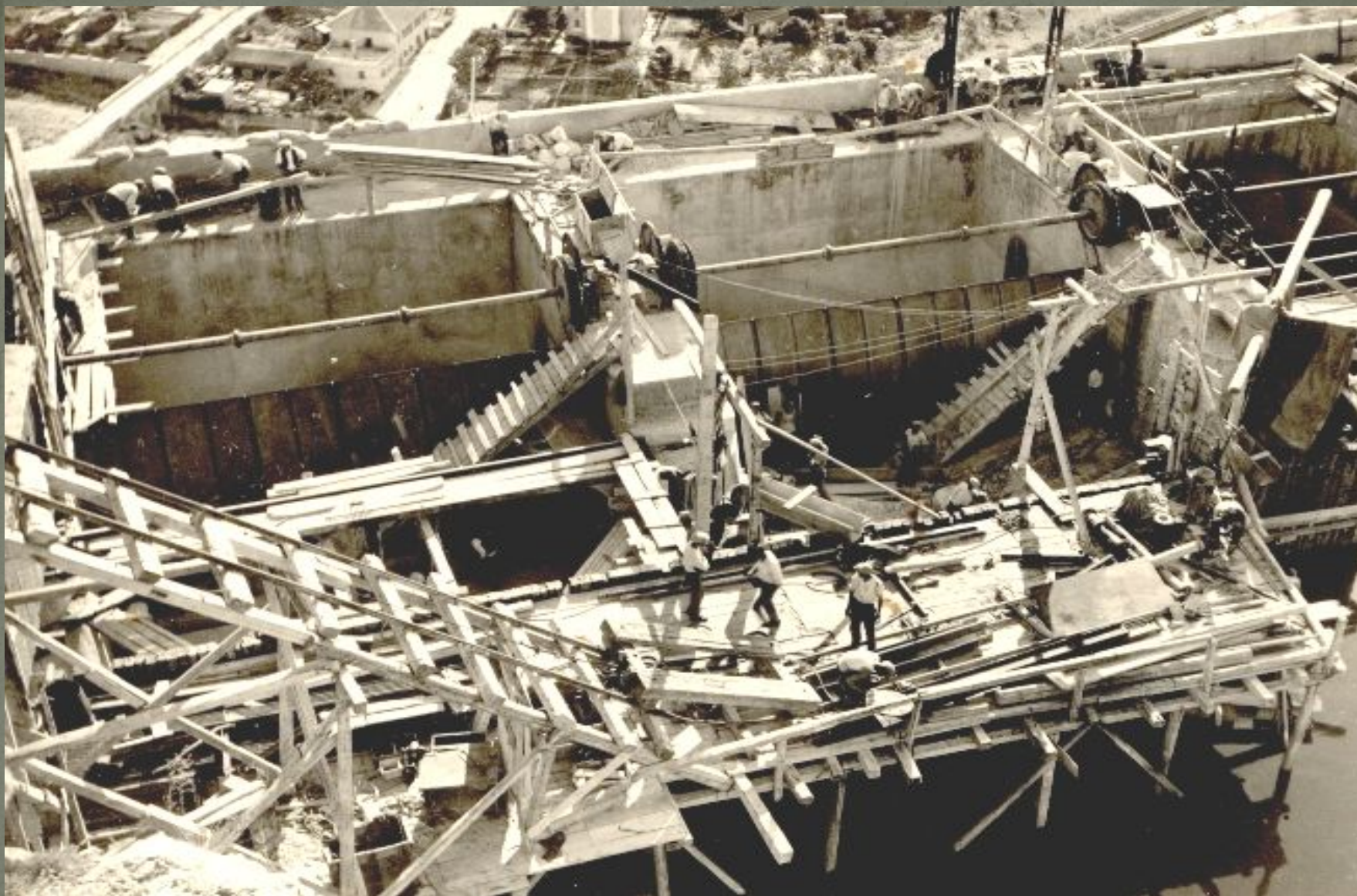
Radovi uređenja vodne komore druge etape
