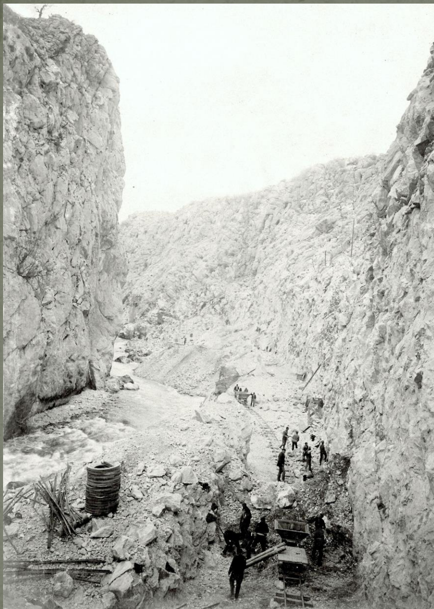
Izgradnja dovodnog kanala na brani 1909. godine
