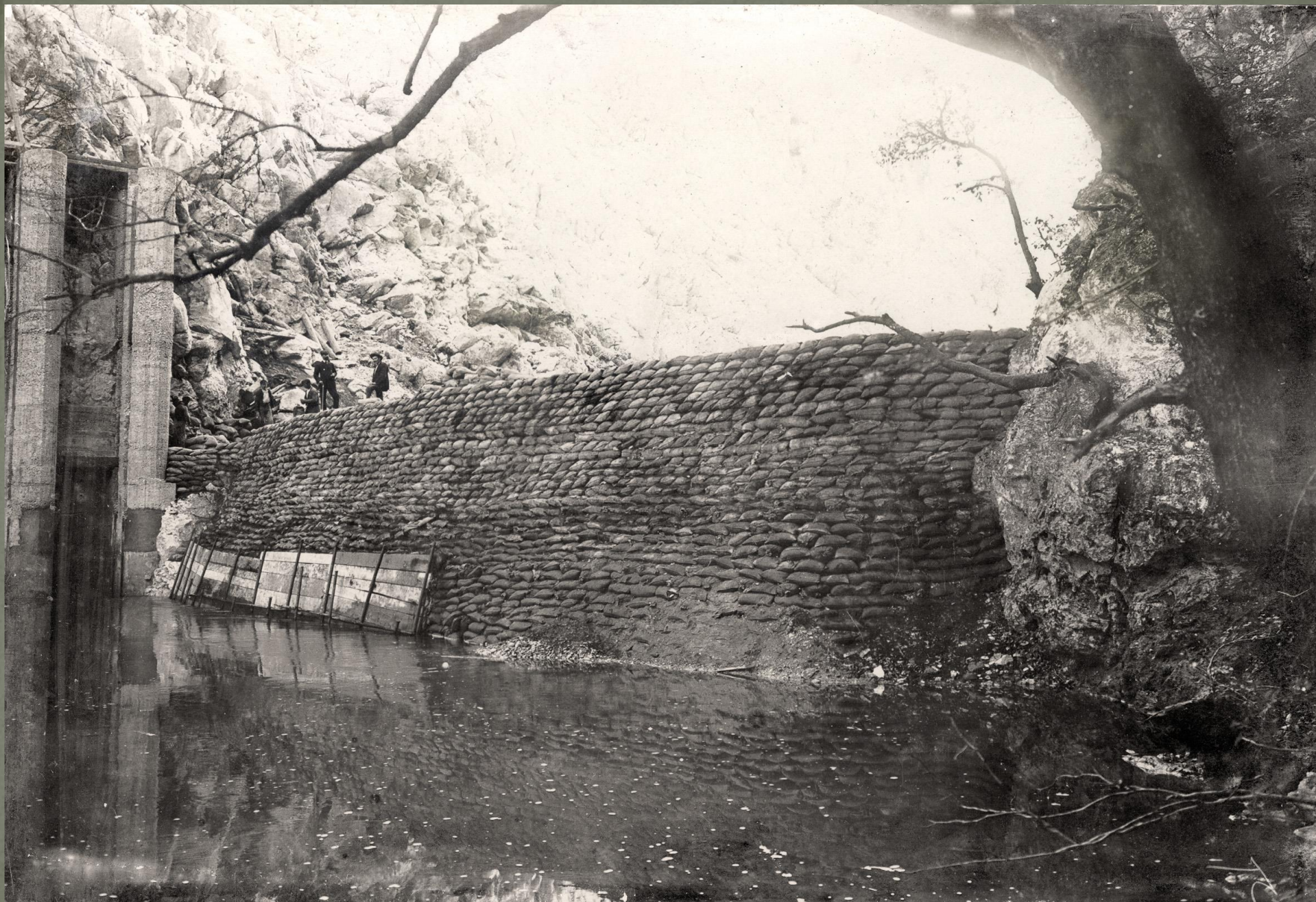
Provizorna brana izgrađena od 20.000 vreća pijeska
