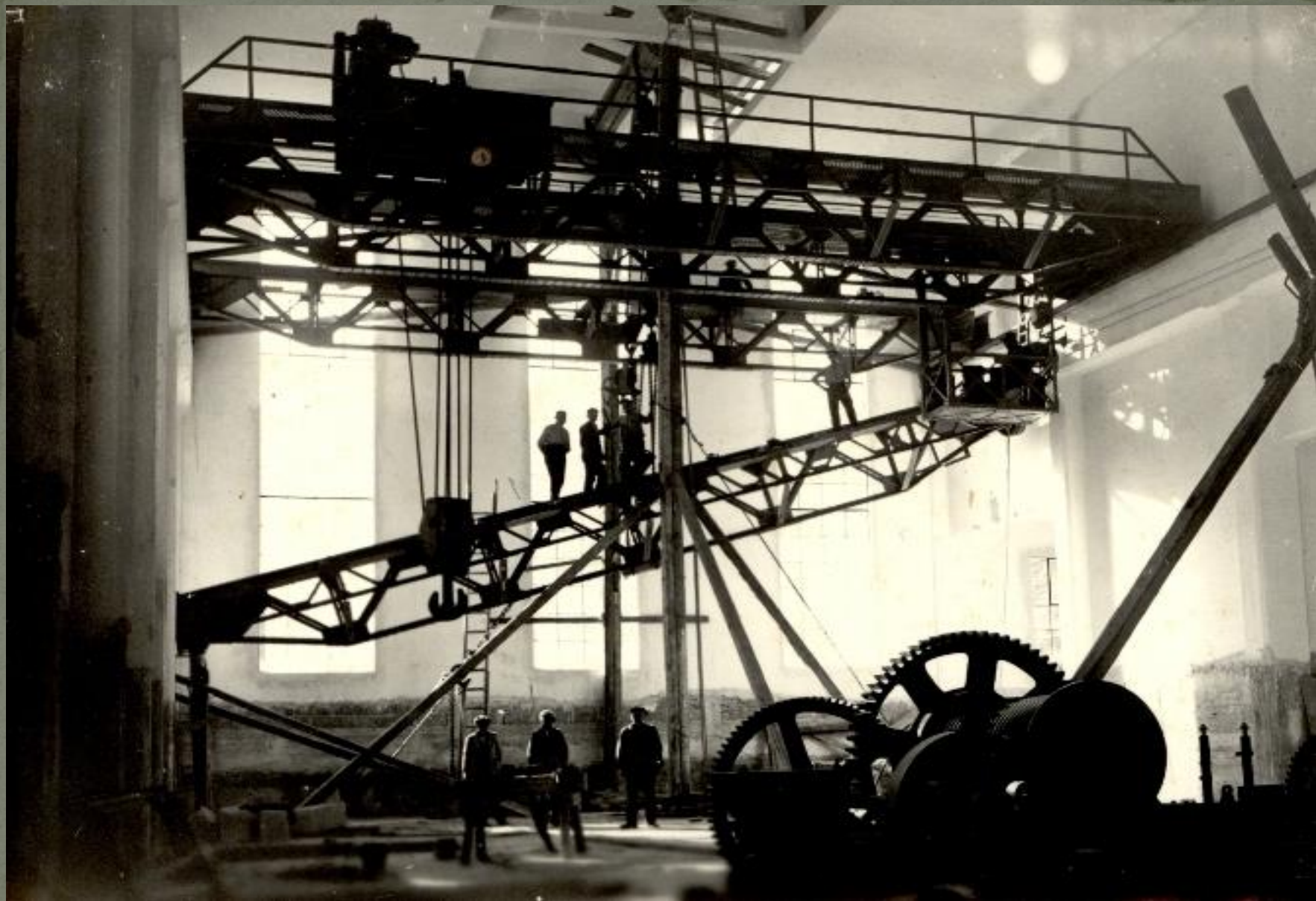
Radovi montaže mosne dizalice
