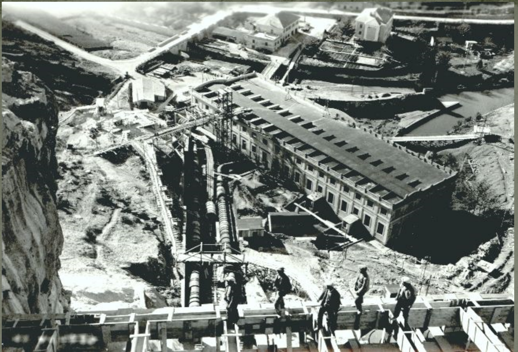
Završetak radova na izgradnji tlačnih cjevovoda 3 i 4
