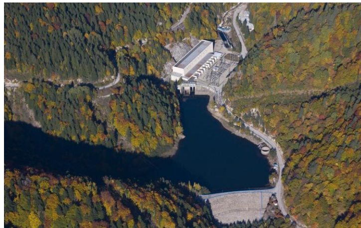
HE Belmeken, 375 MW T/105 MW P Bugarska
