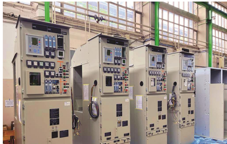
Zrakom izolirani SN sklopni blokovi 12 kV UAE
