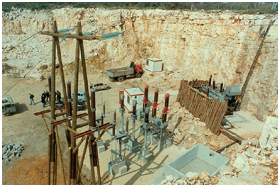
Sl. 4.: Privremena TS 110/10 kV Kava kod Biograda izgrađena je za samo deset dana
