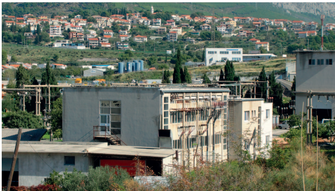
Trafostanica Meterize je u početku služila za opskrbu tada malog grada Splita iz Hidroelektrane Kraljevac, koji se kasnije brzo razvijao zahvaljujući dobrim dijelom i električnoj energiji iz Kraljevca
