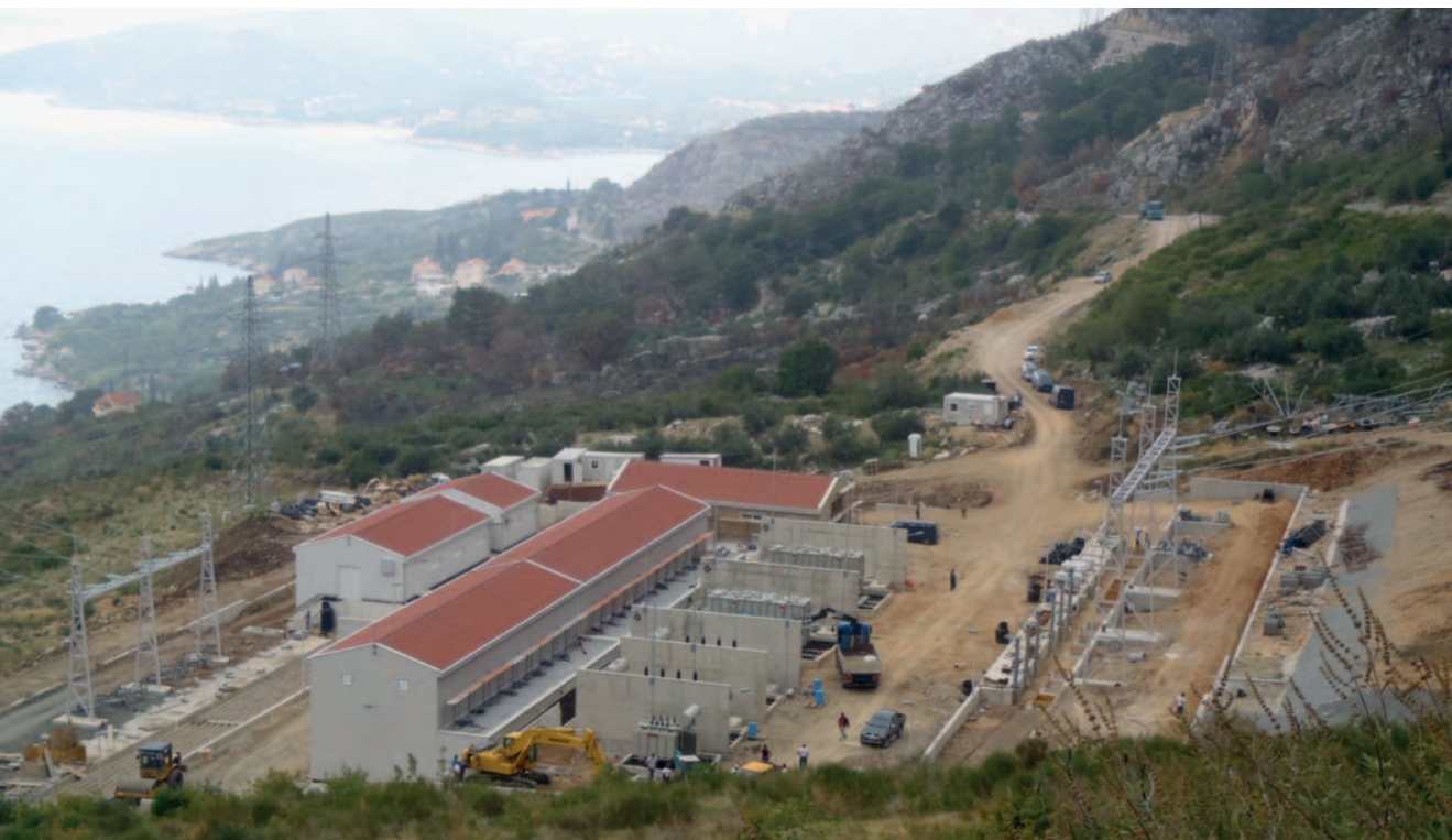
Gradilište TS Plat
