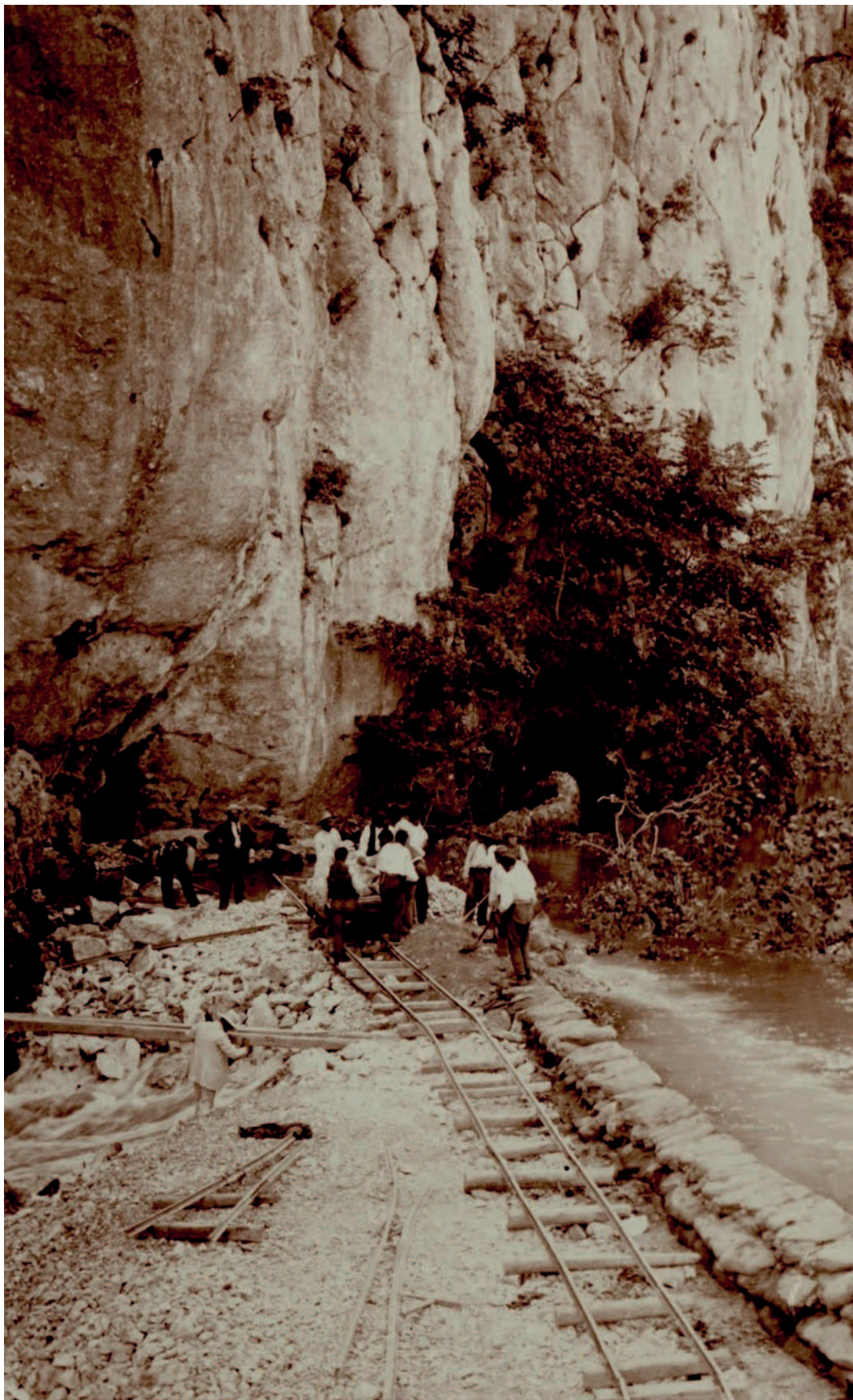
Prvi navozi materijala za branu Hidroelektrane Kraljevac...
