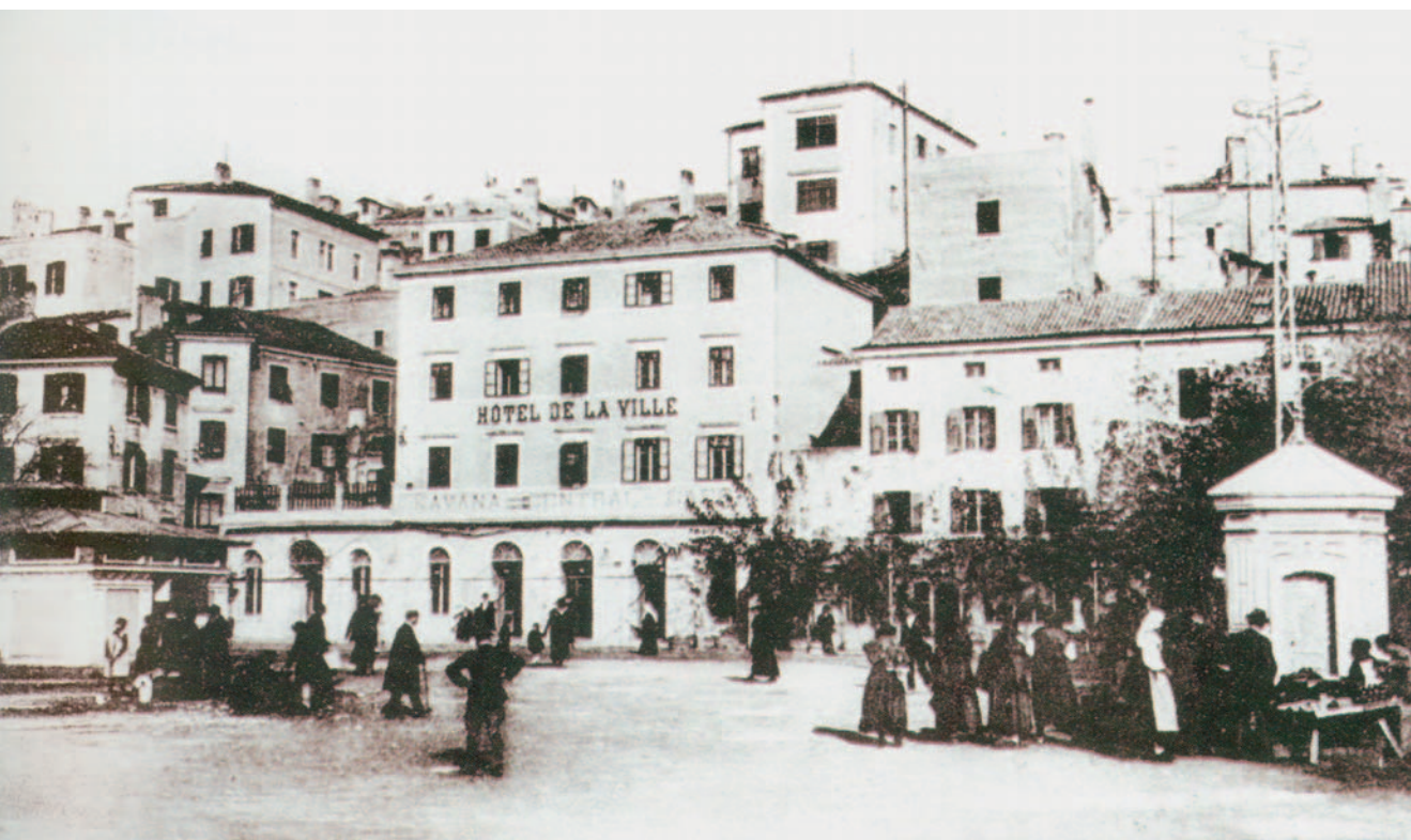
...trafostanica na šibenskoj obali — dio razdjelne mreže
