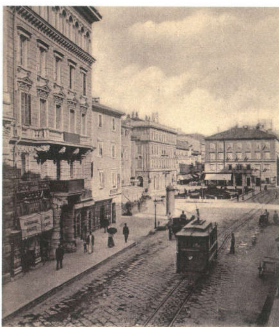
Električni tramvaj na razglednici s početka 20. stoljeća. U pozadini trafostanica na zapadnoj strani Jadranskog trga (DAR)
