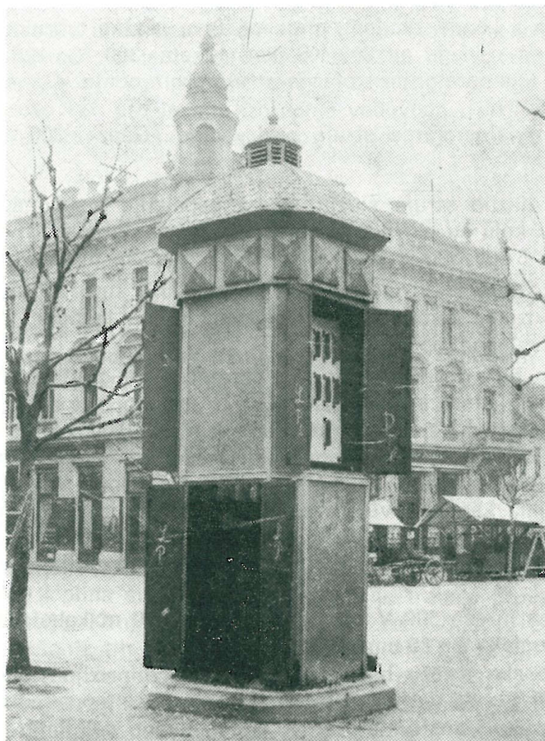
SI. 5. TRANSFORMATORSKA STANICA 5 kV U ZAGREBAČKOJ MREŽI
