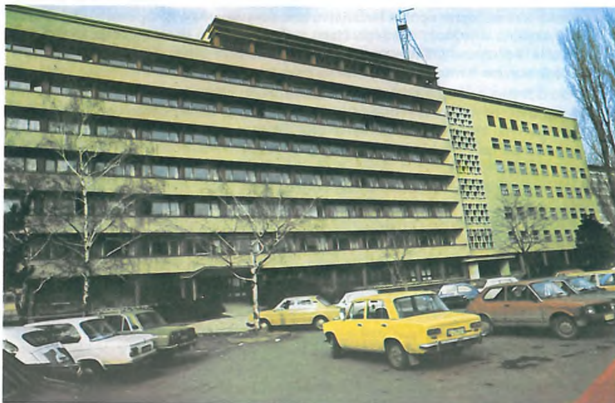
Sl. 2. 1. ZGRADA ZAJEDNICE ELEKTROPRIVREDNIH ORGANIZACIJA HRVATSKE
