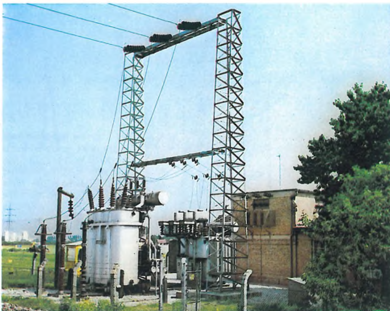
Sl. 5. 1. TS KLARA 110/30 kV KRAJ ZAGREBA, U POGONU OD 1947. (ŽELJEZNI PORTAL IZGRAĐEN SEDAMDESETIH GODINA)
