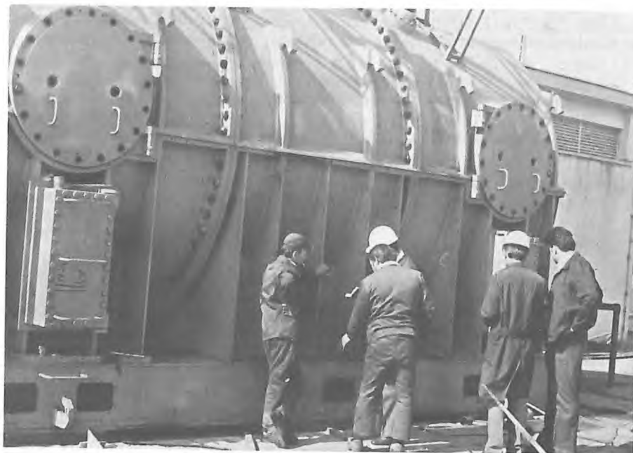
Sl. 7. 19. SINHRONI KOMPENZATOR 50 MVar U TS MRACLIN
