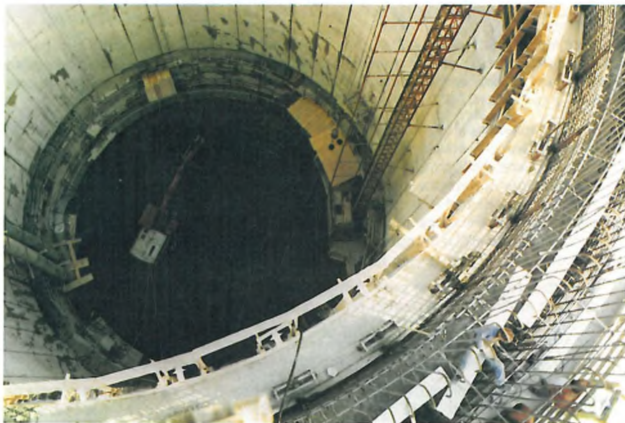
Sl. 6. 35. HIDROELEKTRANA OBROVAC. GRADNJA «BUNARA» STROJARNICE
