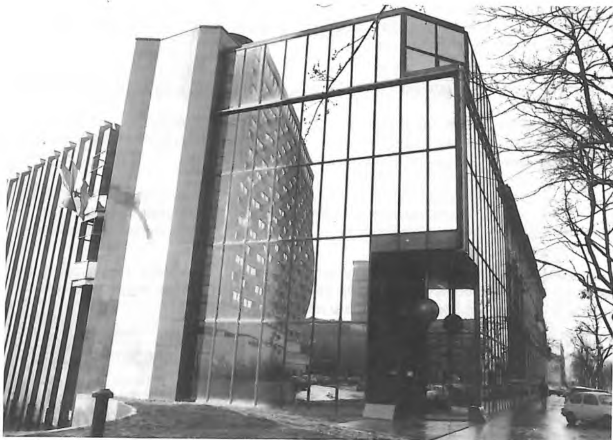
Sl. 10. 6. TRANSFORMATORSKA STANICA 35/10 kV UKLOPNA I – ZAGREB (1980. G.)
