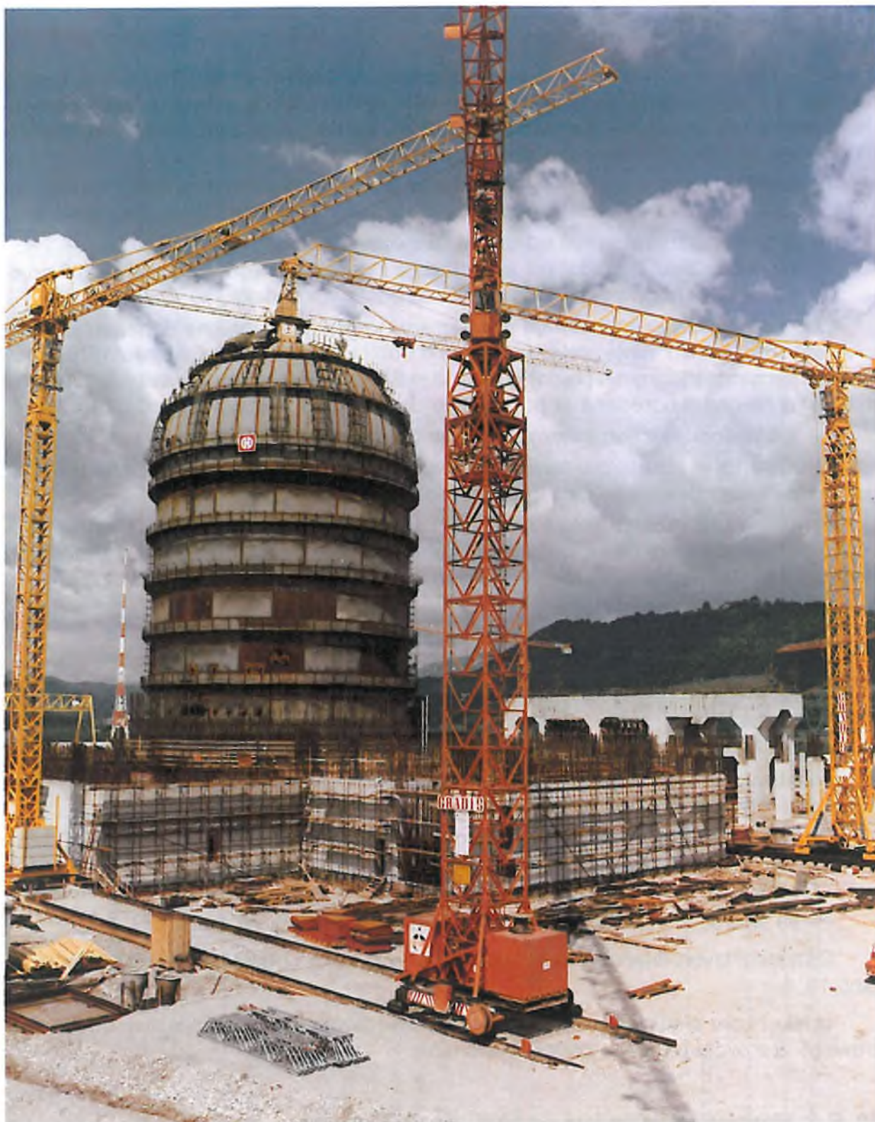
SI. 10. 3. NUKLEARNA ELEKTRANA KRŠKO, TORANJ REAKTORA U GRADNJI
