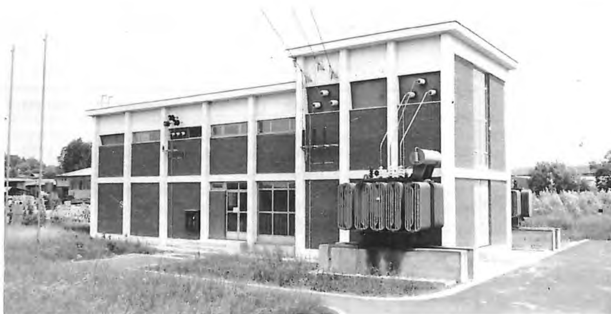
Sl. 8. 10. TRANSFORMATORSKA STANICA BEDEKOVČINA 35/10 kV
