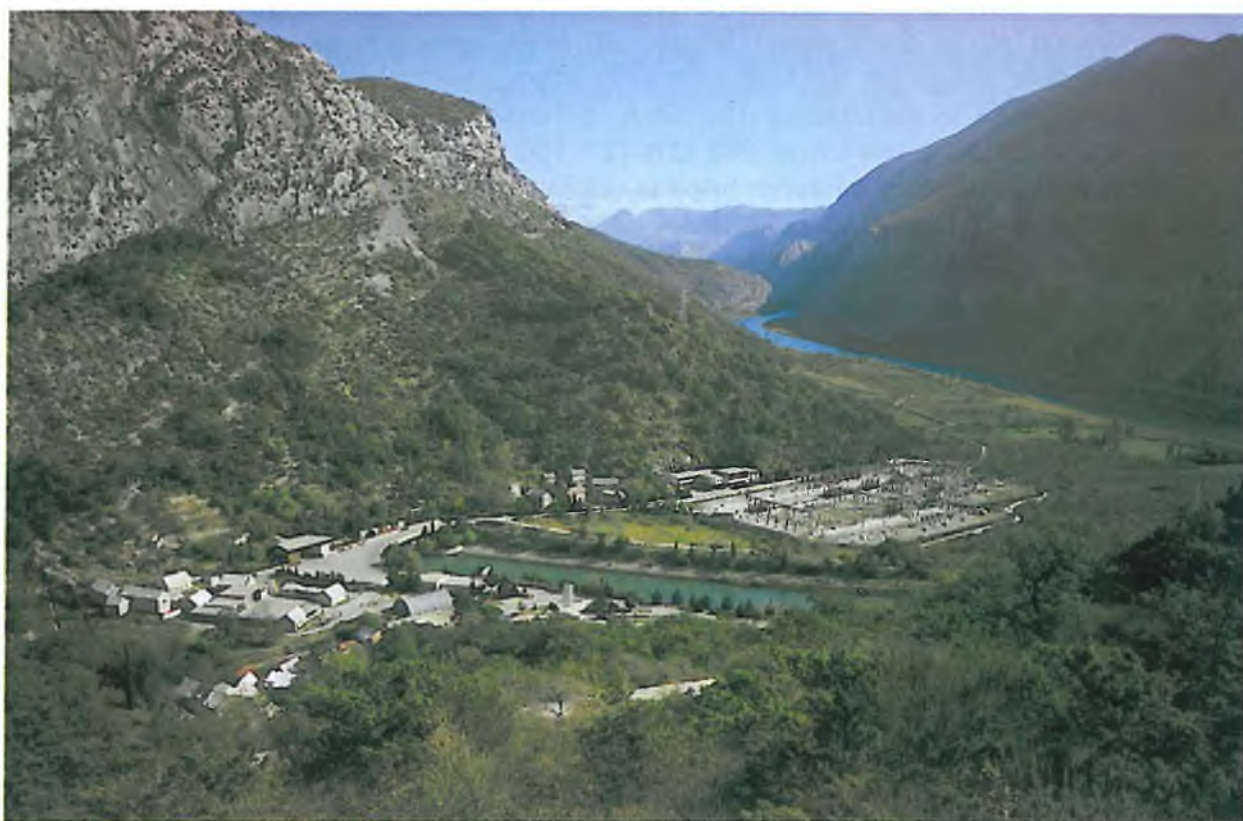
Sl. 6. 15. HIDROELEKTRANA ZAKUČAČ, POGLED NA ELEKTRANU I RASKLOPNO POSTROJENJE
