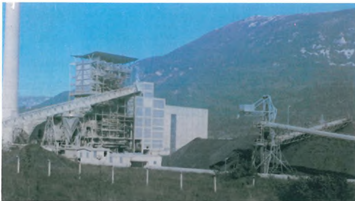
Sl. 6. 25. TERMoelektrana PLOMIN
