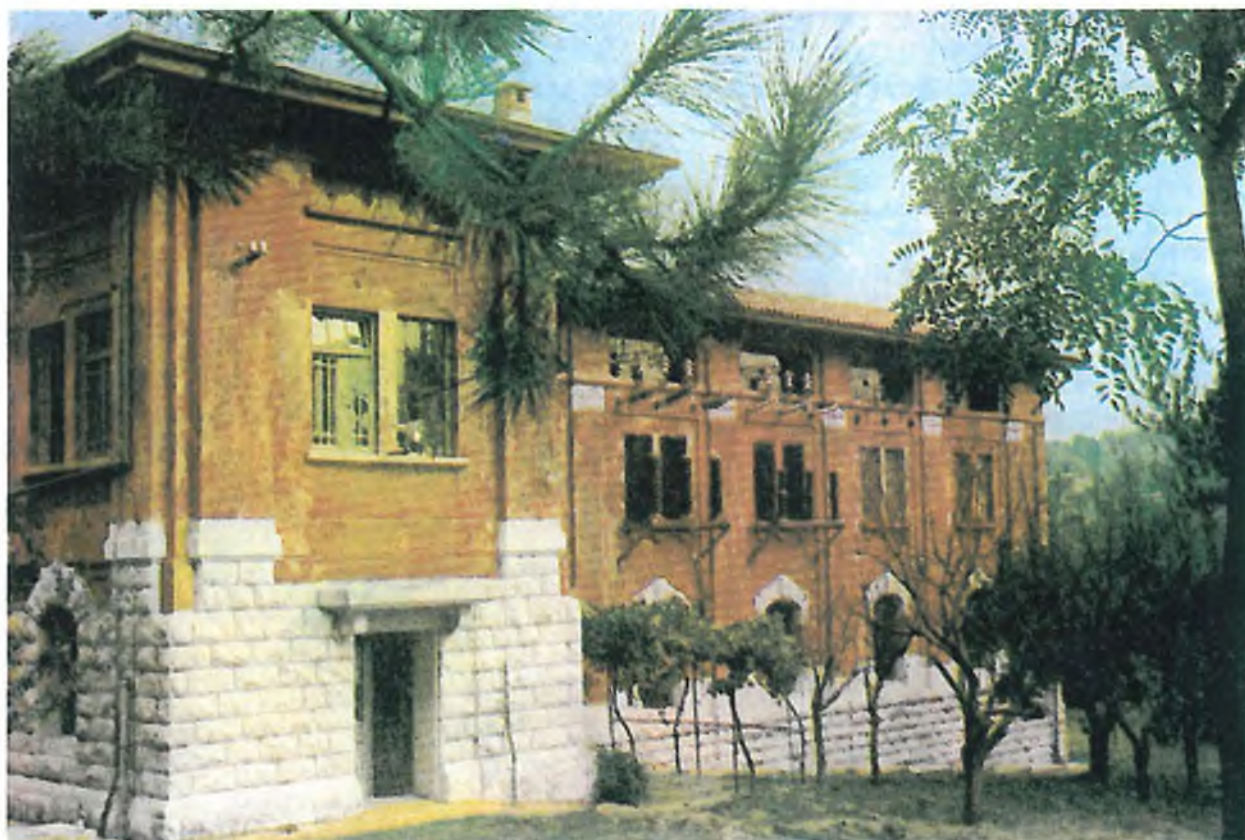
Sl. 8. 17. TRANSFORMATORSKA STANICA KAROJBA 35/10 kV (1960. g.)
