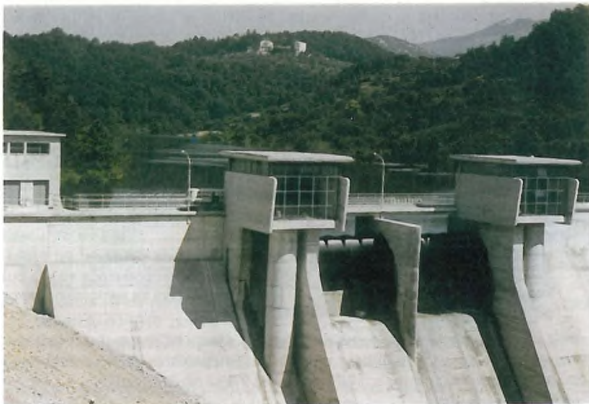
Sl. 10. 2. HIDROELEKTRANA RIJEKA, BRANA VALIĆI
