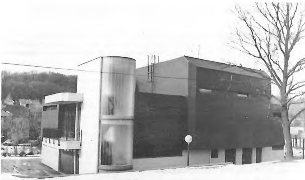
Sl. 8. 6. TRANSFORMATORSKA STANICA 110 kV KSAVER (ZAGREB-SJEVER) (1983. g.)
