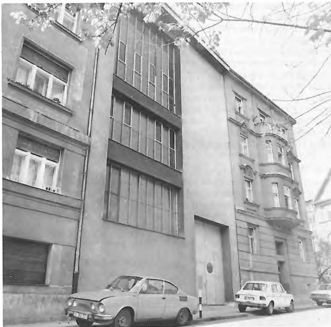
Sl. 8. 5. TRANSFORMATORSKA STANICA 30/10 kV U ZAGREBU U KUKULJEVIĆEVOJ ULICI (1967. g.)
