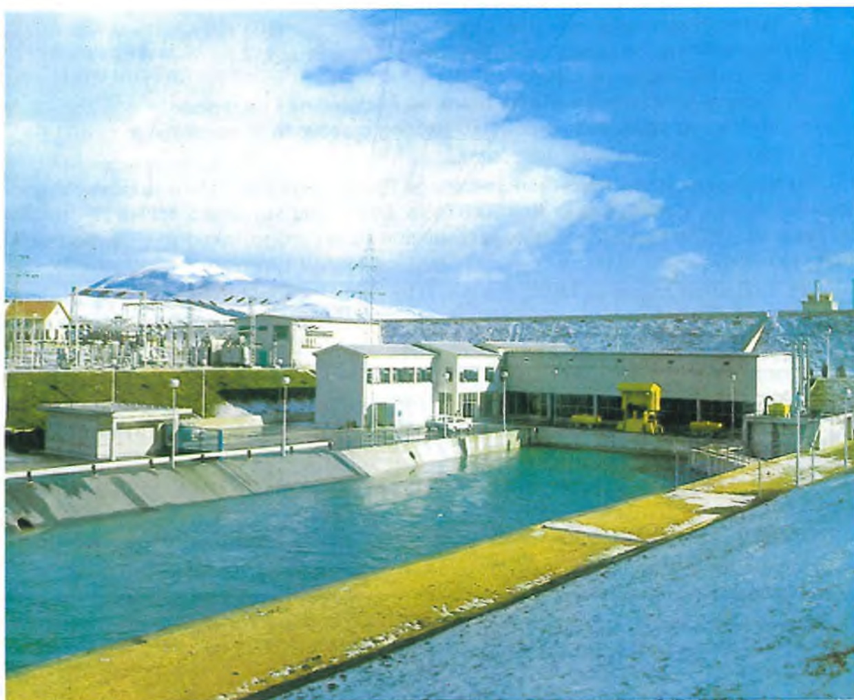
Sl. 6. 27. HIDROELEKTRANA ORLOVAC
