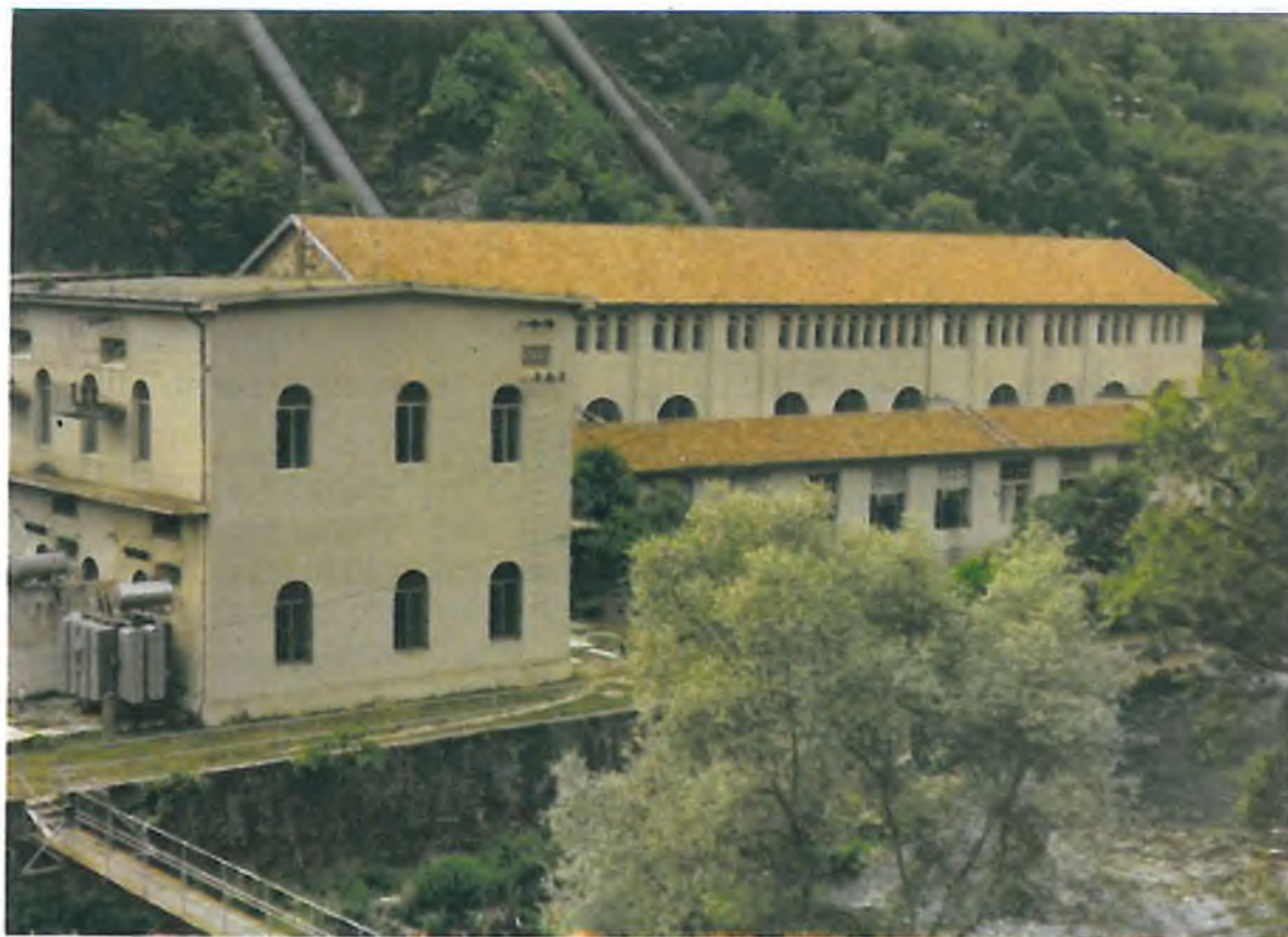
Sl. 6. 7. HIDROELEKTRANA MANOJLOVAC NAKON REKONSTRUKCIJE
