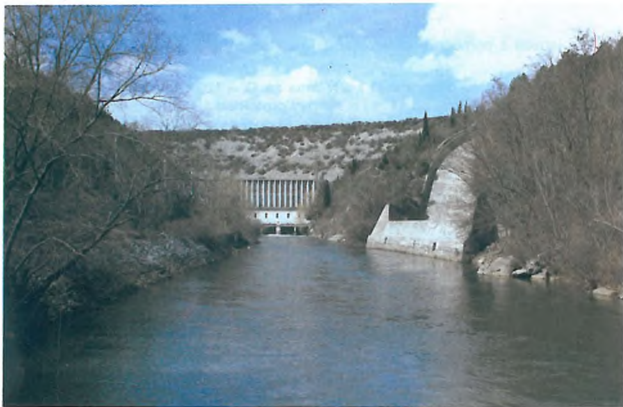
SL. 6. 13. HIDROELEKTRANA PERUĆA, BRANA, STROJARNICA I SLAPIŠTE PRELJEVA
