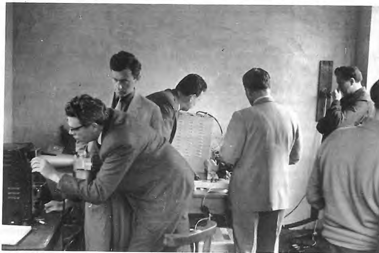
Sl. 7. 24. ISPITIVANJA U RASKLOPNOM POSTROJENJU TE JERTOVEC (1965. G.)
