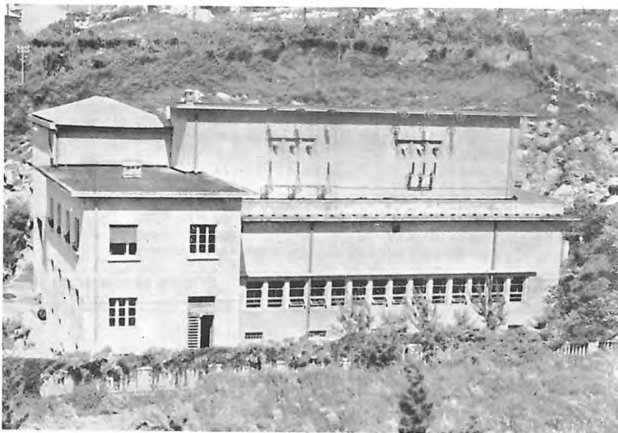
Sl. 8. 12. TRANSFORMATORSKA STANICA 30 kV U RIJECI (1957. g.)
