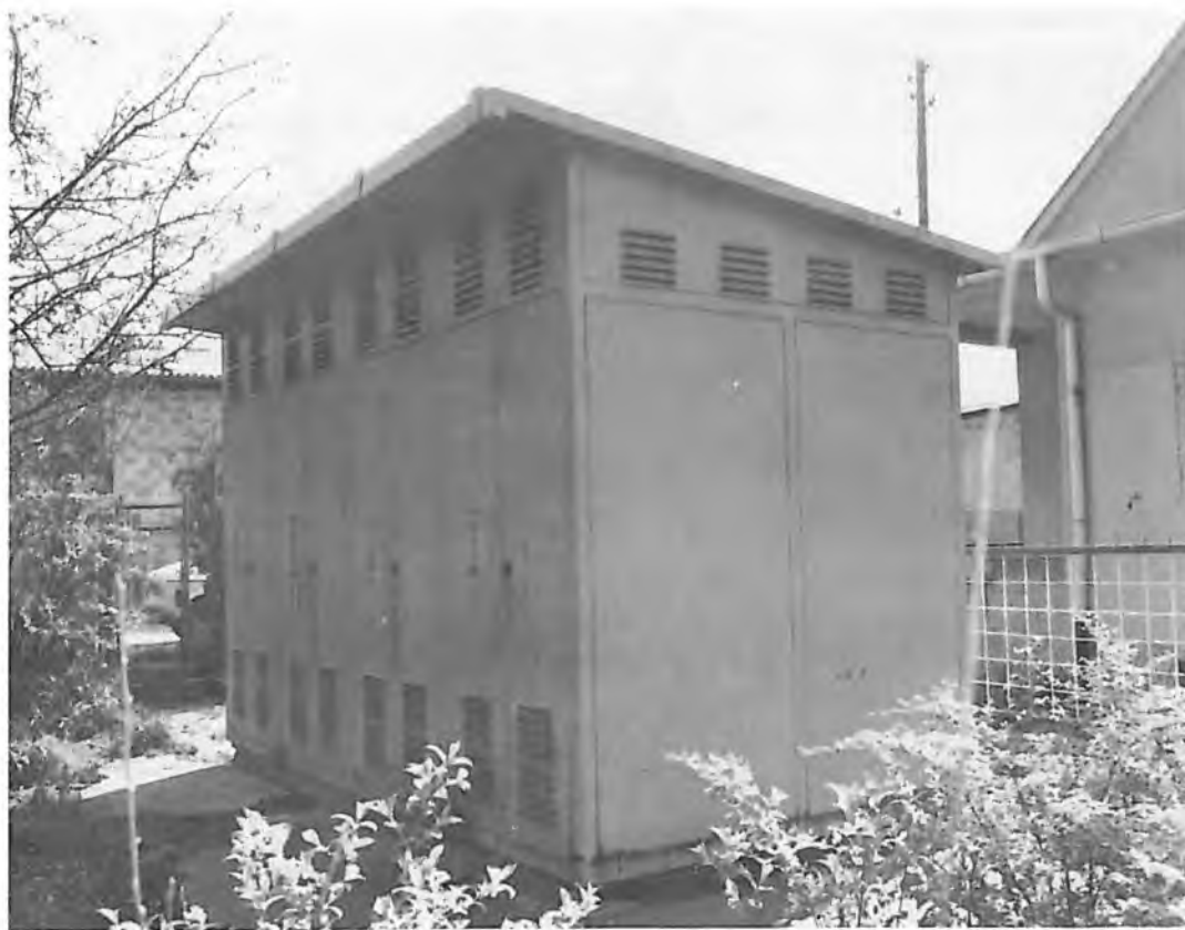
Sl. 8. 3. LIMENA TRANSFORMATORSKA STANICA 10/0,4 kV (1957. g.)
