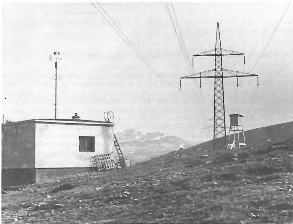
Sl. 7. 17. ISPITNI VOD 220 kV NA ZRMANJI
