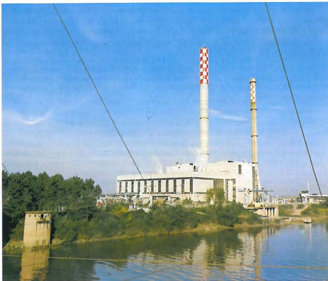
Sl. 6. 26. TERMoeLEKTRANA SISAK
