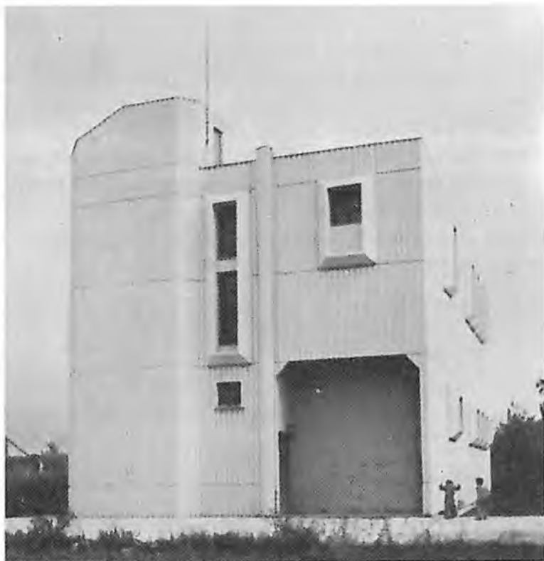
Sl. 8. 25. TRANSFORMATORSKA STANICA KAŠTELA 35/10 kV (1981. g.)
