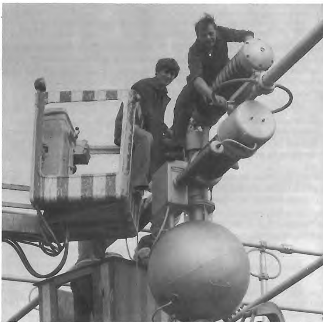
Sl. 10. 5. REMONT U POSTROJENJU VISOKOG NAPONA (ELEKTROSLAVONIJA)
