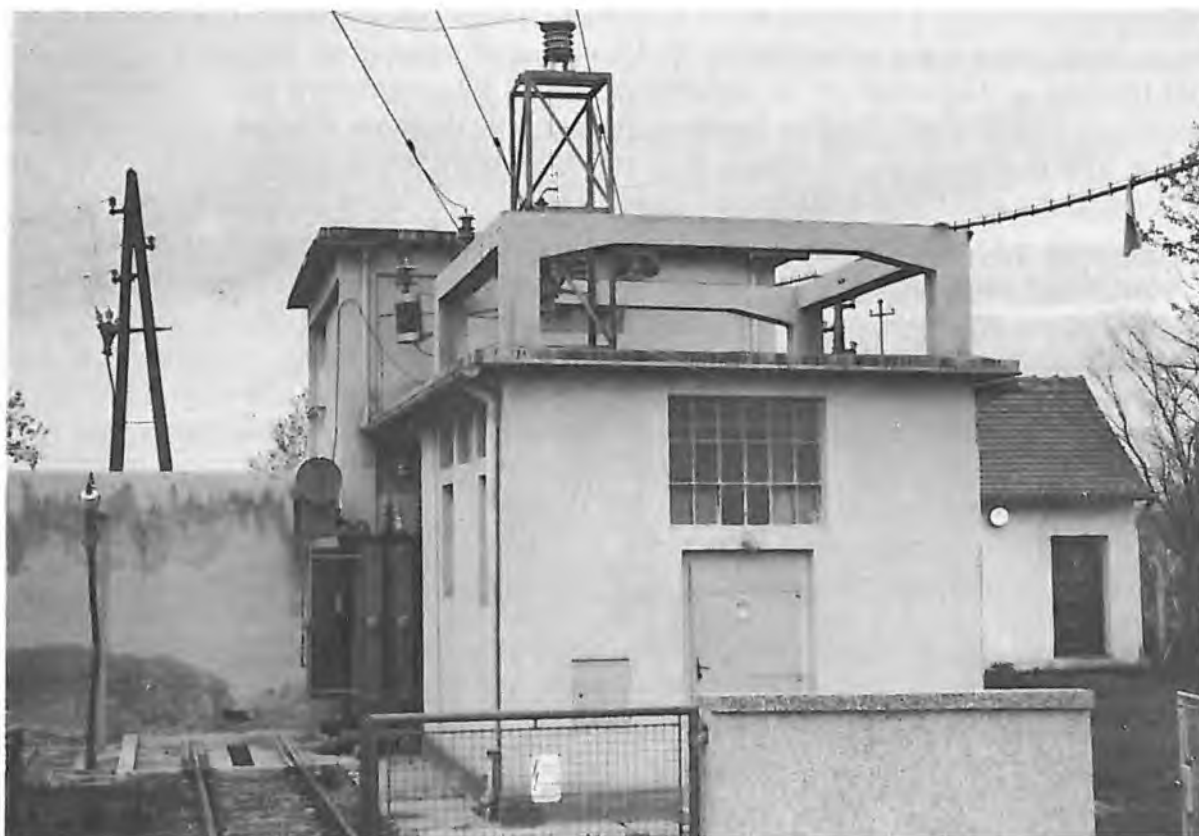
Sl. 5. 3. TS NOVA GRADIŠKA 30/10 kV (1948. G.)
