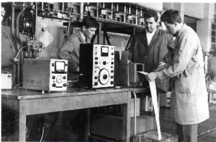
Sl. 1. Mjerenje torzionih vibracija na ispitnoj stanici motora 1973. Od lijeva: Vladimir Godek, Zlatko Jeličić i Mirko Butković
