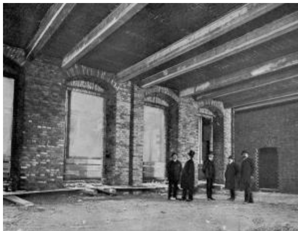
Slika 15. Nadgledanje izvođenja tavanice u tvorničkom objektu od strane predstavnika poduzeća barona Pitela [12]
