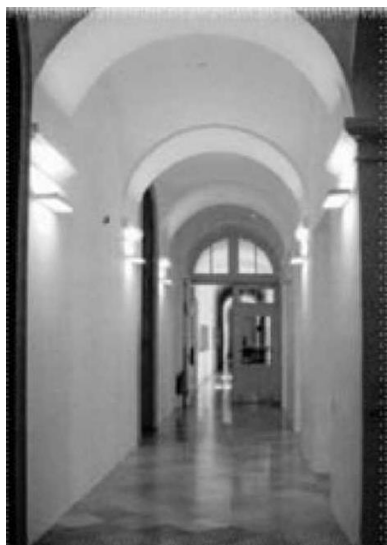
Slika 17. Tavanica izgrađena po Milankovićevom patentu [18]
