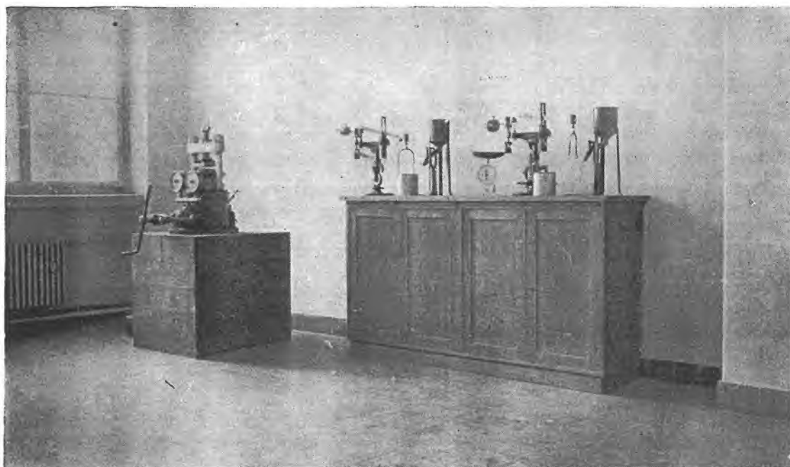
Zavod za izpitivanje gradiva, mala strojarnica. 40-t preša i Mihaelis-vage za izpitivanje cementa.
