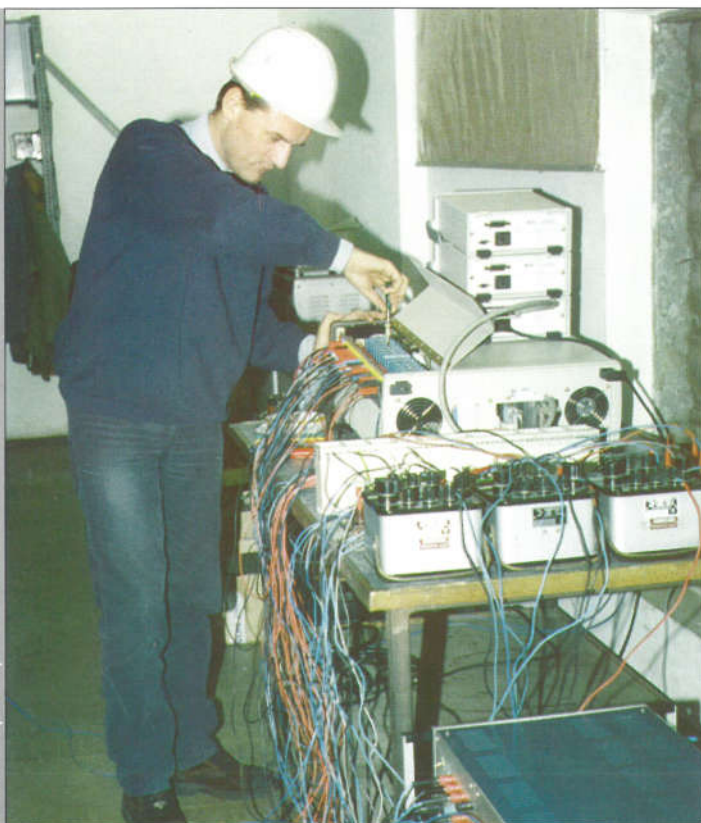
Primarna ispitivanja u termoelektronici
