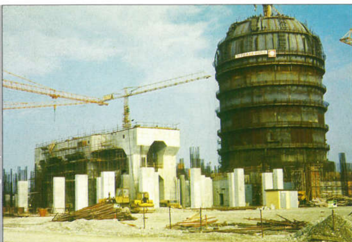
NE - Krško u gradnji
