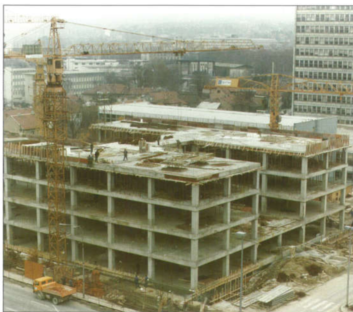
Gradnja nove zgrade FER-a
