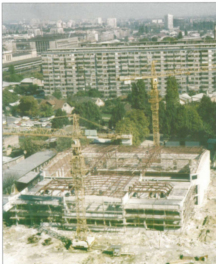
Gradnja sportske dvorane "Marinova"
