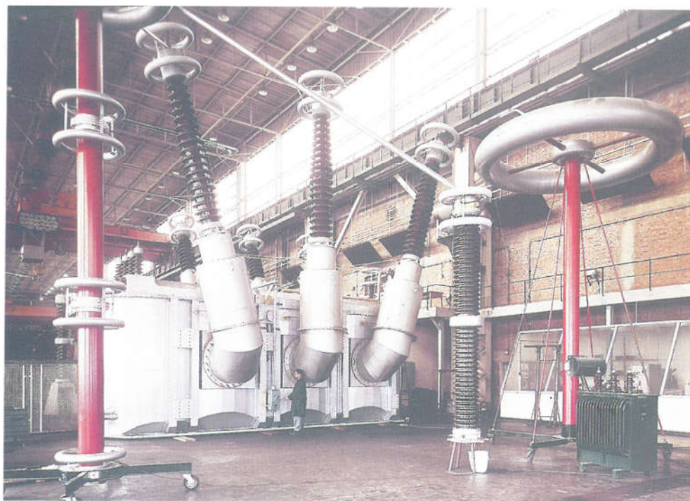
Ispitivanje transformatora 400 MVA, 400 kV
