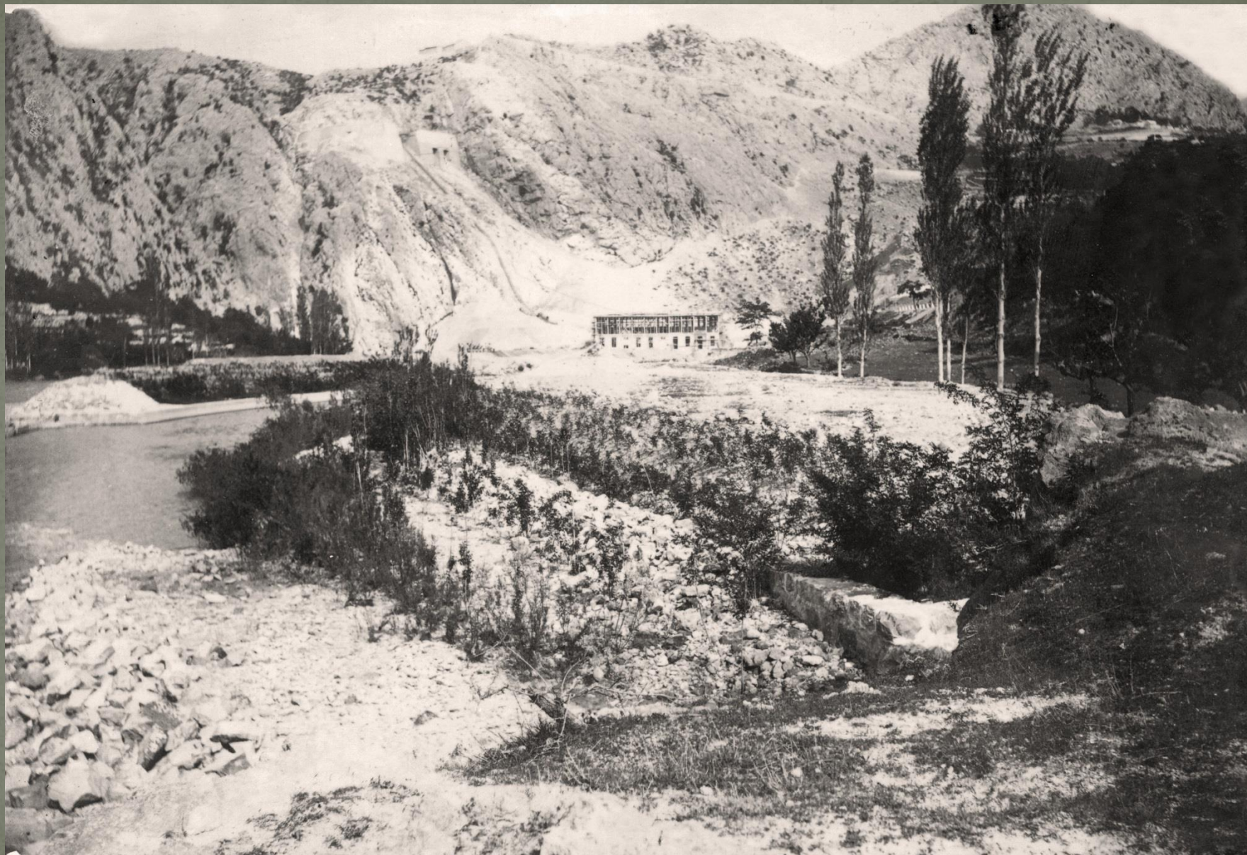
Završni radovi prve faze izgradnje
