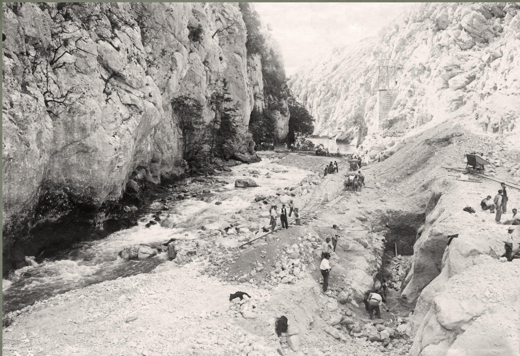
Izgradnja brane 1909. godine
