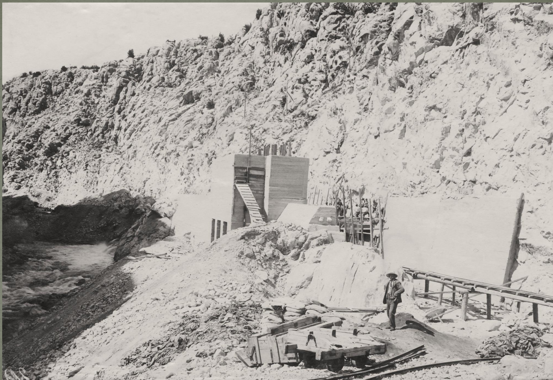
Izgradnja dovodnog kanala na brani 1909. godine
