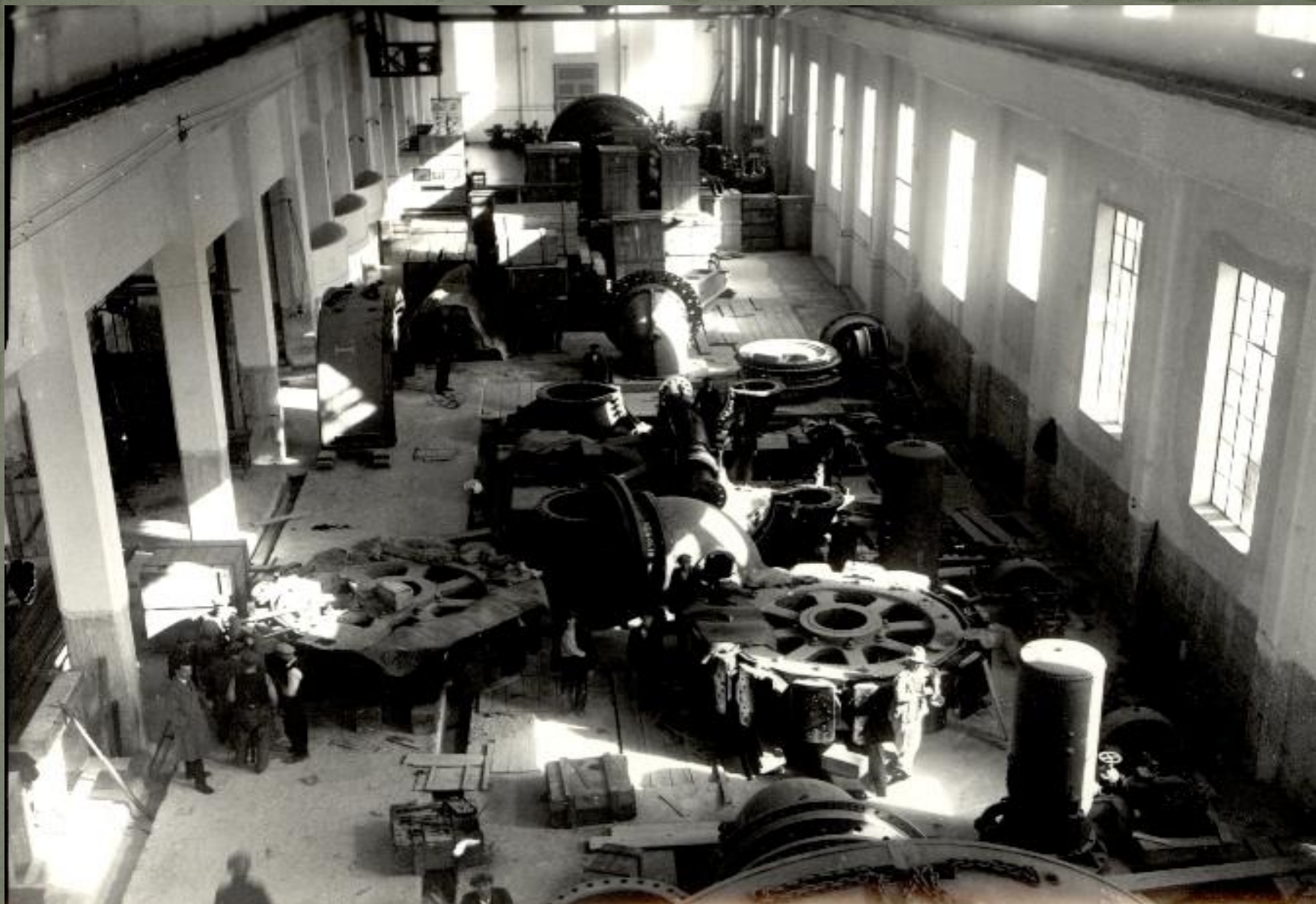
Pogled na strojarnicu – početak montaže agregata
