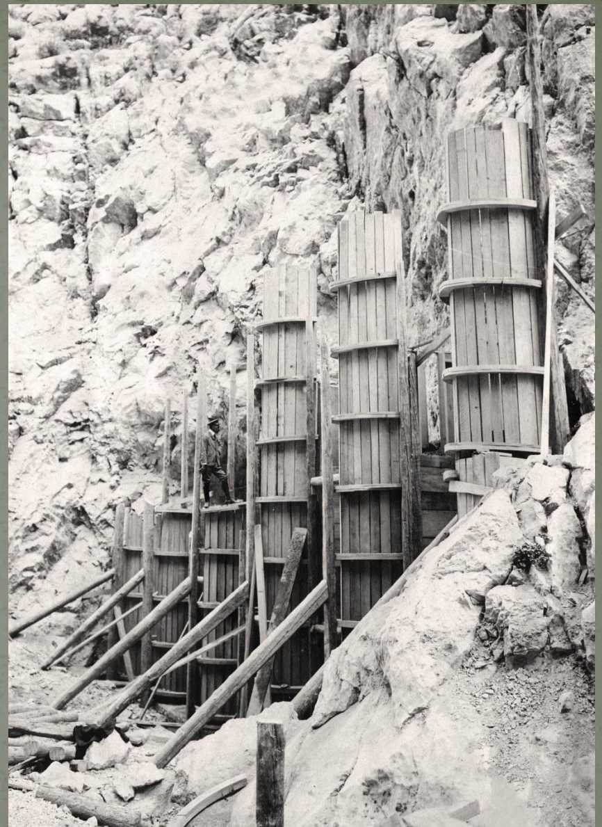
Izgradnja obilaznog tunela na brani 1909. godine
