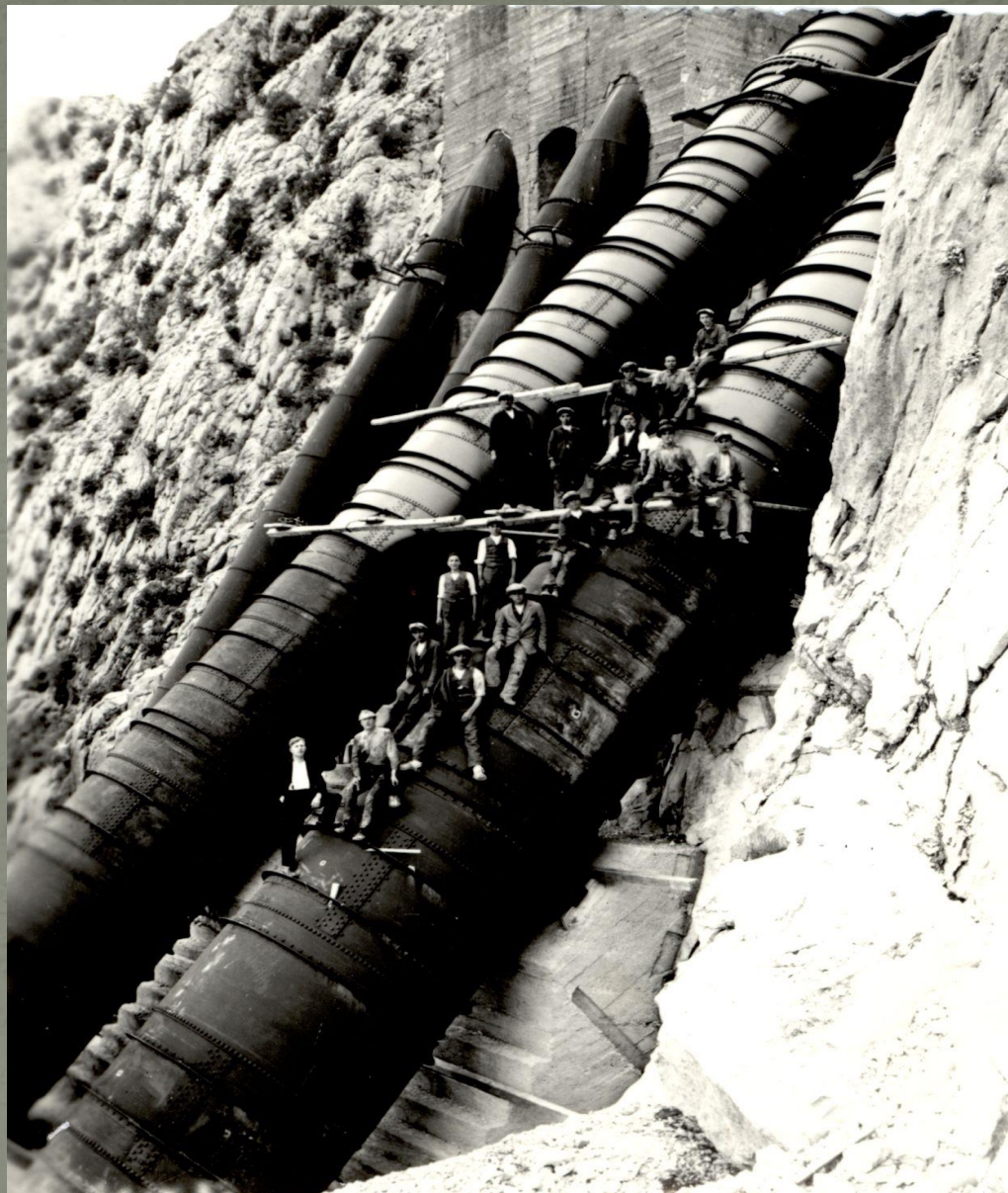
Završetak radova na izgradnji tlačnih cjevovoda 3 i 4
