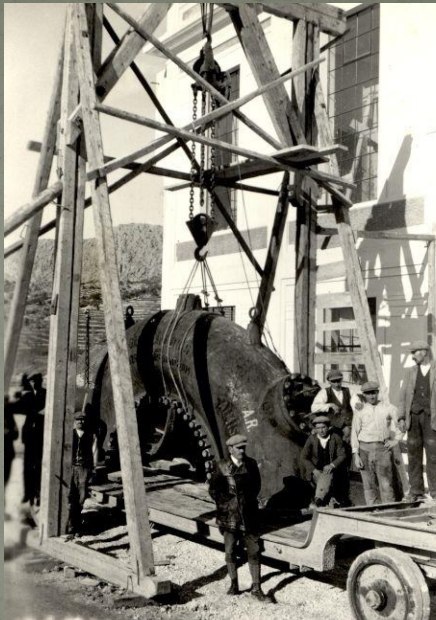
Dolazak dijelova turbina na gradilište
