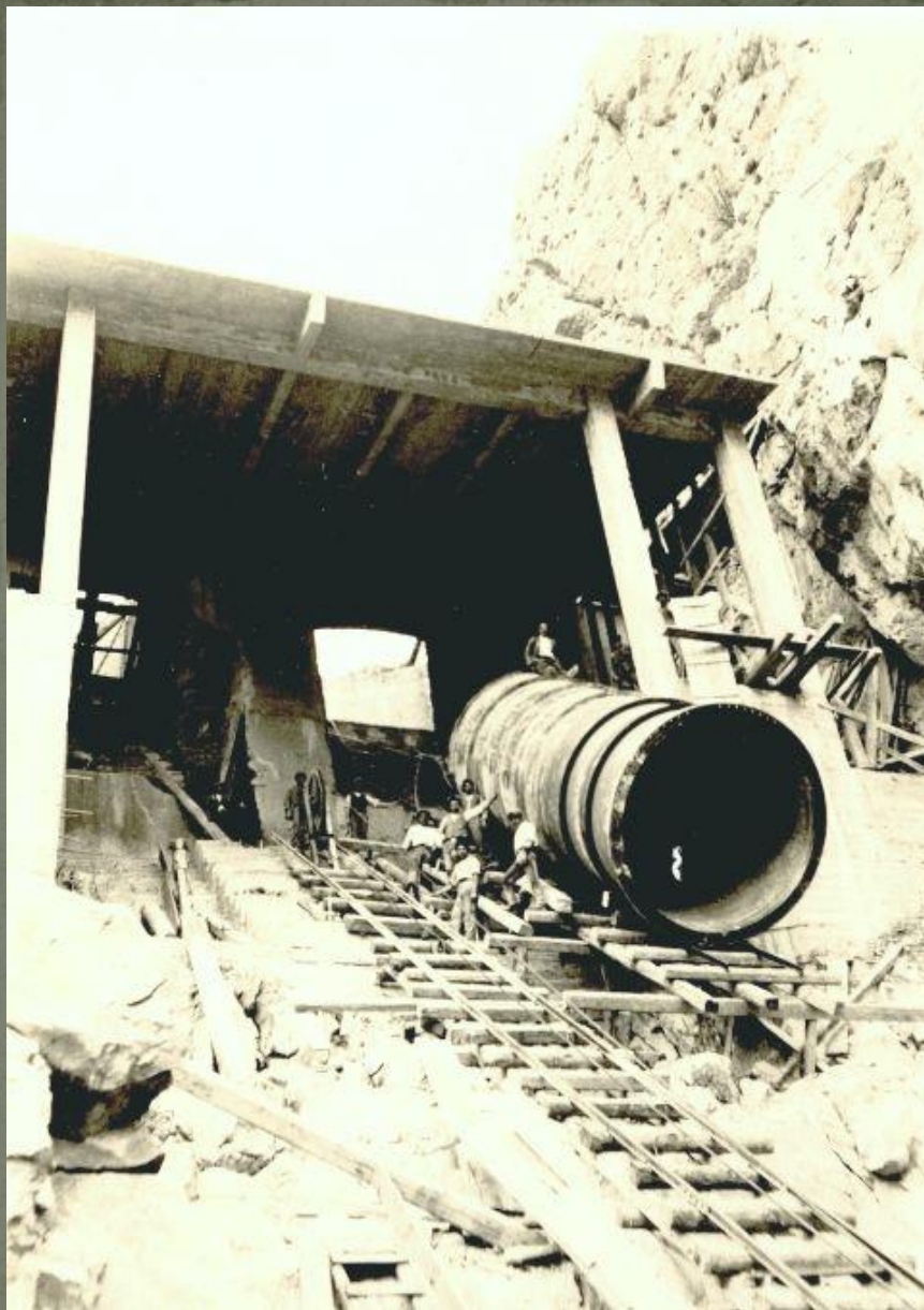
Transport dijelova tlačnih cjevovoda prema vodnoj komori
