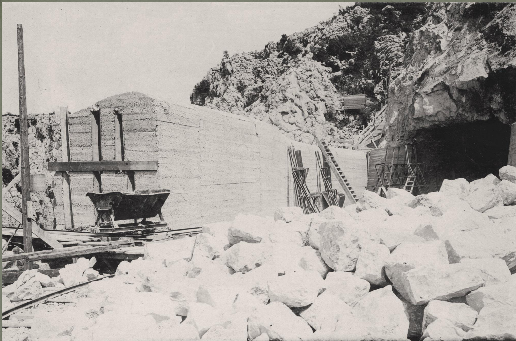
Lijevi izlaz iz tunela na vodnu komoru
