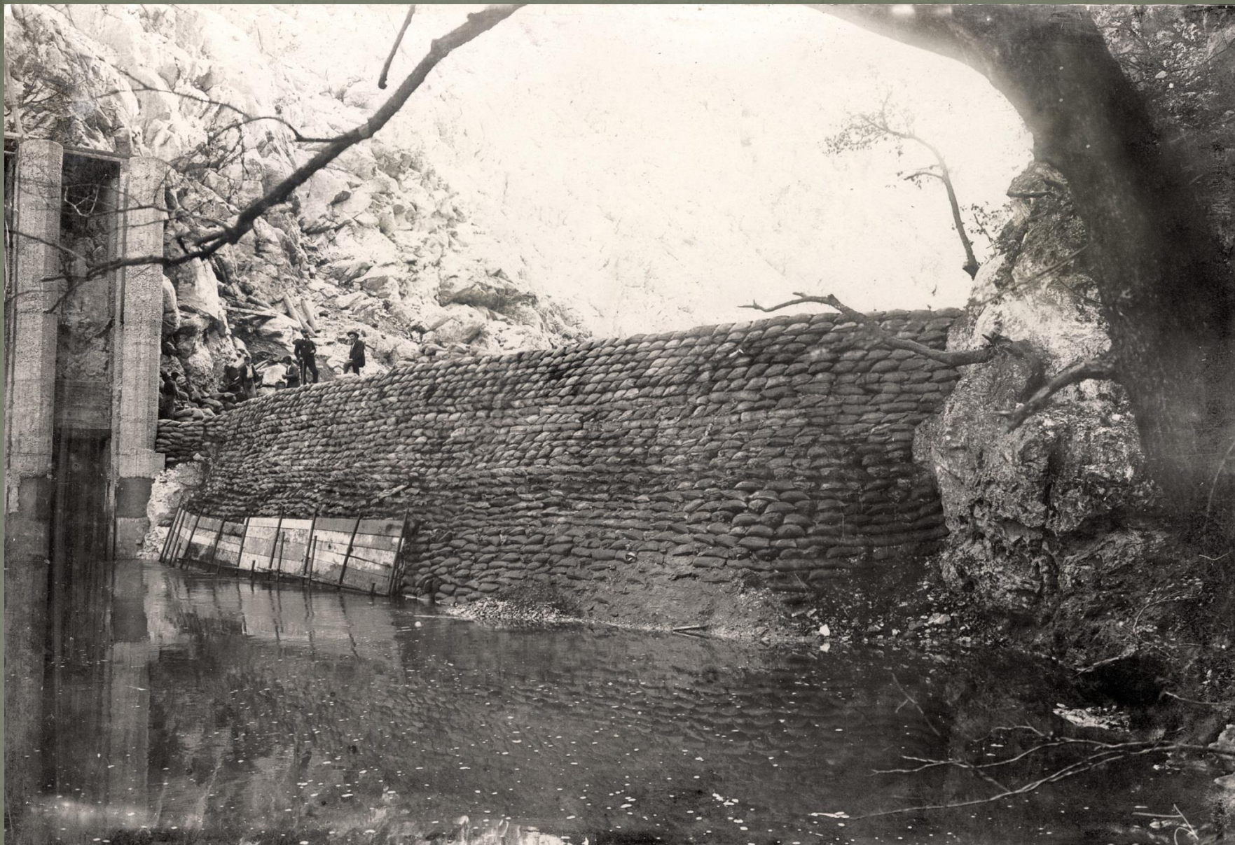
Provizorna brana izgrađena od 20.000 vreća pijeska
