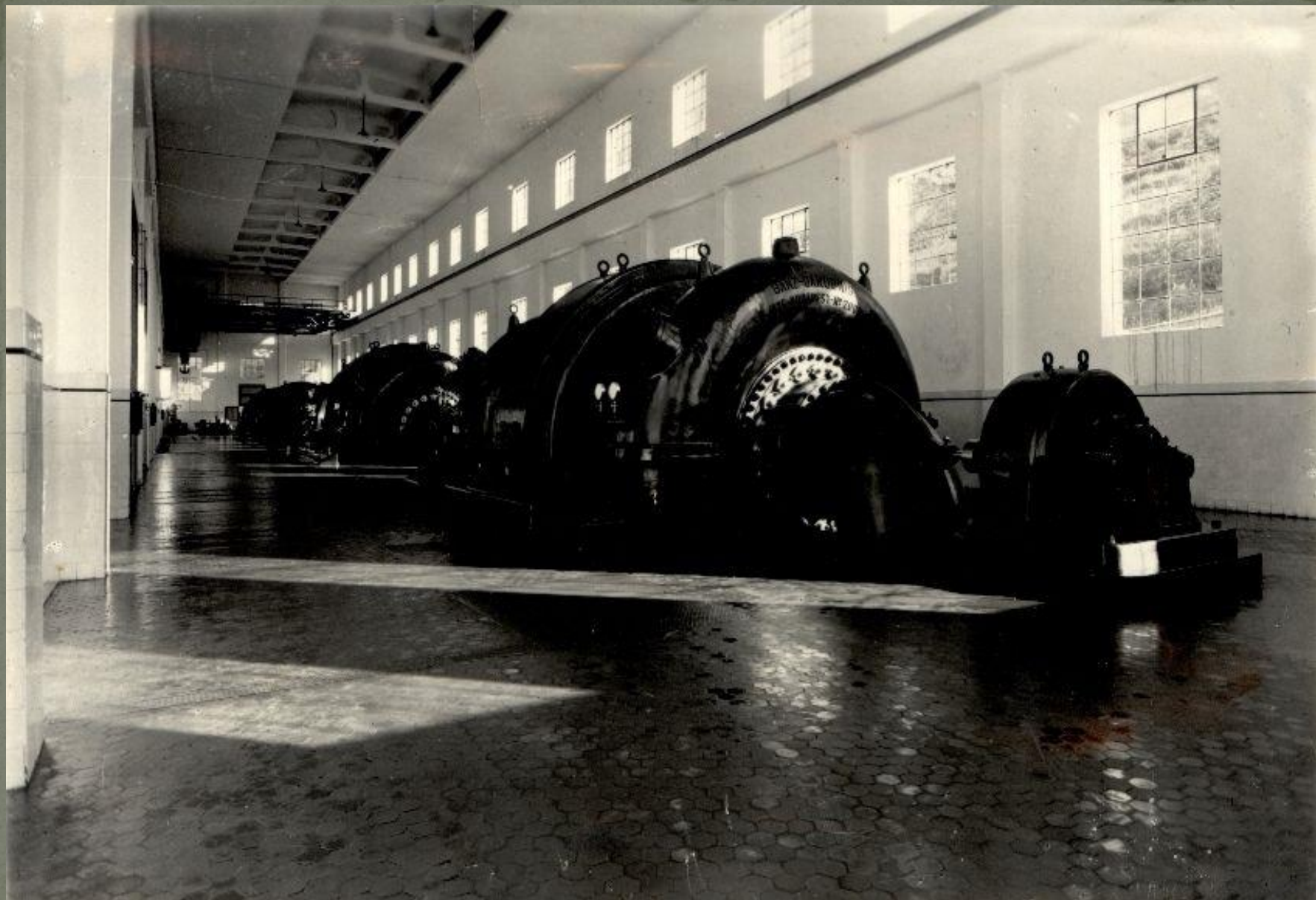
Završeni radovi montaže agregata
