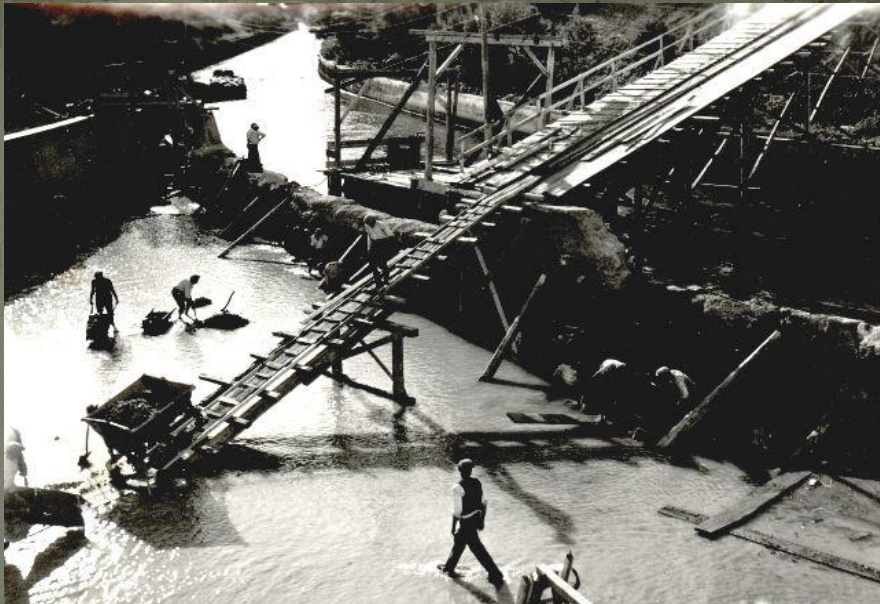
Radovi u odvodnom kanalu
