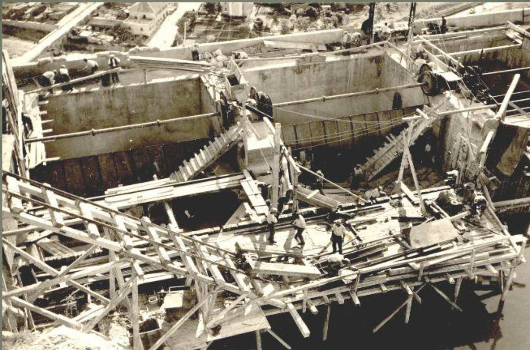
Radovi uređenja vodne komore druge etape
