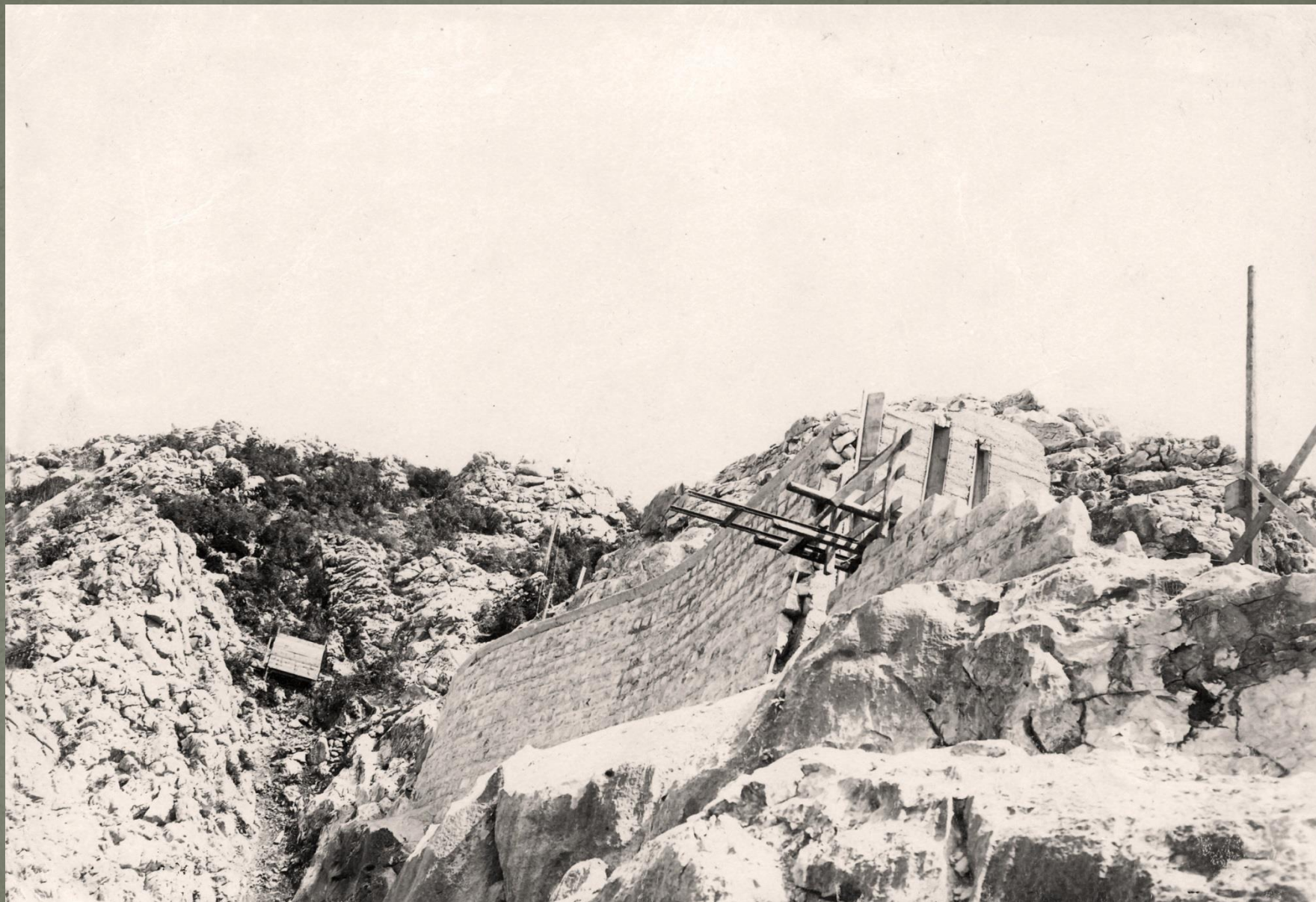
Izgradnja preljevnog zida vodne komore
