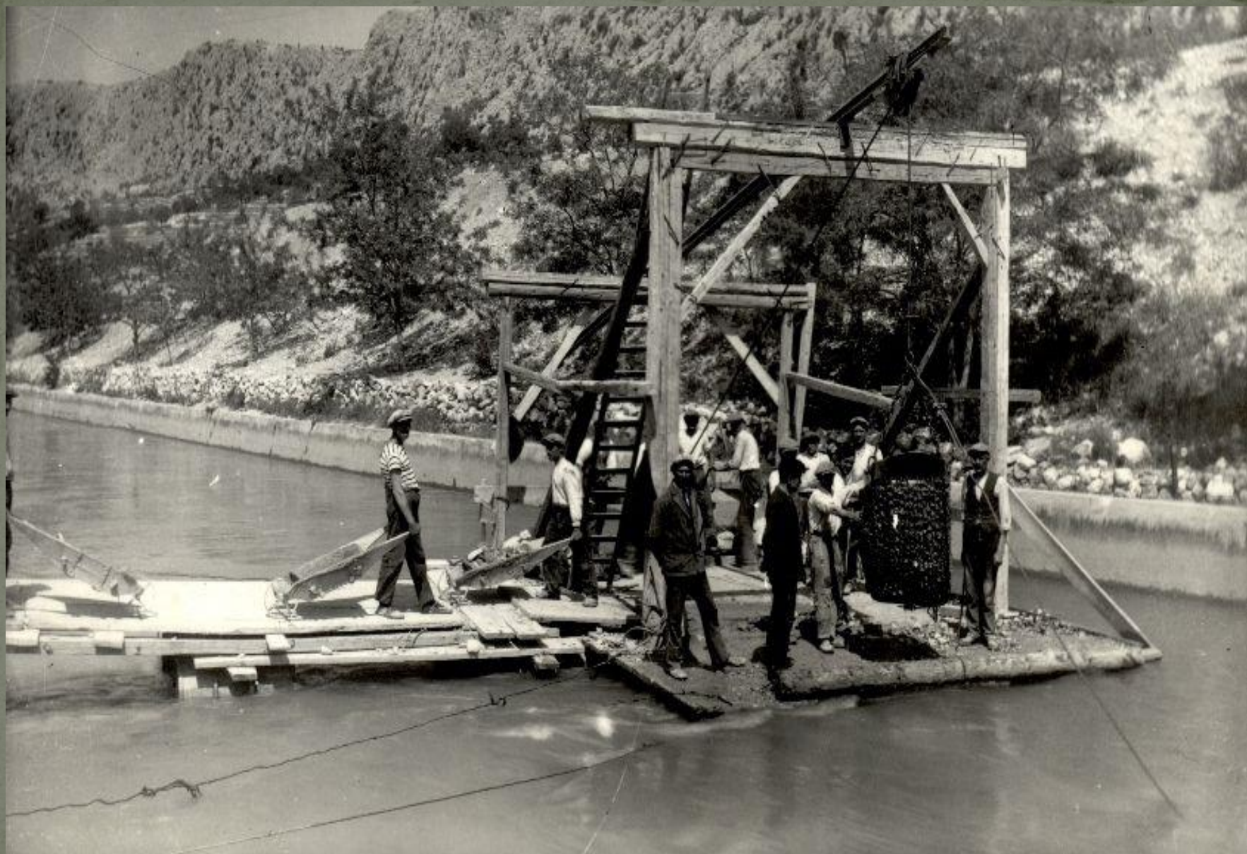
Radovi u odvodnom kanalu
