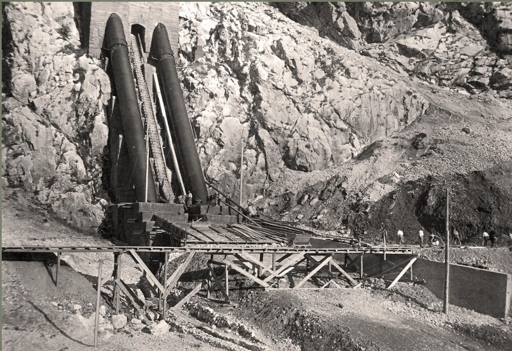
Radovi na izgradnji prva dva tlačna cjevovoda
