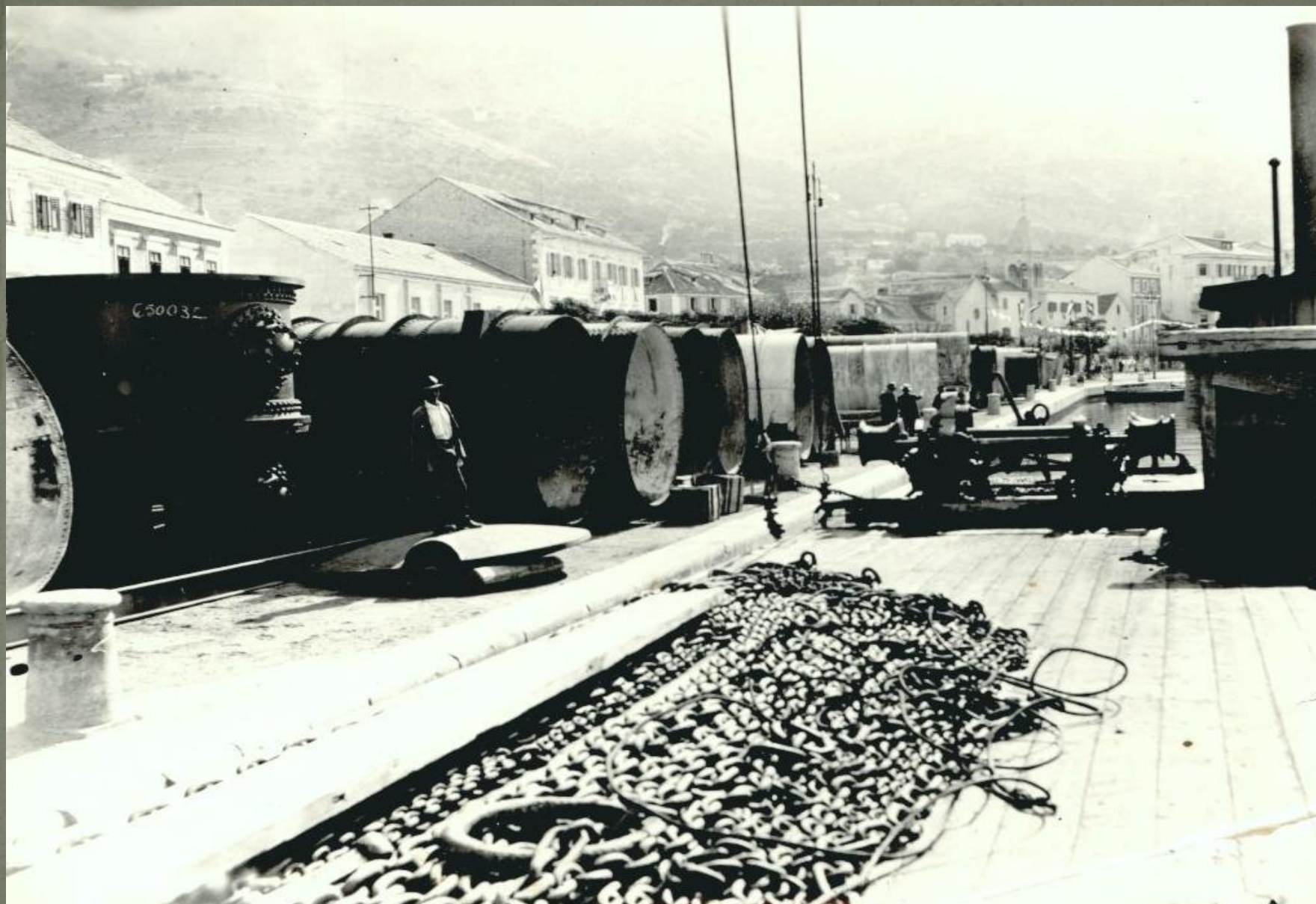
Dijelovi tlačnih cjevovoda u luci Makarska
