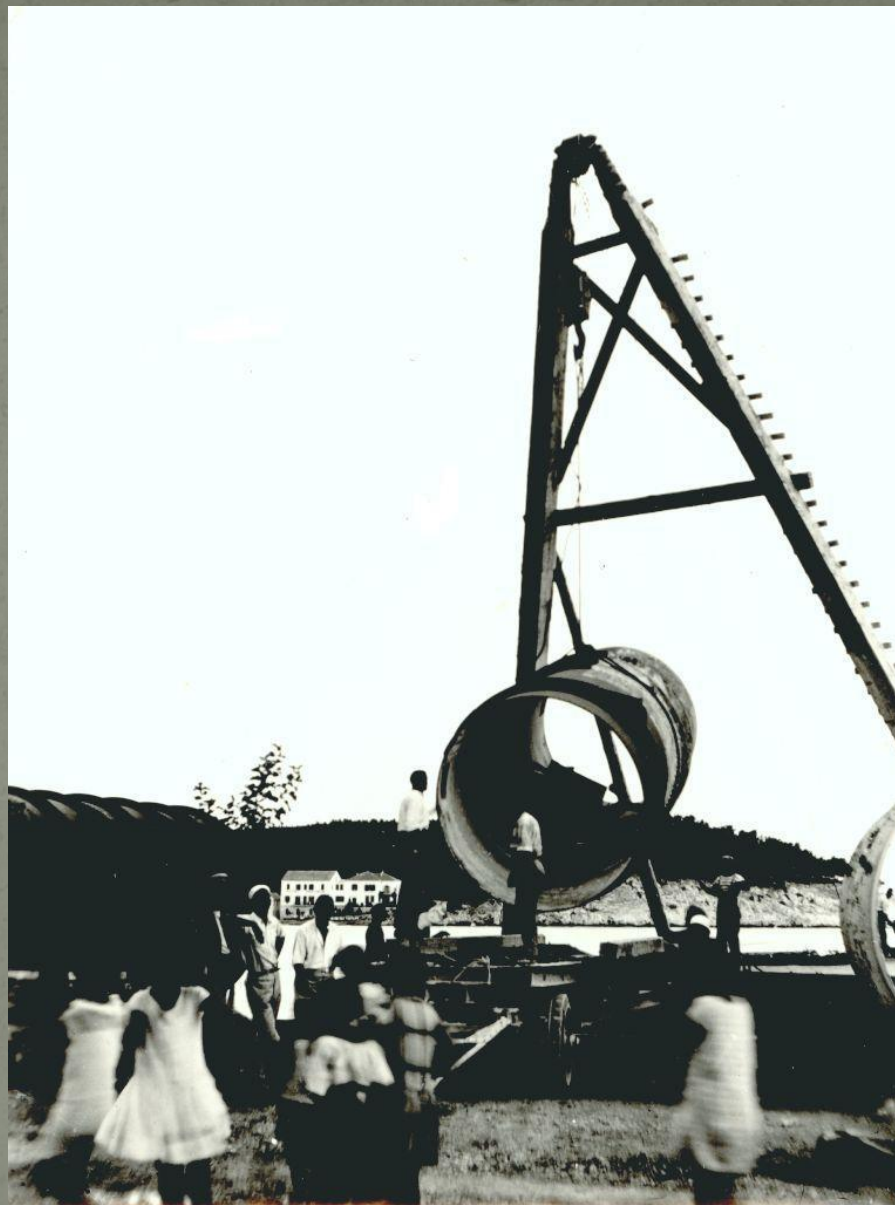
Iskrcaj dijelova tlačnih cjevovoda u Makarskoj
