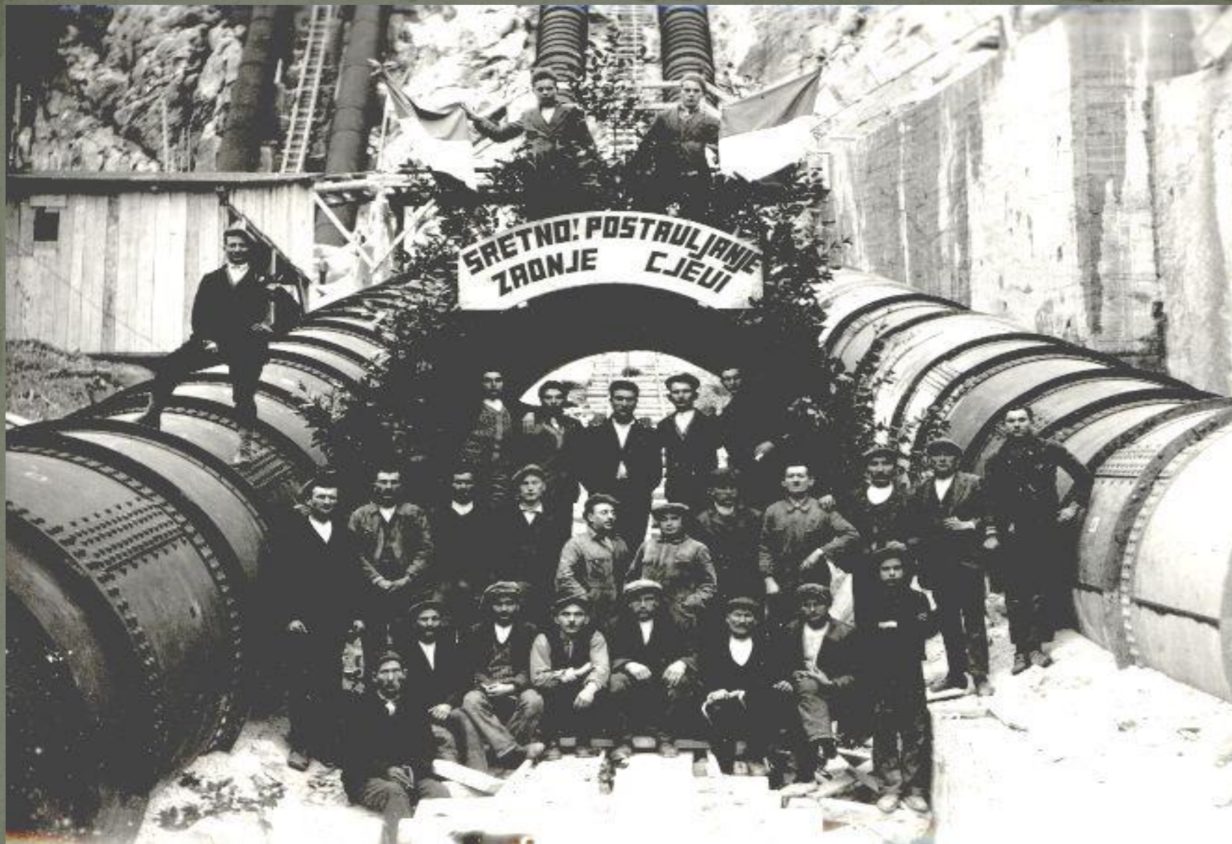
Završetak radova na izgradnji tlačnih cjevovoda 3 i 4
