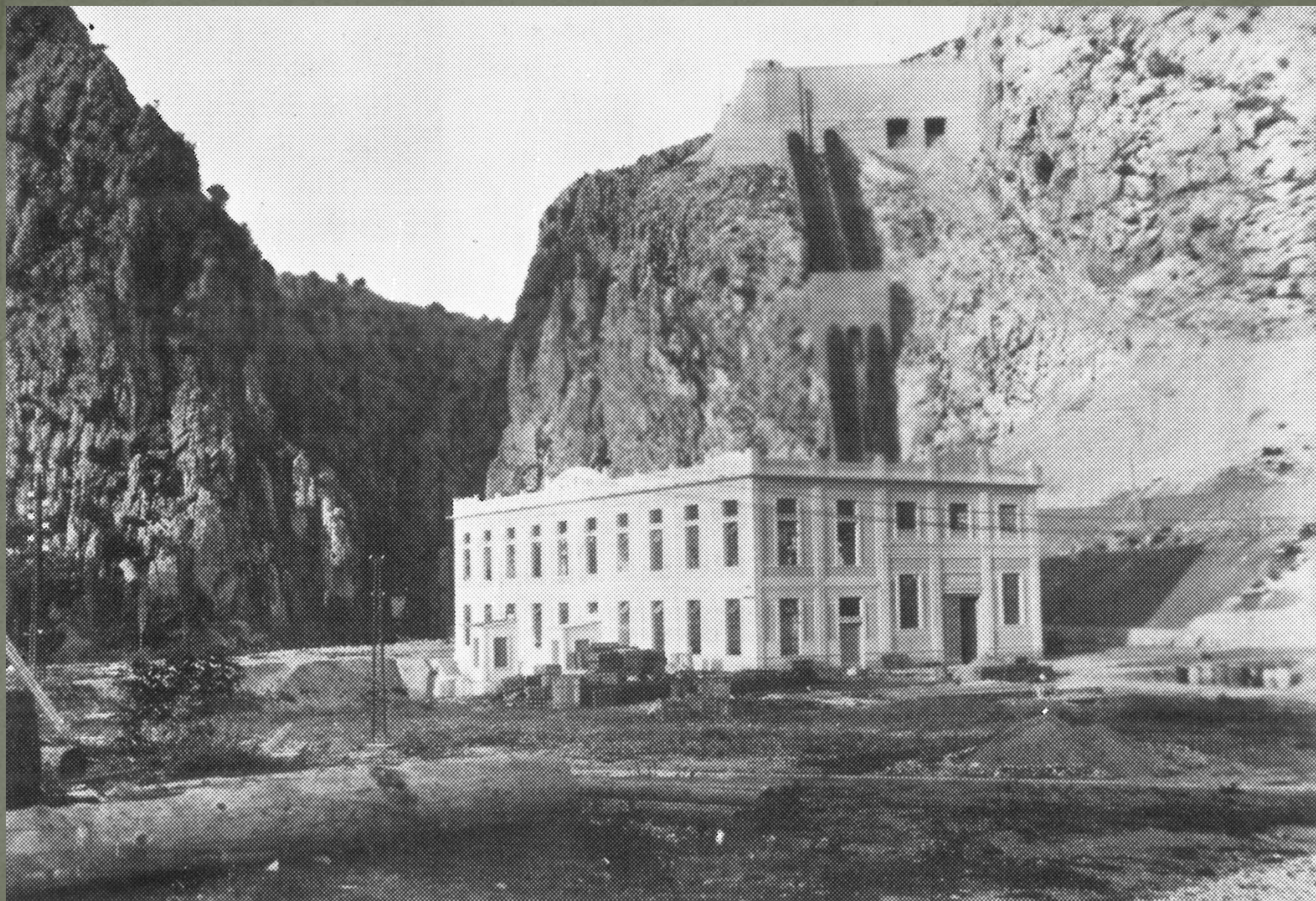
Završeni radovi prve faze izgradnje
