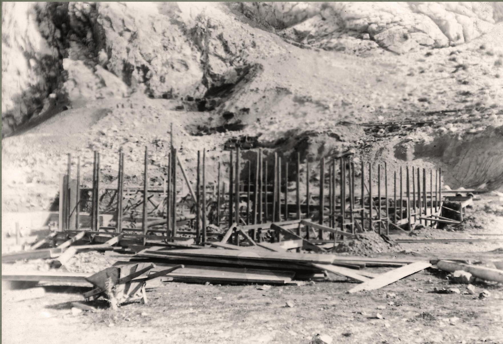
Početak radova na izgradnji strojarnice
