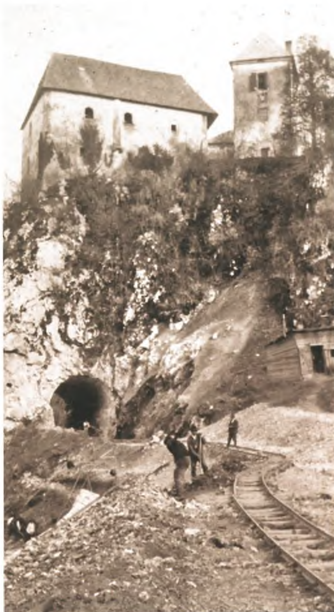
Gradnja pruge - ispod grada Ozlja prokopan je tunel
