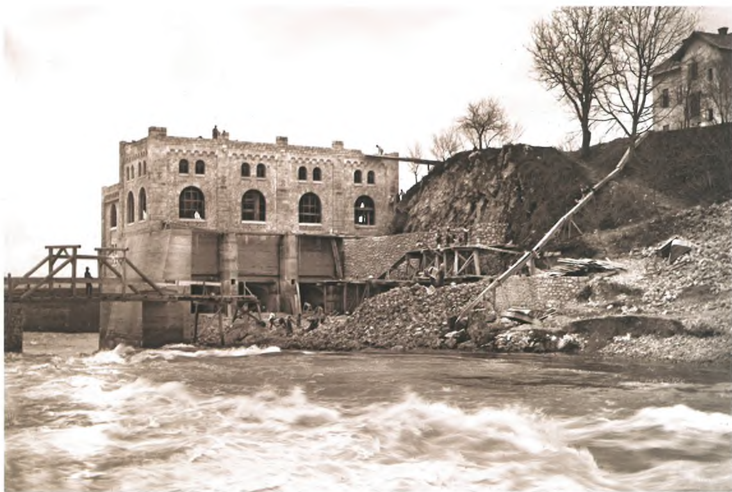
Munjara grada Karlovca tijekom izgradnje
