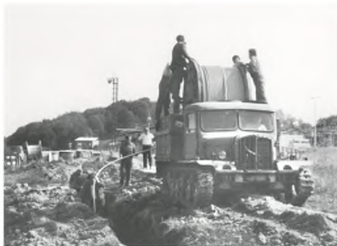
Polaganje kabela 35 kV za transformatorsku stanicu Tušmer u Dugoj Resi
