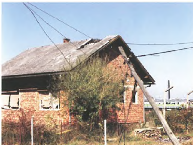
Uništene kuće i elektroenergetska mreža u Popović Brdu
