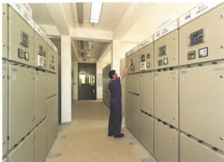
Postrojenje 35 i 10 (20) kV u transformatorskoj stanici Generalski Stol
