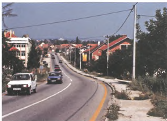
... i nakon obnove
