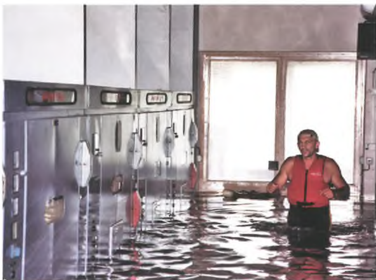
Za poplave 1999. godine - obnova uništenih vanjskih i unutrašnjih postrojenja transformatorske stanice 35/10 kV Ogulin dodatno je pogurala uvođenje daljinskog upravljanja
