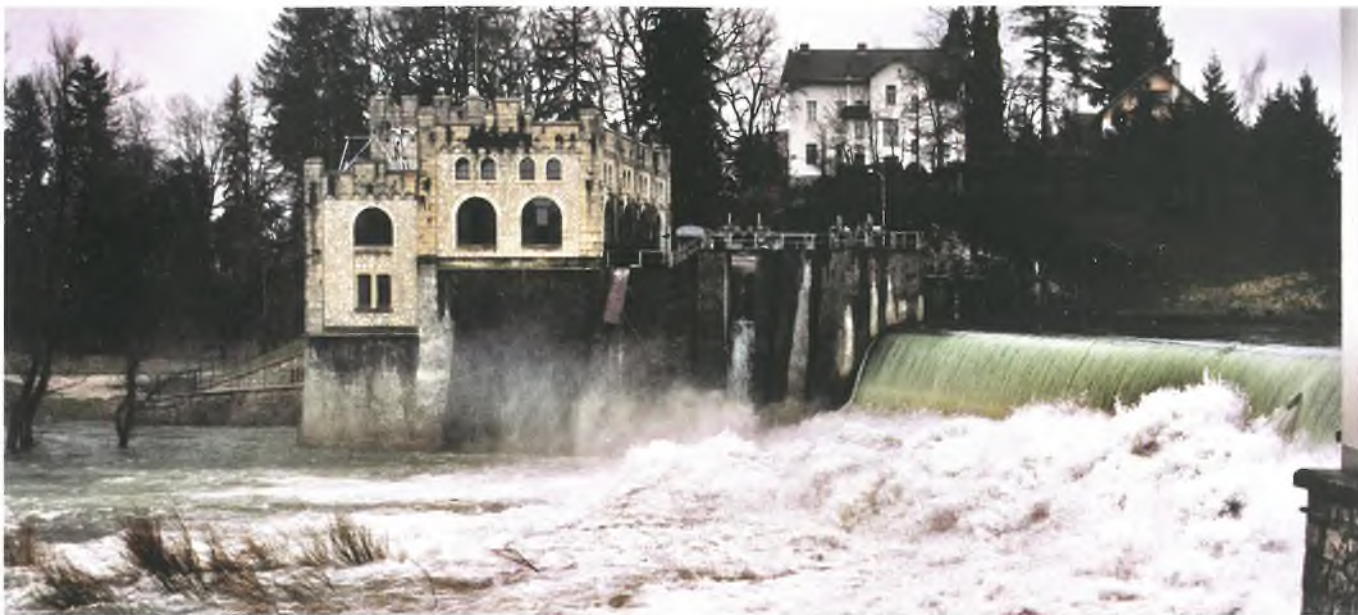
Hidroelektrana Ozalj kod preljeva od 200 prostornih metara u sekundi
