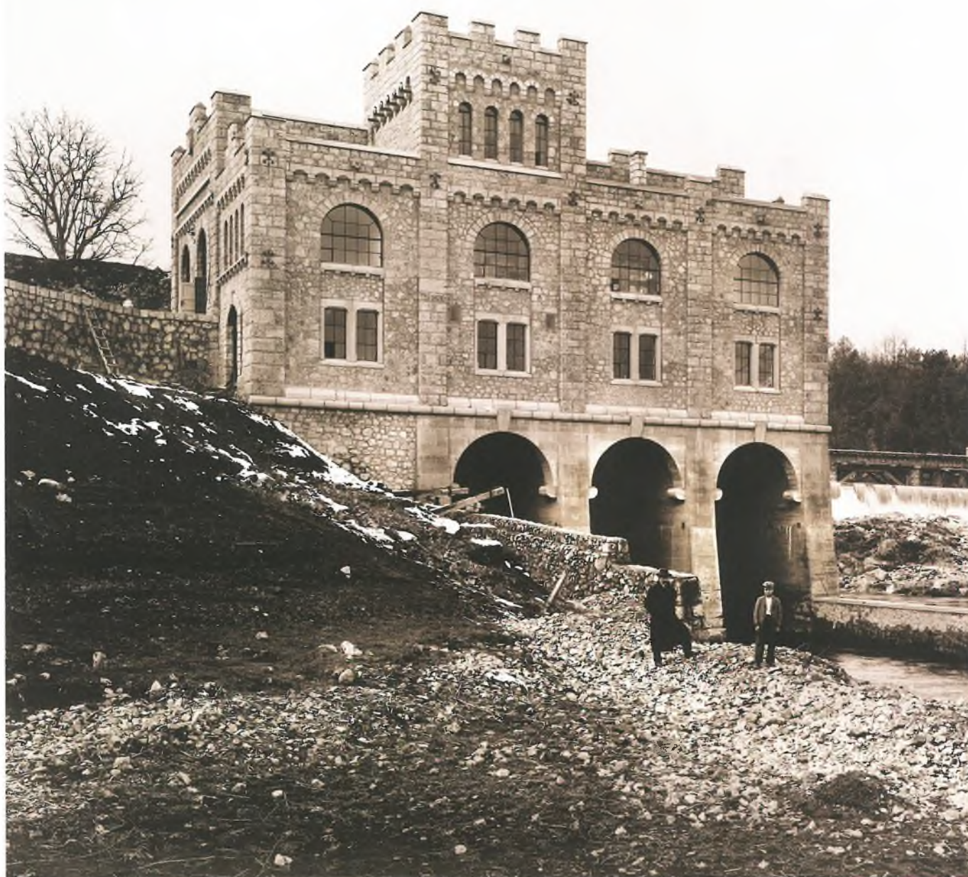
Građevno-arhitektonski objekt hidroelektrane u neoklasicističkom stilu izveden je kao kameni objekt s krunasto nazubljenim ukrasima i skladnim arkadama na vrhu
