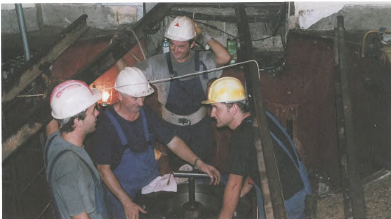
Zaposlenici Hidroelektrane Ozalj prigodom remonta postrojenja agregata 4
