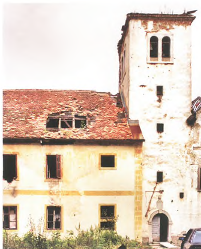
Zapušten i oštećen Pavlini samostan u Kamenskom iz 1404. godine (snimljen 1995. iza Oluje ) i ...
