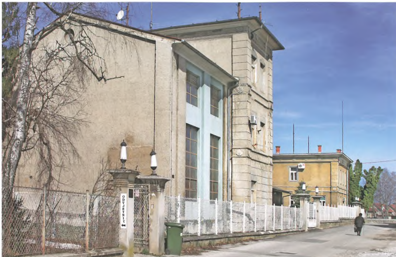
Transformatorska stanica 35/10 kV Dubovac naslijedila je, ne samo ime, već i prostor negdašnje Kalorične (dizelske) centrale Dubovac
