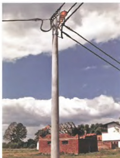
Obnovljena mreža s javnom rasvjetom, koja je u svibnju 1997. zasvijetlila u Ribarima
