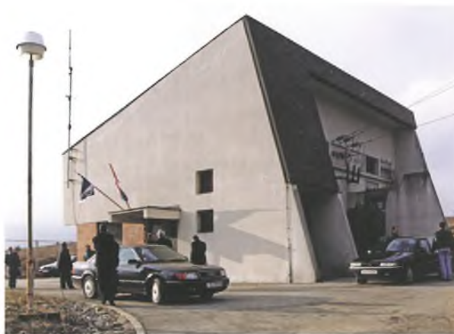
Transformatorska stanica Plaški 1997. godine, nakon polaganja 35kV kabela Oštarije - Plaški
