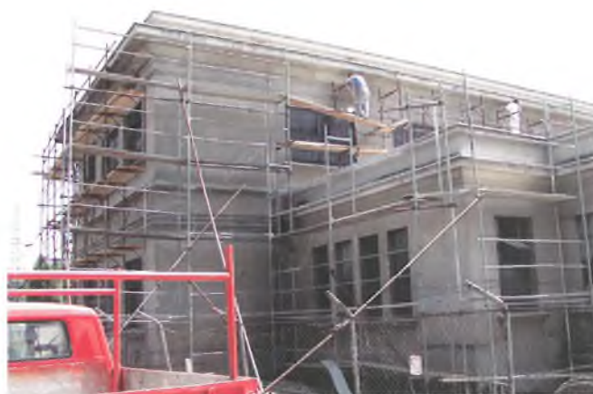
Transformatorska stanica 35/10 kV Ilovac tijekom rekonstrukcije
