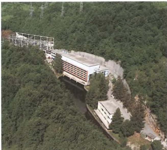
Hidroelektrana Gojak, vršne snage 48 MW, snažniji i vrijedan izvor za Karlovačko područje
