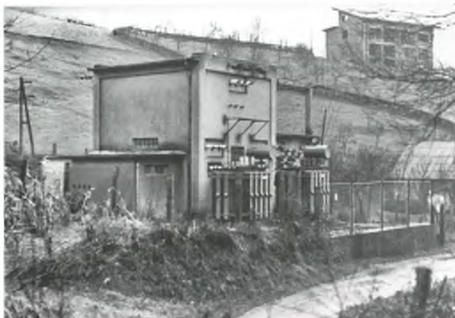
Stara transformatorska stanica 35/10 kV Tušmer u Dugoj Resi
