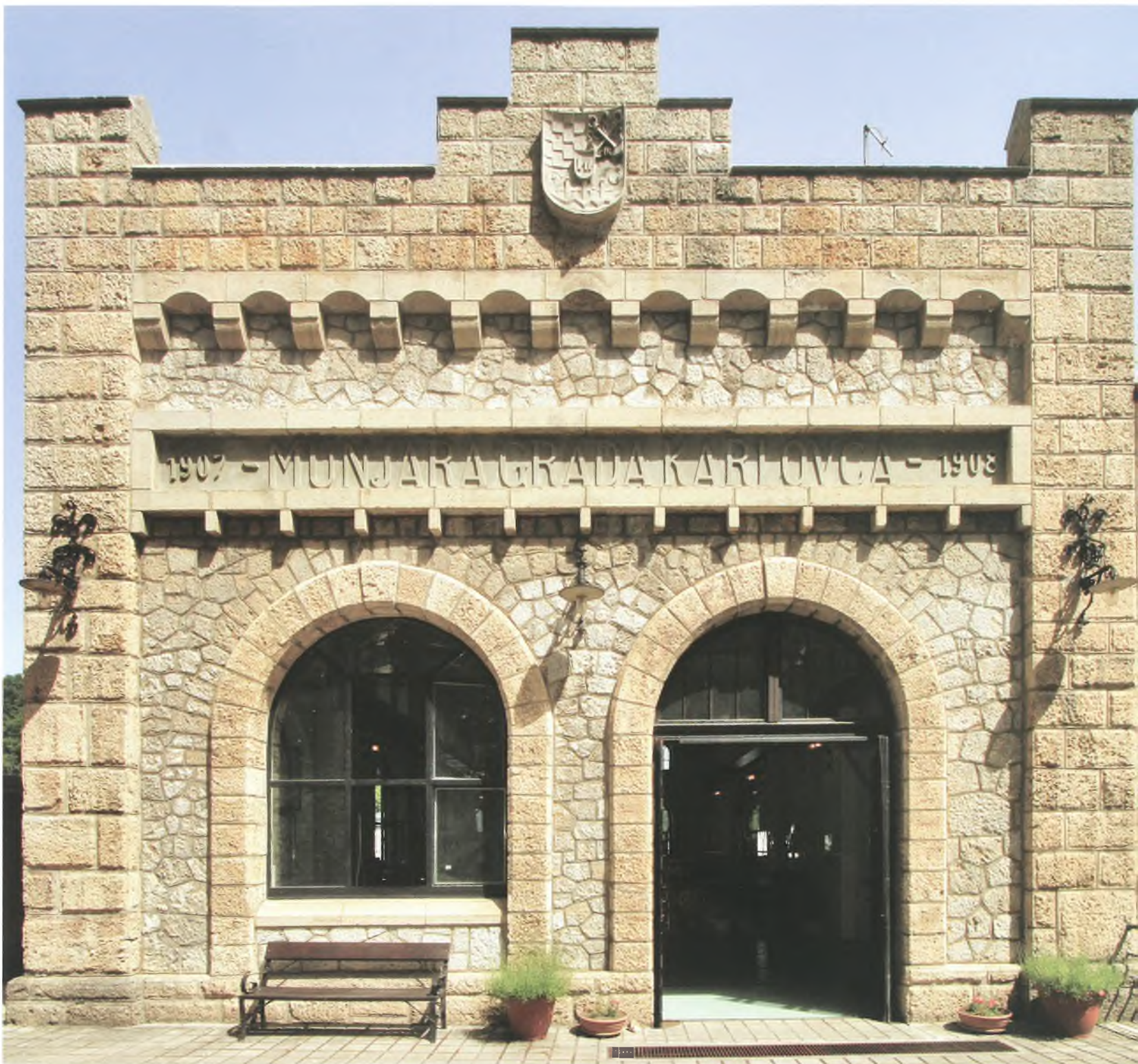
Pročelje i pogonska zgrade Hidroelektrane Ozalj lijepi je primjer industrijske arhitekture s početka 20. stoljeća
