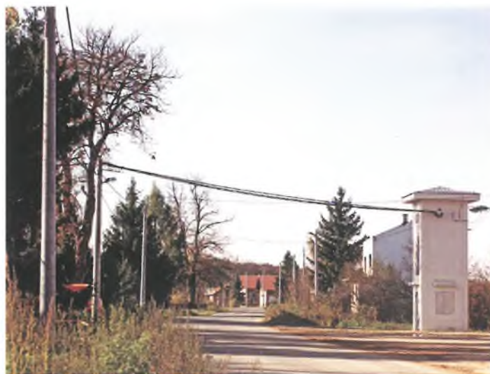
... prva obnovljena transformatorska stanica (tornjić) Lasinja (studenj 1996.)
