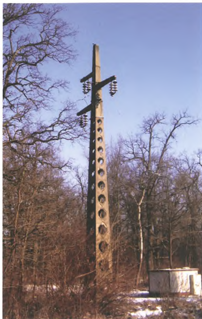
Armirano-betonski stup negdašnjeg dalekovoda 30 kV Zagreb- Karlovac, izgrađen tridesetih godina prošlog stoljeća - danas svjedok povijesti
