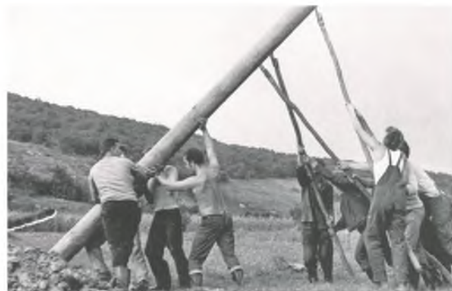
U vrijeme intenzivne elektrifikacije zaposlenici Elektre Karlovac stupove su dizali ručno
