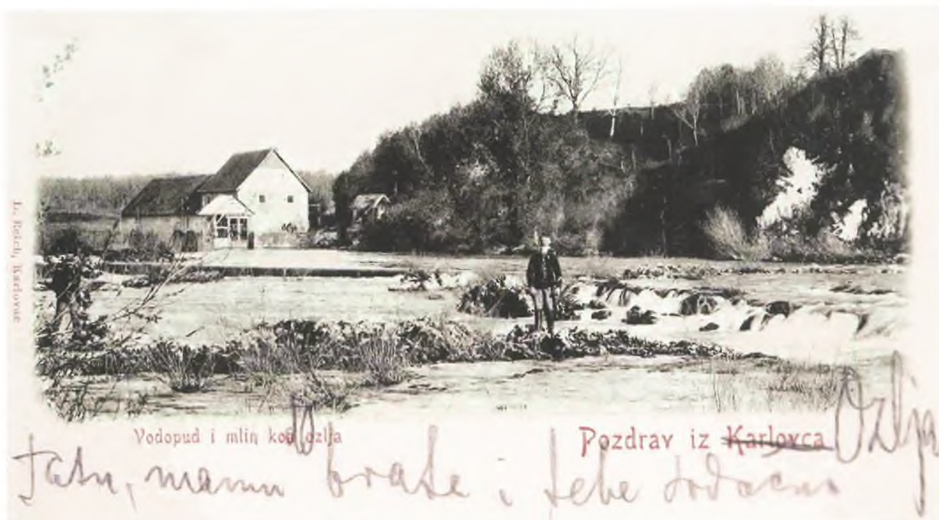
Mlin na rijeci Kupi kod Ozlja, vlasnika Alberta Thurna i Taxisa, bio je najpovoljnija lokacija za izgradnju hidroelektrane, temeljem podataka Ljudevita pl. Bogdana o njenom vodostaju i hidropotencijalu kojeg je pratio tijekom 15 godina
