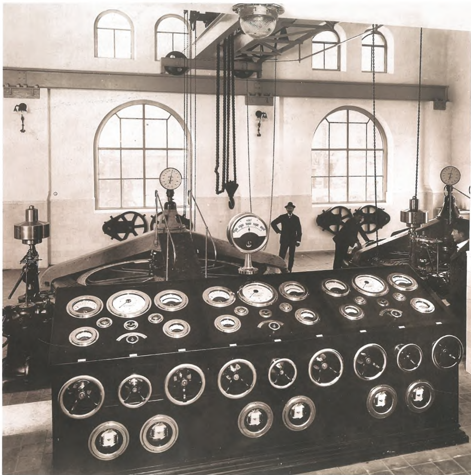
Strojarnica Munjare grada Karlovca
