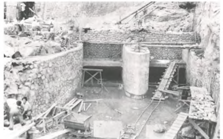
Izgradnja gravitacijske brane
