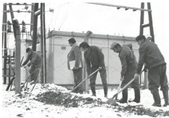
Izgradnja privremene transformatorske stanice 35/10 kV Novi Centar
