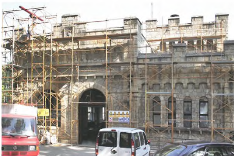
U suradnji s Upravom za zaštitu kulturne baštine obnovljena je građevina strojarnice Hidroelektrane Ozalj I. prvi put u 100 godina!
