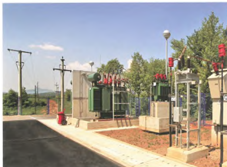
Postrojenje 35 i 10 (20) kV u transformatorskoj stanici Generalski Stol
