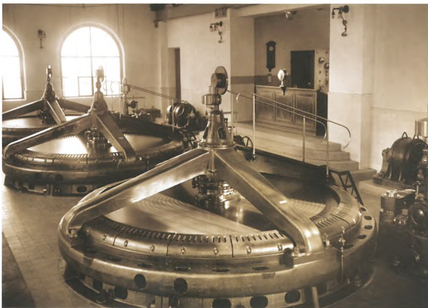
Strojarnica Munjare nakon ugrađenog trećeg agregata
