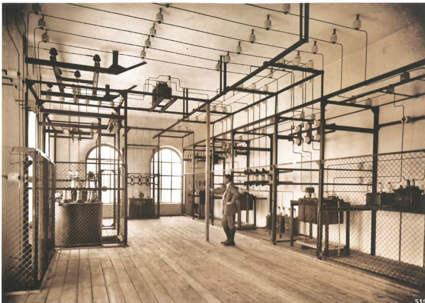
Rasklopište 20 kV dizelske centrale Dubovac
