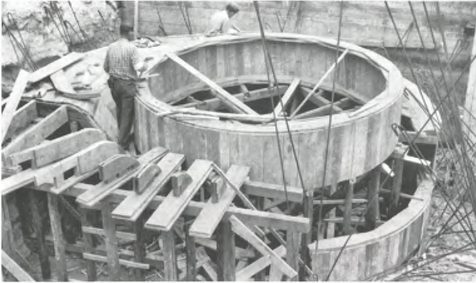
Izgradnja strojarnice Hidroelektrane Ozalj II.
