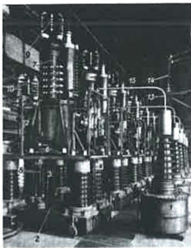
Abb. 178. Stromrichterhaus der Anlage Moabit der RAV. 1 Isolierumpanzer, 2 Kühltank, 3 Öffnungsrohr für Anodenöl, 4 Öffnungsrohr für Kathodenöl, 5 Kopplungskondensatoren, 6 Kathodenstrom, 7 Anode, 8 Kondensatorbatterie, 9 Anodenstrom, 10 Zwickelstrom, 11 Pumpenraum, 12 Verteilung.
