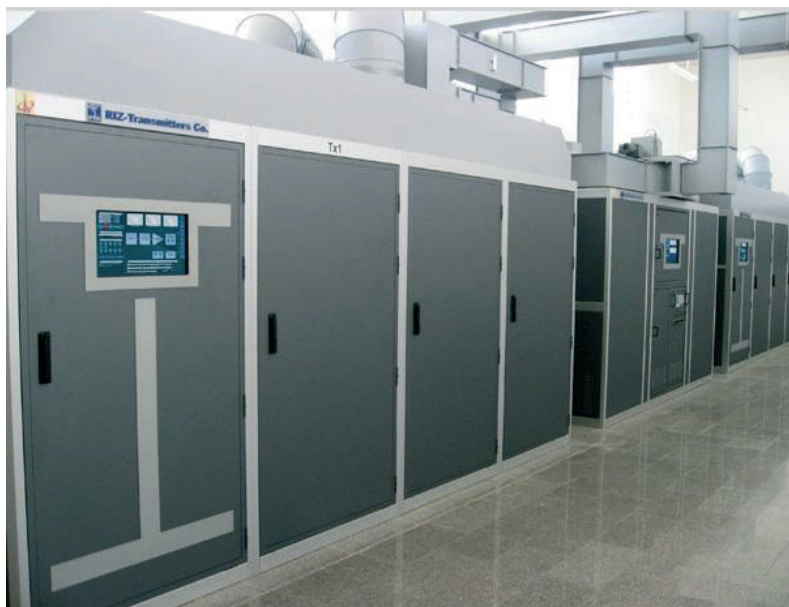
Sl. 14.: RIZ-ov srednjovalni odašiljač snage 2 \times 300 kW
