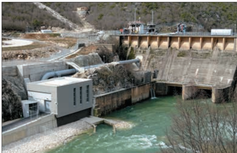
Slika 13. Mala hidroelektrana Prančevići, instalirane snage 1,6 MVA, među prvima je takvog tipa elektrana priključenih na distribucijsku mrežu. Priključena je 2016. u vodno polje 20(10) kV u TS 35/10 kV Prančevići, predviđive proizvodnje 9000 MWh. Elektrana će svojom snagom uvelike pomoći napajanju potrošača na području zaselaka omiške i sinjske zagore. U elektranu je ugrađena horizontalna turbina tipa „Francis” i sinkroni generator nazivne snage 1,6 MVA.
