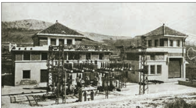
Slika 5. Vanjsko postrojenje „Transformatorske stanice Dujmovača”, arhitekta Josipa Kodla, koja je 1927. postala novo srce elektrifikacije šireg splitskog područja. Mudro su i s velikom pažnjom ondašnji stručnjaci izabrali upravo ovaj lokalitet za gradnju zdanja koje je trebalo primiti energiju dalekovodom iz Dugog Rata, a opet ga je trebalo smjestiti dovoljno blizu svim budućim korisnicima, kako onima u priobalju od Podstrane do Trogira, tako i onima iza Klisa, jer pregovaralo se već tada i s Dugopoljem i drugim selima Zagore, pri tome izbjegavajući skupa i teška križanja s glavnim cestama Split – Omiš i Split – Solin.
