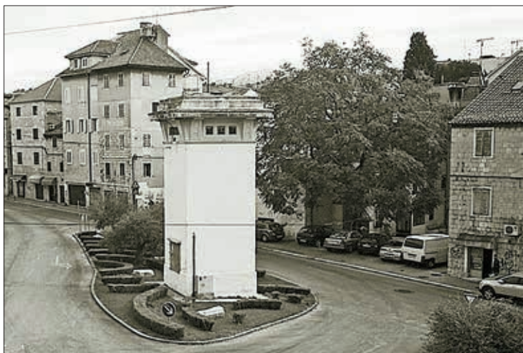
Slika 3. Prva transformatorska stanica na Manuškoj poljani, puštena u rad 15. srpnja 1920. kada je u 21 sat zasvijetlila Riva. Prijenos električne energije od Majdana do prve transformatorske stanice u gradu na Manuškoj poljani 10/0,2 kV (koja se i danas može vidjeti u originalnom izdanju) ostvaren je dalekovodom od 10 kV na drvenim stupovima u duljini od 6,5 km. Od Manuške poljane vodili su podzemni kabeli od 220 V do zgrade kazališta prema zapadu i do Hrvojeve kule prema jugoistoku.
