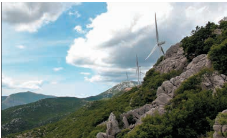
Slika 15. Vjetroelektrana Kom – Orjak – Greda priključena je 2018. na 35 kV sabirnice u TS 35/10 kV Kraljevac. U tu svrhu opremljeno je vodno polje 35 kV u transformatorskoj stanici kao mjesto prihvata 13 km dugog kabela od lokacije vjetroelektrane. Vjetroelektrana se sastoji od pet vjetroatregata snage po 2 MW.
