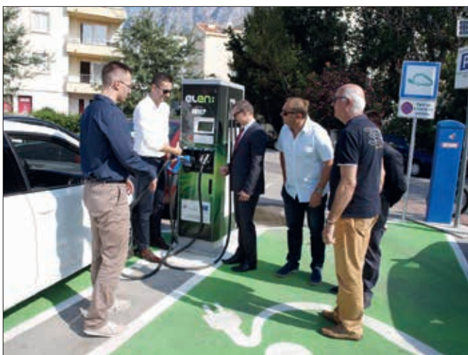
Slika 12. Puštanje u rad punionice za EV Makarska, 2019. U duhu novih vremena, ekološki osviještenih, „Elektrodalmacija” se kupnjom električnih službenih automobila, kao i izgradnjom punionica, uključila u promociju i podizanje svijesti o važnosti očuvanja okoliša kod građanstva. Kako tržište nad punjivim hibridnim električnim i električnim vozilima na baterije raste, povećava se potreba za sve većom javnom dostupnošću stanica za punjenje. Među takvim su „zelenim” punktovima i stanice za punjenje podignute na odmorištima uzduž autoceste A1 na području DP „Elektrodalmacije Split”, na području Terenskih jedinica Ploče, Makarska i Imotski te na srednjodalmatinskim otocima Brač, Hvar i Vis. U gradu Splitu izgrađene su do 2021. tri punionice elektrovozila (EV), a u pripremi je izgradnja nove 22 punionice.
