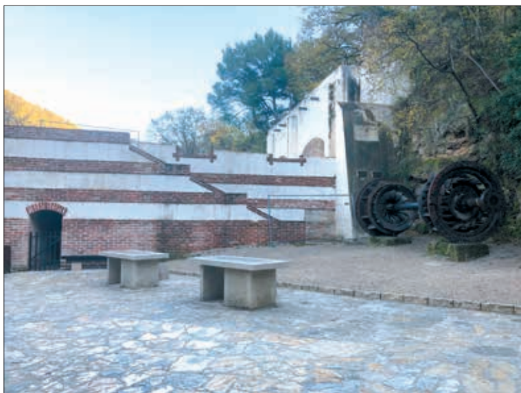
Slika 1. Hidroelektrana Krka Jaruga I., puštena u pogon 28. kolovoza 1895. (Foto: Hania Mladineo Mika)
