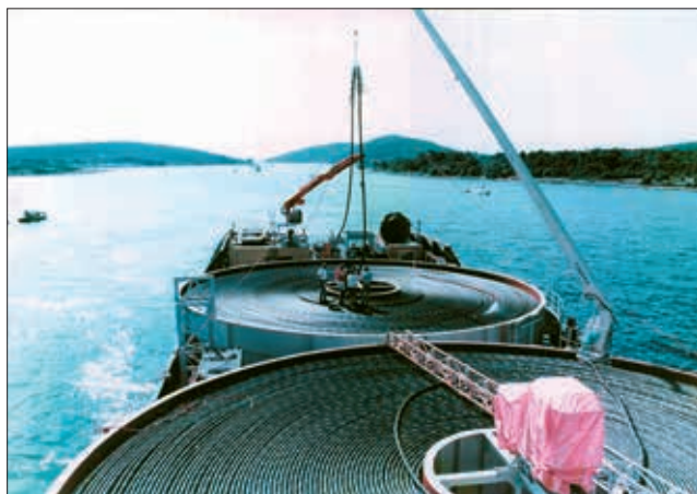
Slika 10. Povijesnim pothvatima tijekom Domovinskog rata – „Otočna veza 110 kV” 1994. (od TS 400/220/110 kV Melina na području Rijeke do TS 110/35 kV Zadar 1) i „Jadranski otoci 35 kV” 1995. (polaganje 100 km podmorskog kabla i 75 km kopnenog podzemnog kabla od Lošinja do Mljeta), elektroenergetska mreža hrvatske podignuta je na novu razinu.
