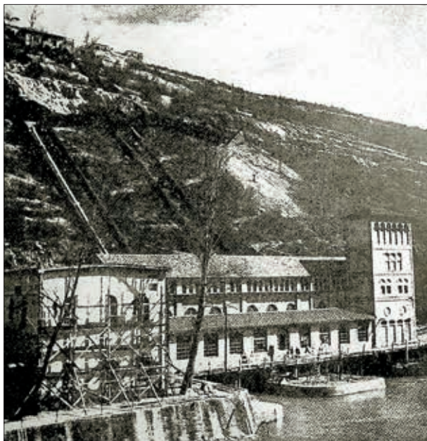
Slika 6. HE Manojlovac, pogonska zgrada i tlačni cjevovod. Preuzeto iz: B. Markovčić, I. Prpić, F. Plic, A. Busatto: Razvoj elektrifikacije Hrvatske, I. dio, od početka elektrifikacije do 1945. g., Zagreb 1984., 154.
