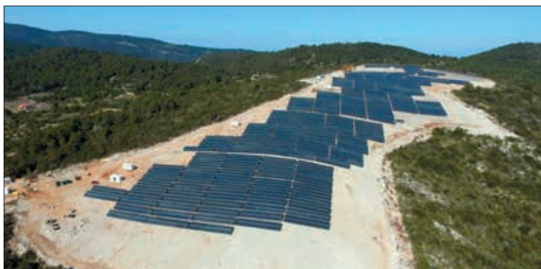
Slika 14. U rujnu 2020. u TS 35/10 kV Vis na 10 kV sabirnice priključena je i puštena u rad „Sunčana elektrana Vis” snage 3,5 MW koja će godišnje proizvesti oko 5 milijuna kWh električne energije, što odgovara potrošnji oko 1600 kućanstava. Ovo idealno rješenje najudaljenijem će od većih srednjodalmatinskih otoka osigurati veću sigurnost opskrbe električnom energijom, kako domicilnog stanovništva, tako i sve većeg broja turista. Ukupna vrijednost projekta bila je 31 milijun kuna, a sufinanciran je sredstvima Europske unije iz Europskog fonda za regionalni razvoj. „Sunčana elektrana Vis”, najveća sunčana elektrana u Hrvatskoj, izgrađena je na zemljištu površine 5,5 hektara na brdu Griževa glavica, na putu između gradova Visa i Komiže, u blizini naselja Žena Glava.
