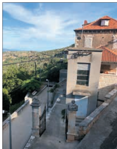
Slika 8. Trafostanica u Bobovišću na Moru (foto Hania Mladineo Mika)
