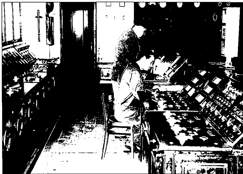
Upravljačnica električne centrale
